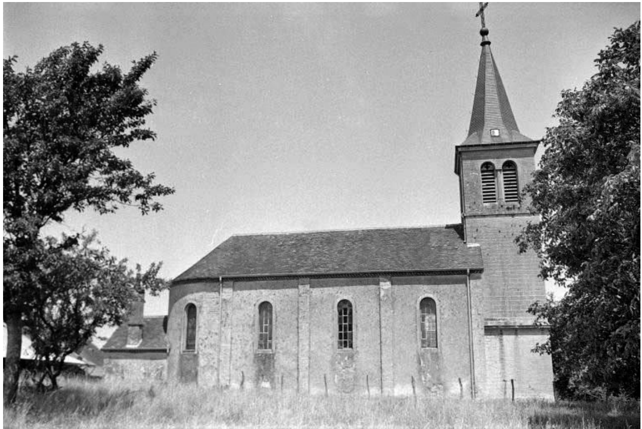
Façade latérale gauche : vue rapprochée.
