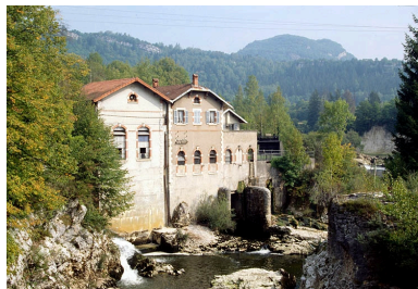
Façade sur la Bienne, depuis le pont. Phot. Laurent Poupard IVR43_19903900474ZA
