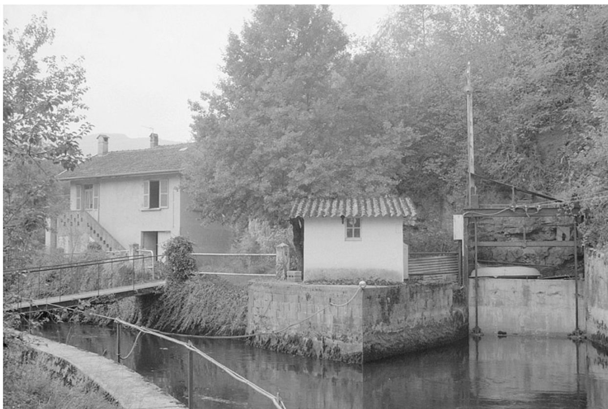
Bifurcation du canal d'amenée.
