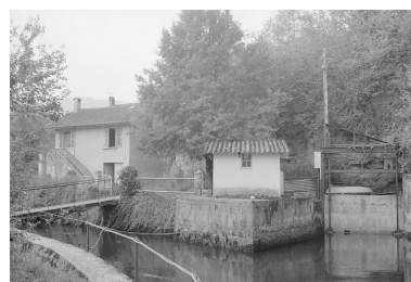
Bifurcation du canal d'amenée. Phot. Laurent Poupard IVR43_19903900479Z
