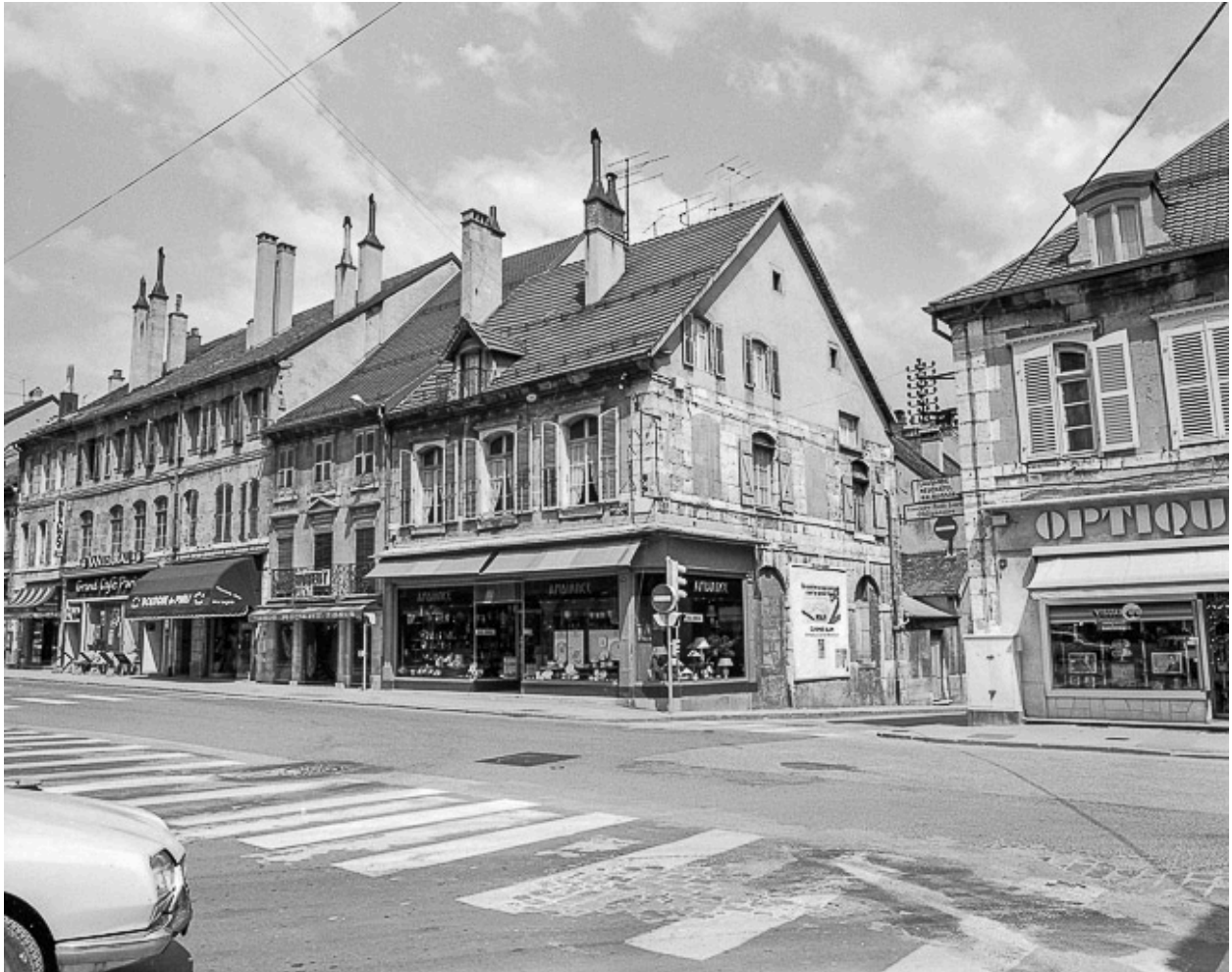
Maisons situées 16 à 22 rue de la République.
