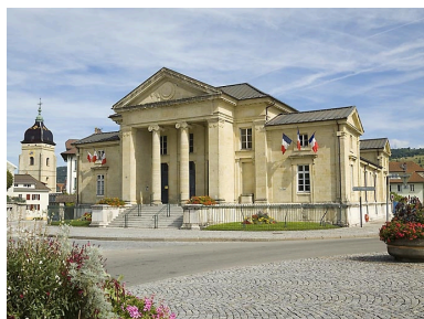
Tribunal situé place de la Gare. Phot. Jérôme Mongreville IVR43_20082500697NUC2A
