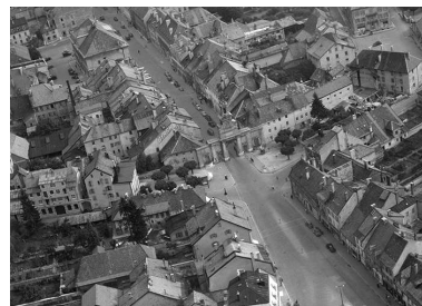
Rue de la République, rue du Faubourg Saint-Pierre, porte Saint-Pierre en 1956 Phot. Roger Henrard IVR43_19562500078N
