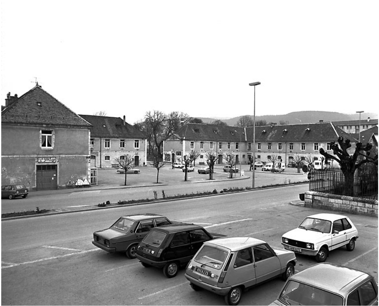
Caserne située place du Général Marguet.
