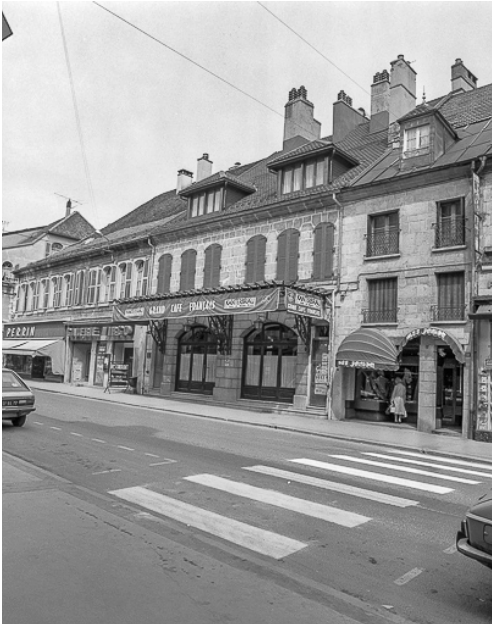
Maisons situées 34 à 38 rue de la République.
