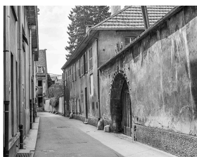
Maisons situées rue Parguez. Phot. Yves Sancey IVR43_19802500234X
