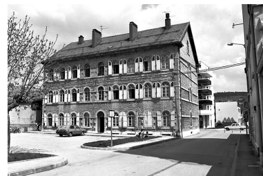
Caserne située place des Bernardines. Phot. Yves Sancey IVR43_19802500147X
