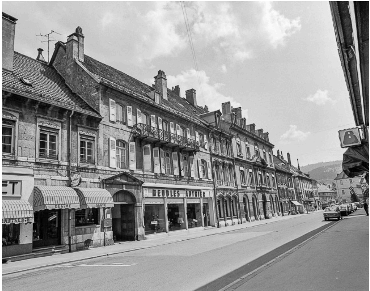
Maisons situées 2 à 12 rue de la République.
