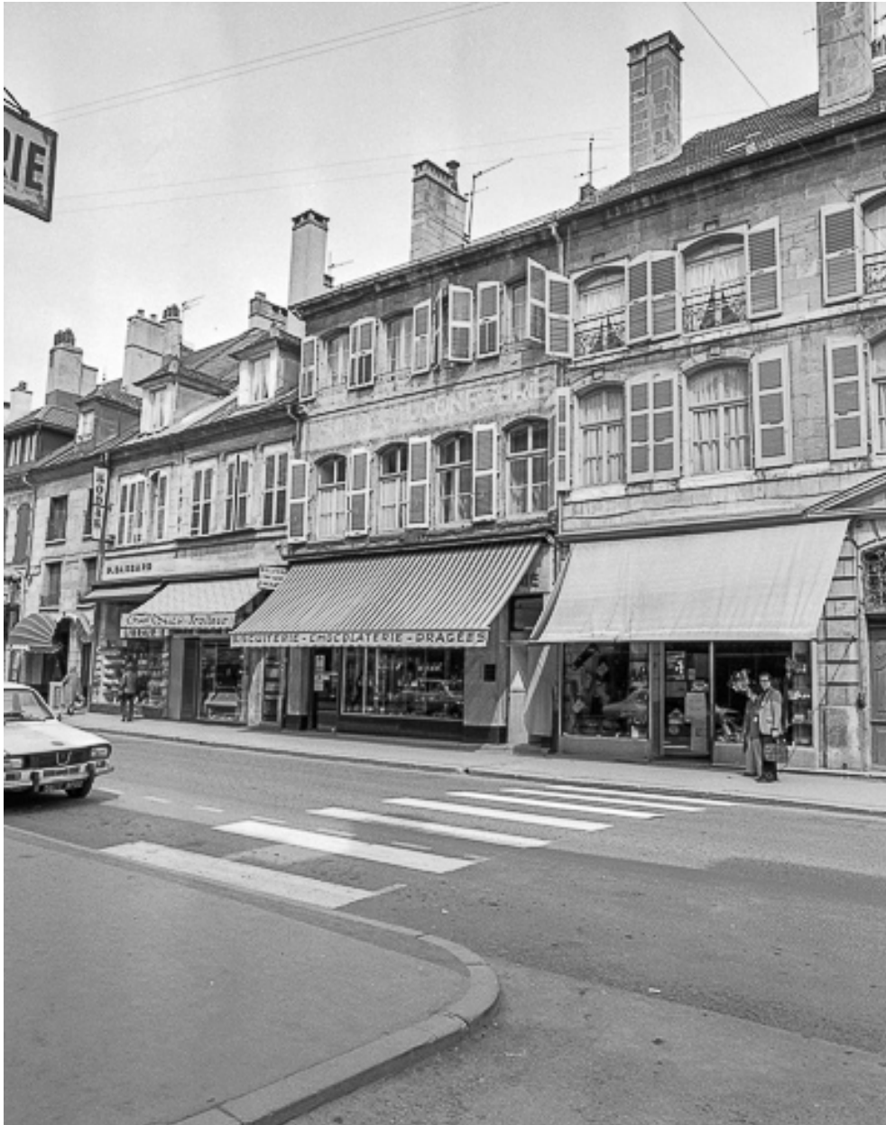
Maisons situées 28 à 34 rue de la République.
