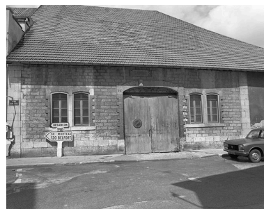
Lavoir situé rue Jeanne d'Arc. Phot. Yves Sancey IVR43_19802500165X
