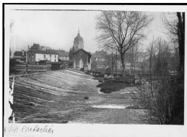
Maisons et clocher de l'église Saint-Bénigne vus depuis la rive droite du Doubs. Autr. Jules Manias IVR43_20062501000PY
