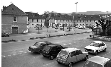
Caserne située place du Général Marguet. Phot. Yves Sancey IVR43_19802500141X
