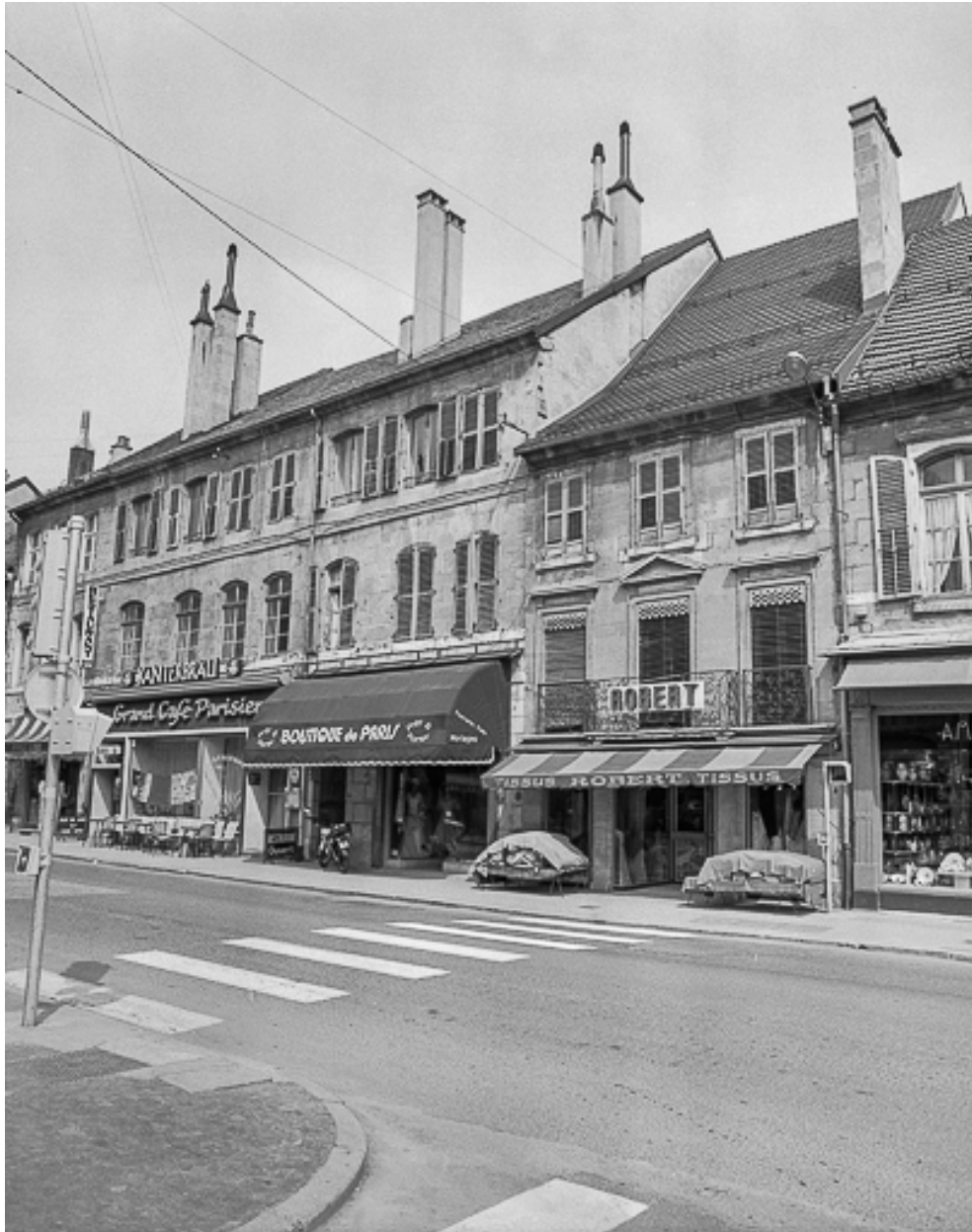
Maisons situées 18 à 22 rue de la République.
