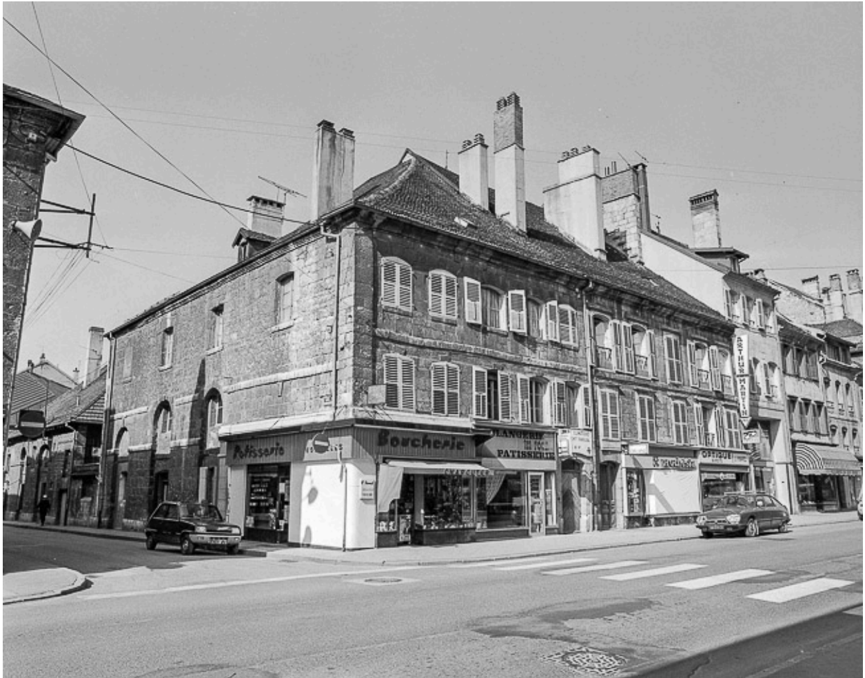
Maisons situées 5 à 11 rue de la République.
