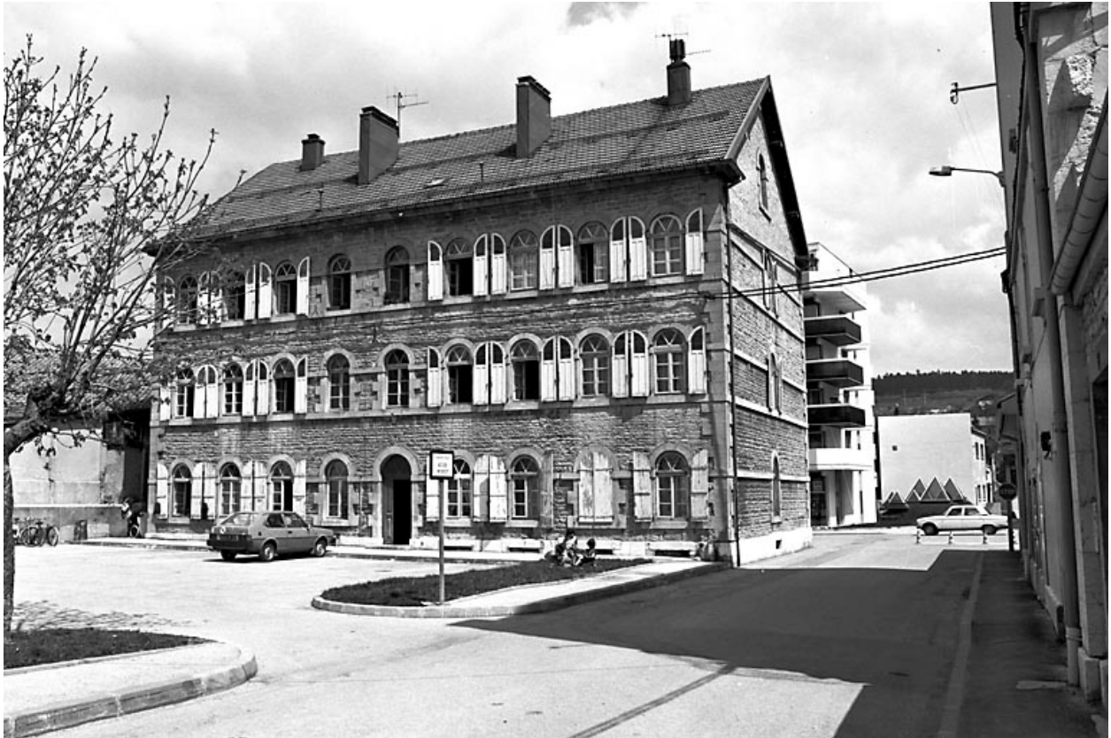
Caserne située place des Bernardines.
