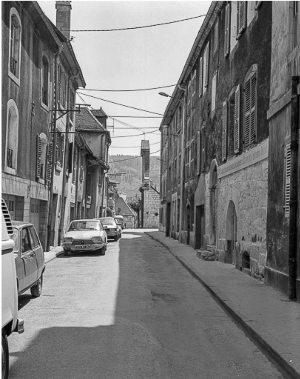
Place Saint-Bénigne. Portail, à l'extrémité de la rue Gambetta.
