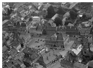
L'hôtel de ville situé rue de la République en 1956. Phot. Roger Henrard IVR43_19562500076N
