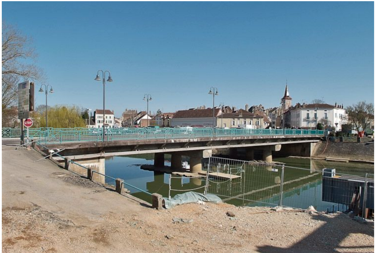
Pont routier sur la Seille, vue d'aval.
