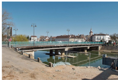
Pont routier sur la Seille, vue d'aval.
