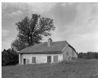
Façade antérieure. Phot. Jérôme Mongreville IVR43_19963901324X
