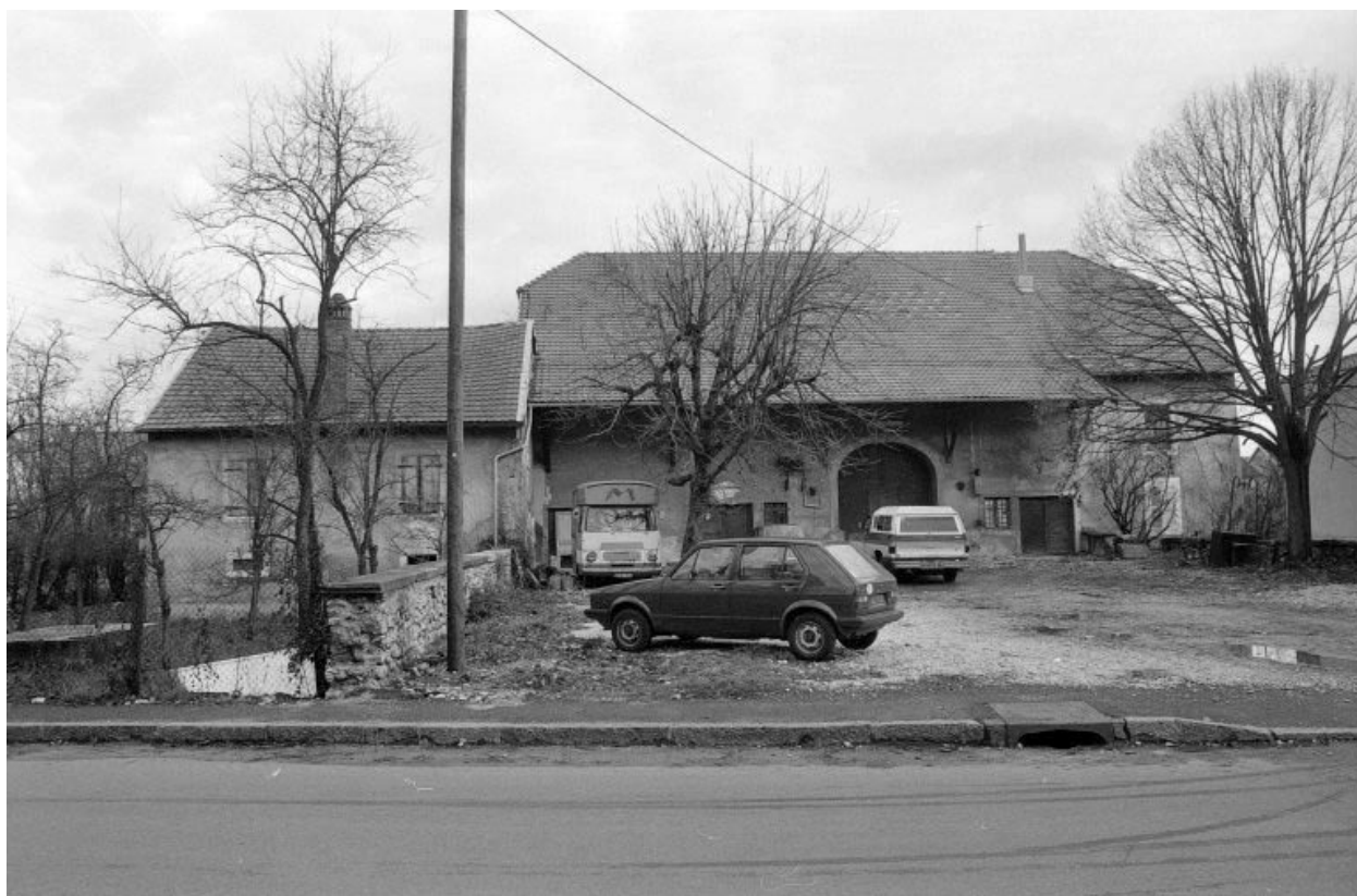
Audincourt : ferme située 9 rue de Valentigney.
