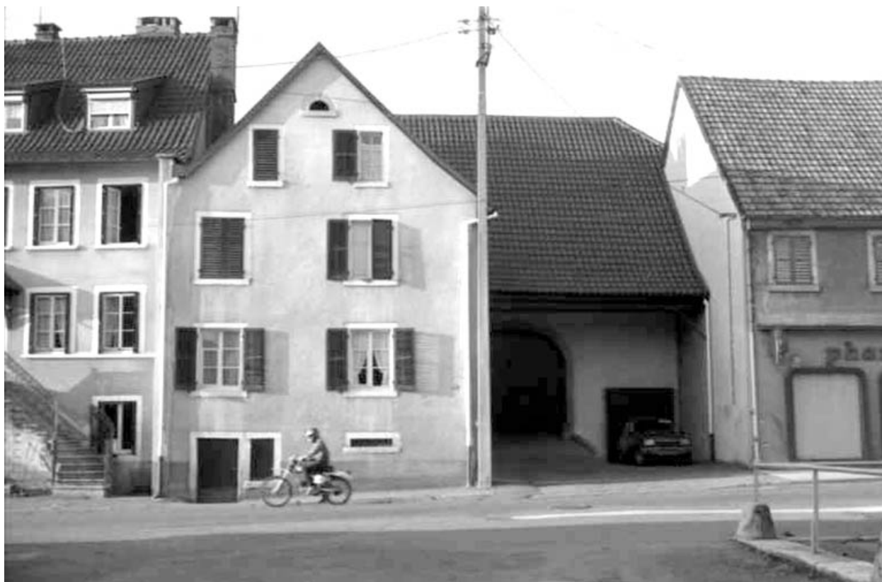
Dasle : ferme située rue Centrale.
