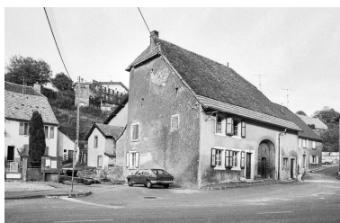
Arbouans : ferme située rue du Château d'Eau. Phot. Bernard Lardière IVR43_19832500058Z
