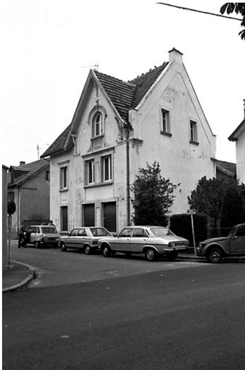
Audincourt : maison située 9 rue des Maréchaux.
