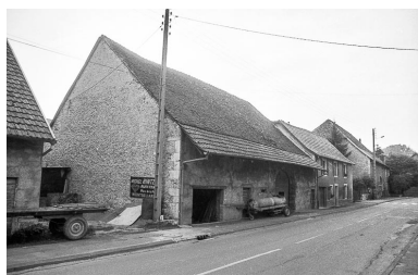
Arbouans : ferme située 5 rue de Courcelles. Phot. Bernard Lardière IVR43_19832500060Z
