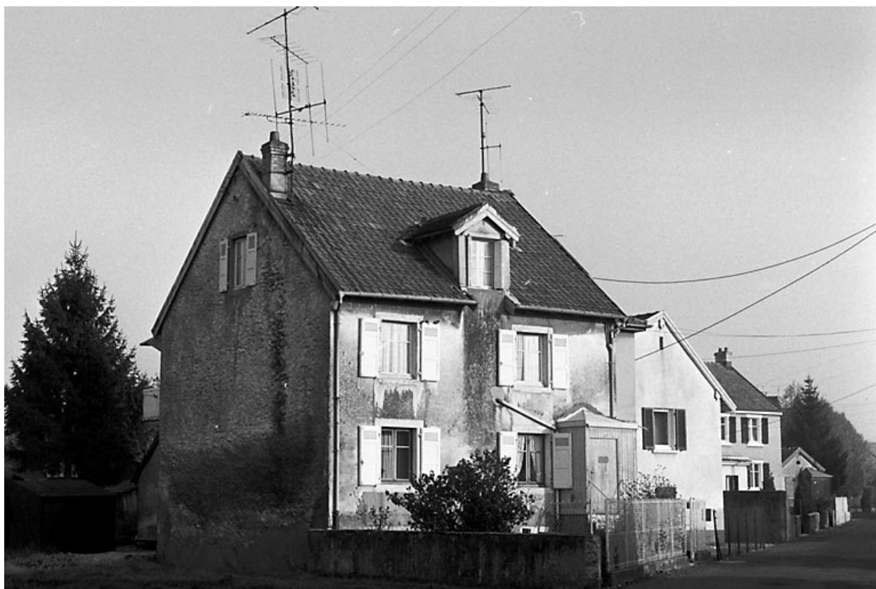
Audincourt : maison située 42 rue de Champagne.
