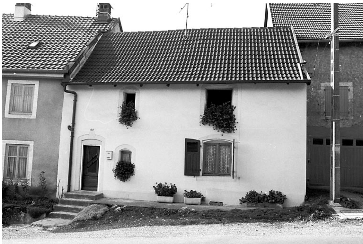
Dasle : maison située rue de Dampierre-les-Bois.
