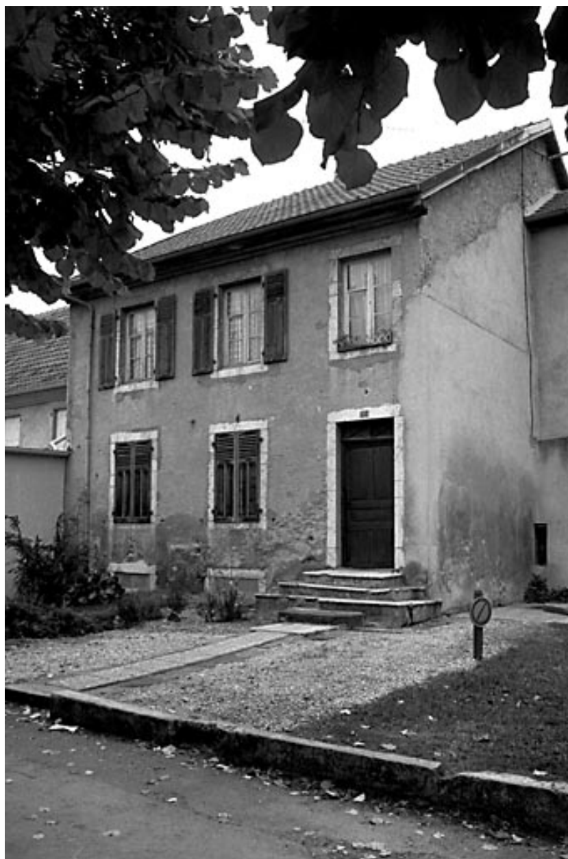
Audincourt : maison située 35 avenue Aristide Briand.
