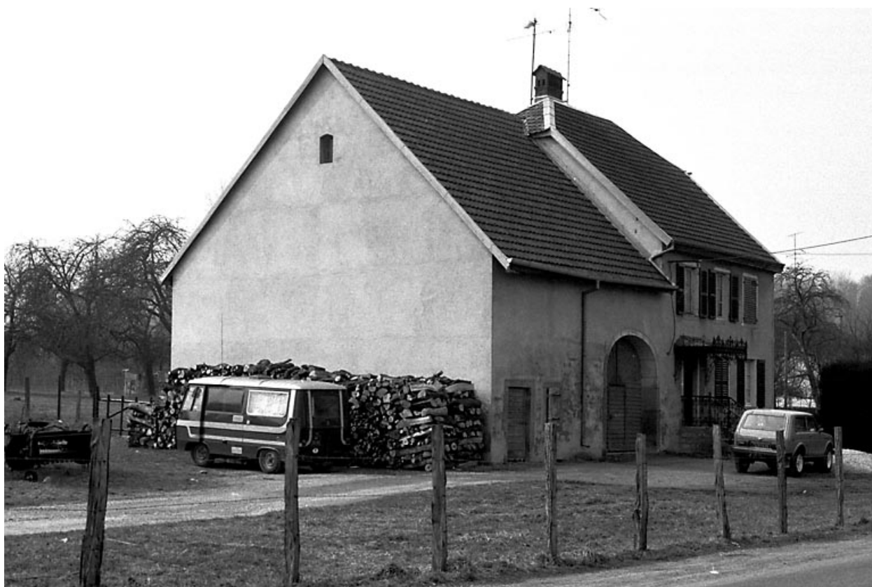
Dasle : ferme située rue de Seloncourt.
