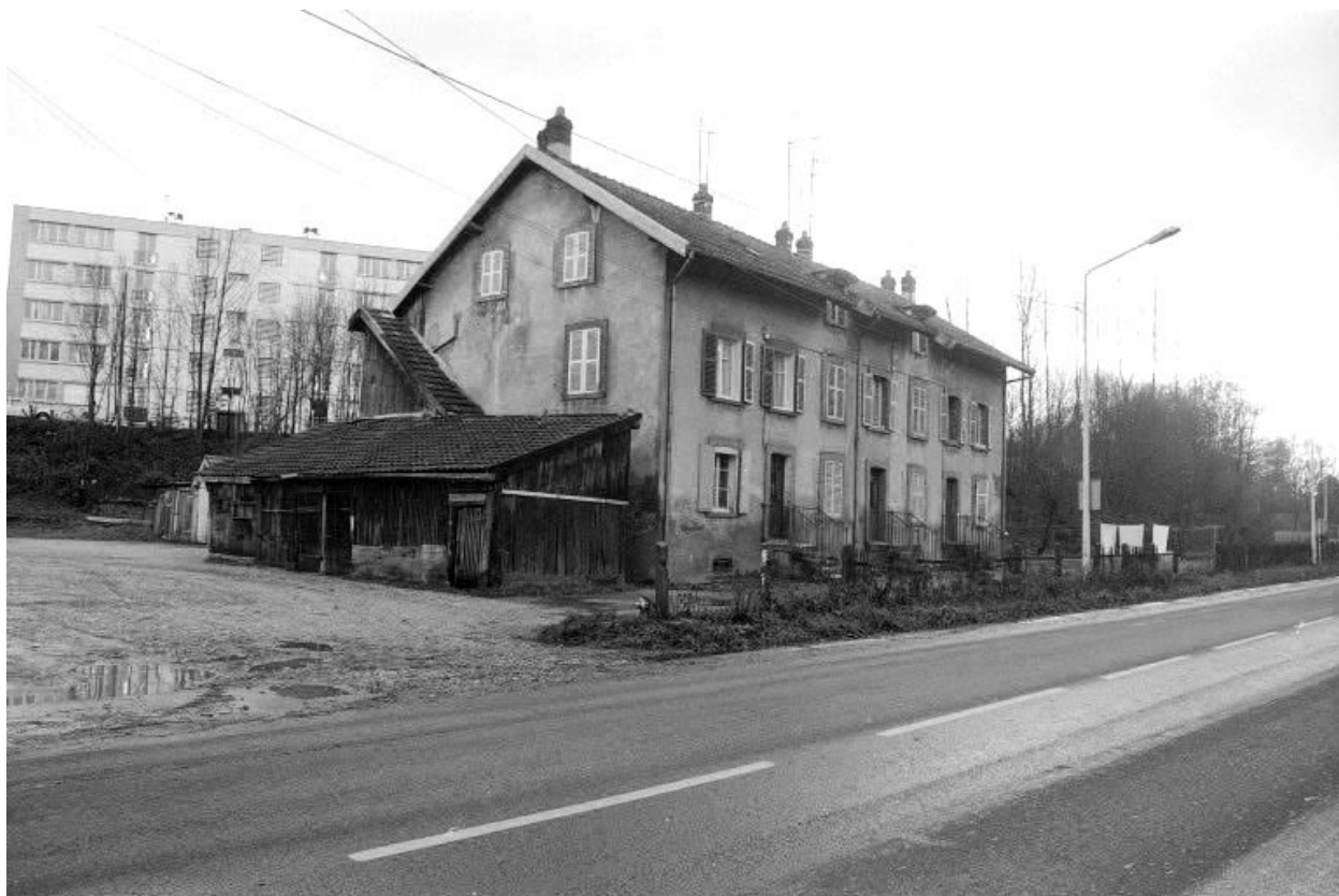
Audincourt : maison située 61 rue de Valentigney.
