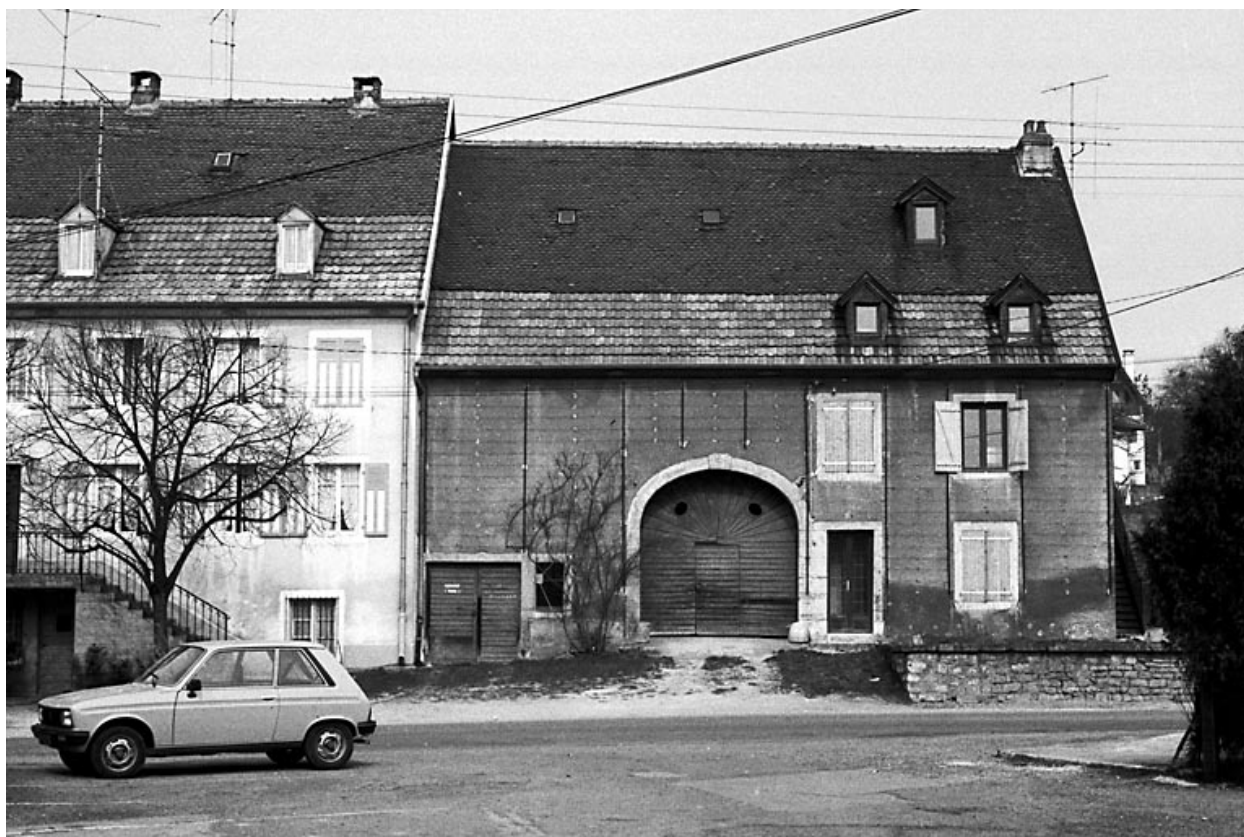
Dasle : ferme située 24 rue Centrale.
