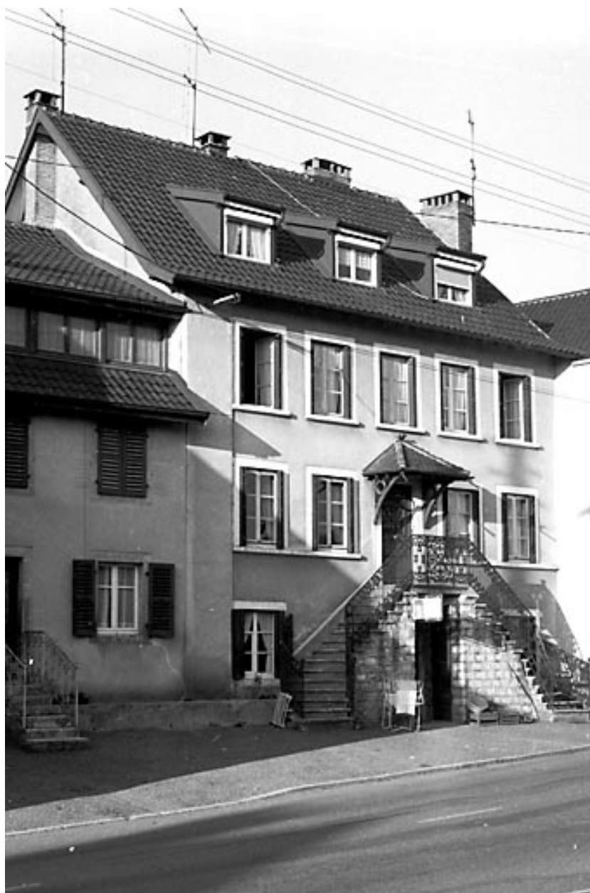
Dasle : maison située rue Centrale.
