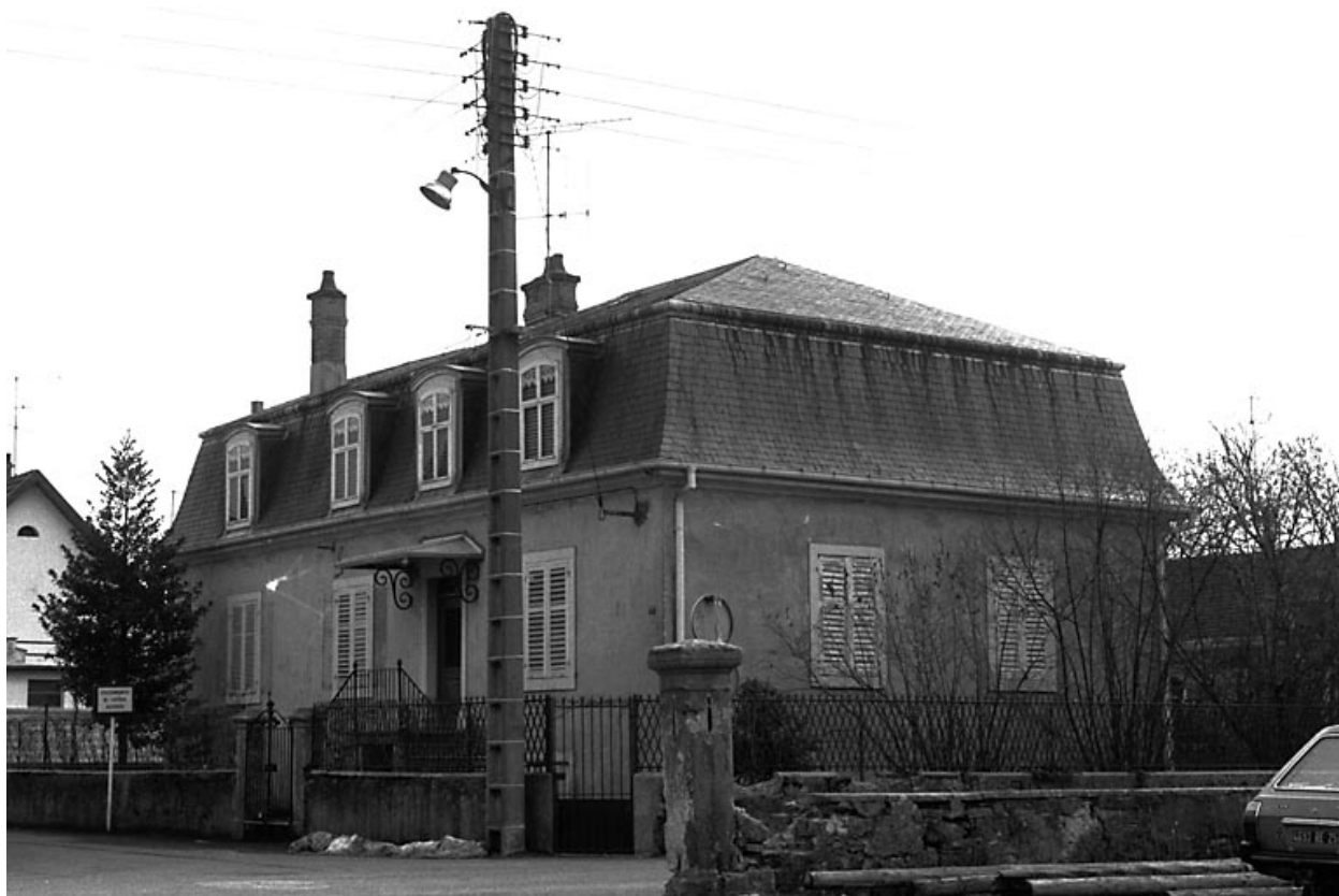
Audincourt : maison située 7 rue du Château.
