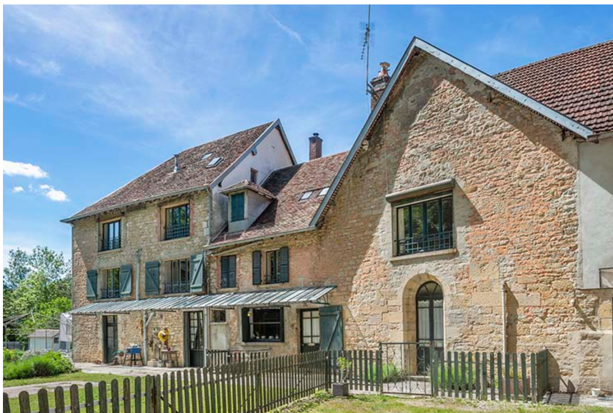
Façades orientales depuis l'est.
