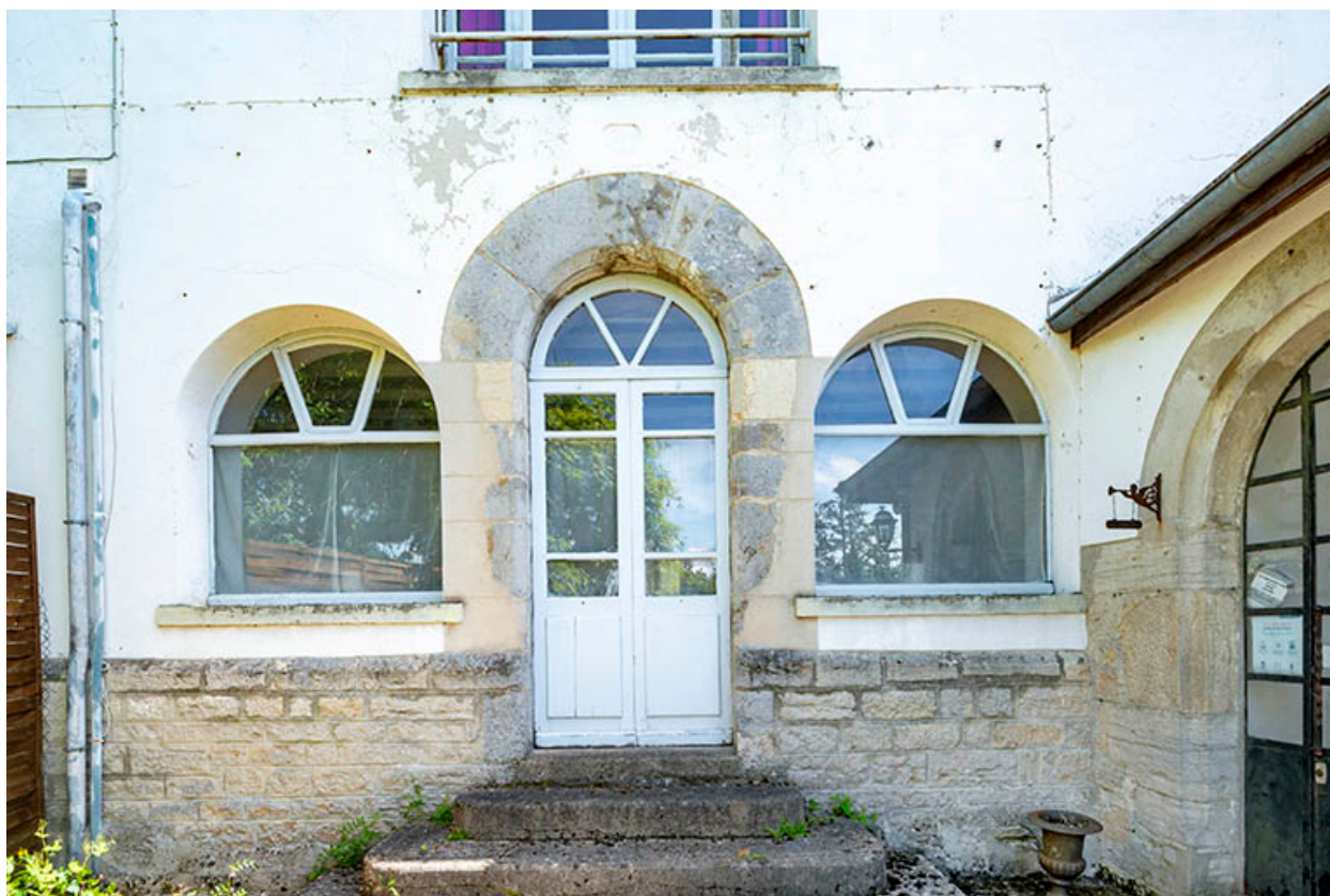
Façade de la chapelle : baies ouest.
