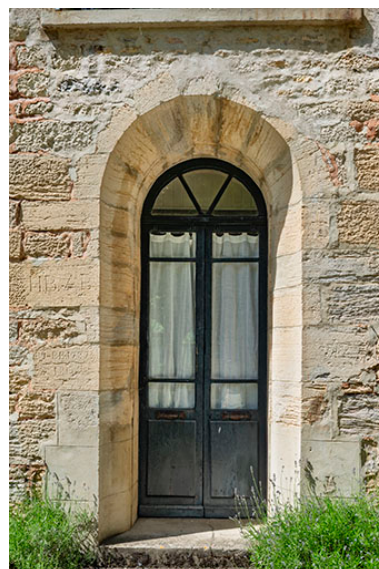
Porte orientale de la chapelle. Phot. Jérôme Mongreville IVR43_20243900683NUC4A
