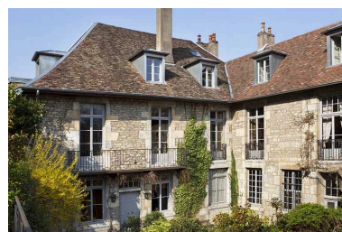
Vue d'ensemble de façades sur jardin du logis principal. Phot. Yves Sancey IVR43_20102500518NUC2A
