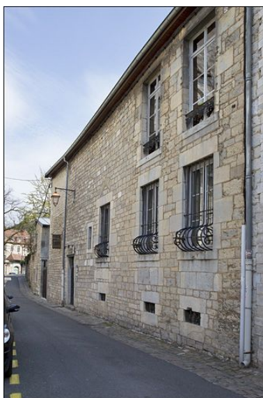
Vue d'ensemble du logis principal depuis la rue, de trois quarts droit. Phot. Yves Sancey IVR43_20102500517NUC2A
