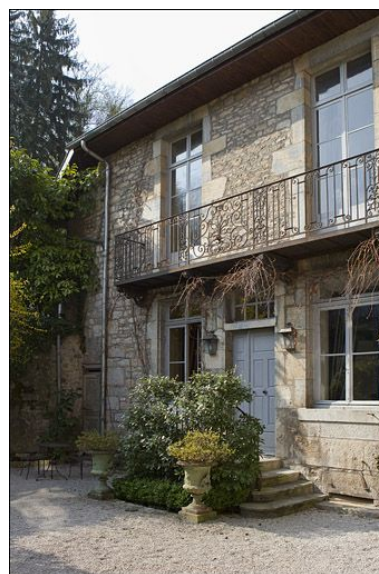
Aile sur jardin, de trois quarts droit. Phot. Yves Sancey IVR43_20102500522NUC2A
