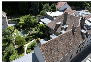
Vue du logis et du jardin, depuis le clocher de la cathédrale. Phot. Yves Sancey IVR43_20102500539NUC2A
