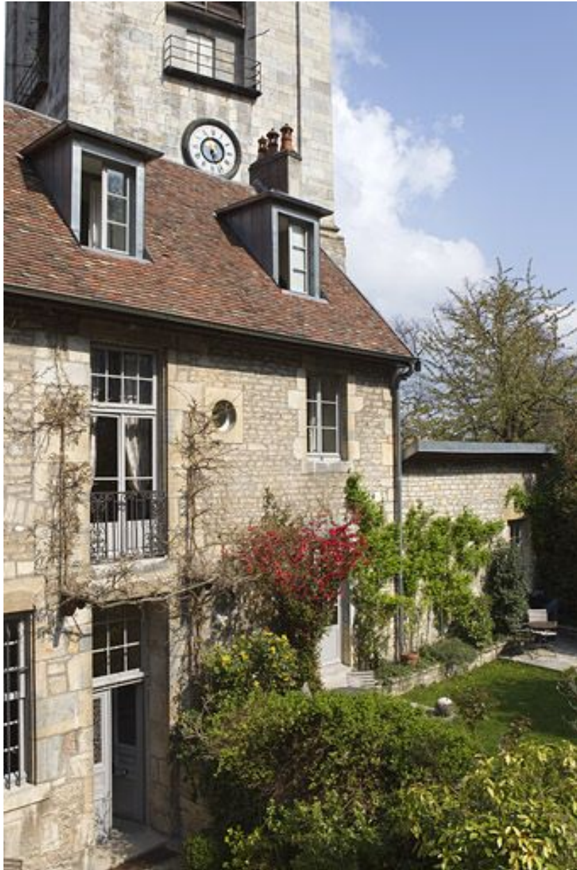
Façade postérieure du logis donnant sur le jardin.
