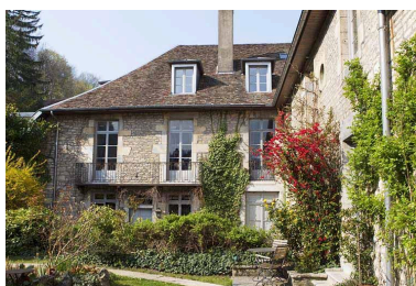
Vue d'ensemble de l'aile sur jardin du logis principal. Phot. Yves Sancey IVR43_20102500519NUC2A
