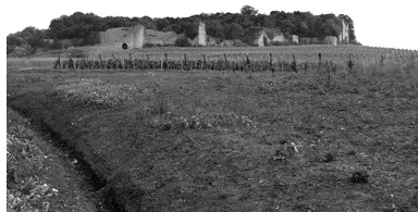
Vue générale depuis le sud-est. Phot. Bernard Lardière IVR43_19793900330X
