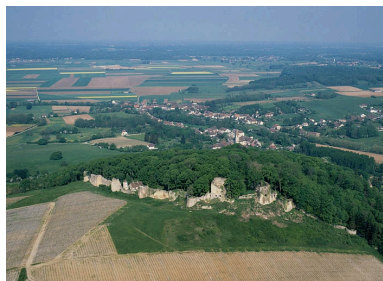
Vue aérienne du château fort et du village en arrière-plan. Phot. Yves Sancey IVR43_19903901051XA
