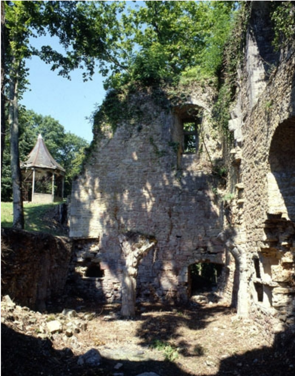
Ruines d'une chapelle, salle probablement en sous-sol, constituée de deux vaisseaux à deux travées : colonne centrale qui recevait les retombées des ogives.
