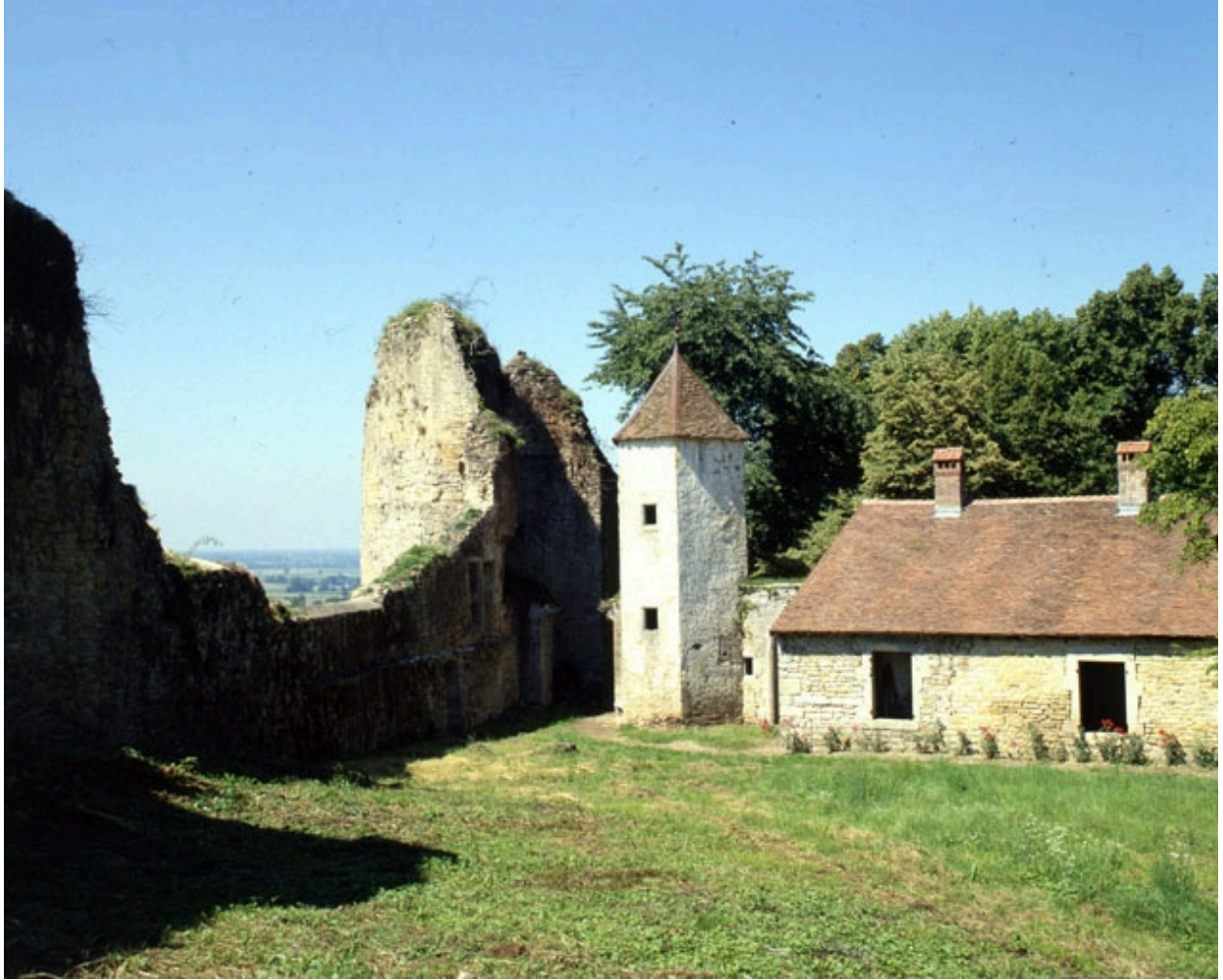
Rempart médiéval du Bourg-Dessus, volontairement échancré pour ouvrir le parc sur les paysages des Côtes du Jura, en 1990.
