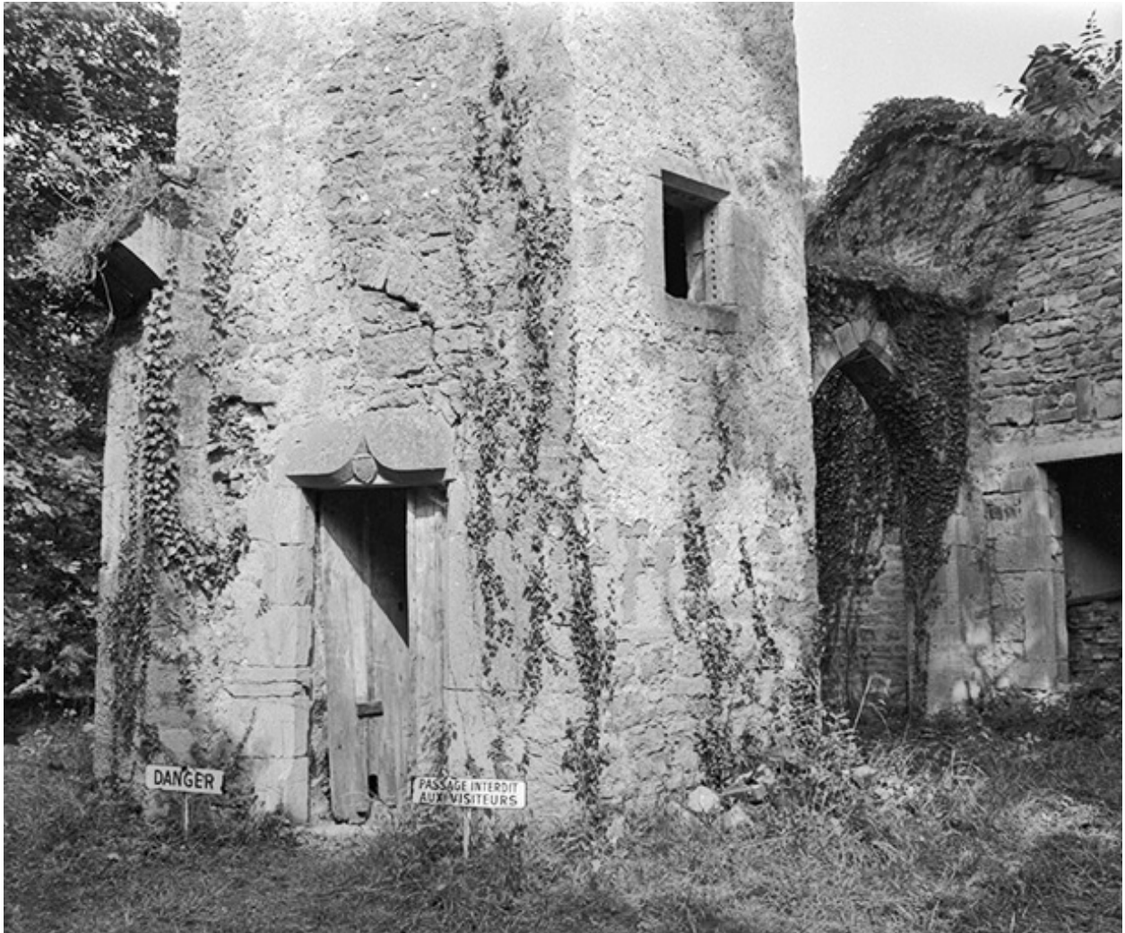
Petite tour dans le parc actuel du château : façade antérieure.
