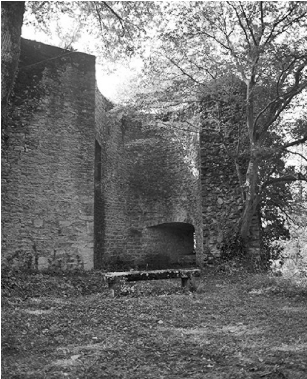
Porte de l'Epinette, vue intérieure d'une tour d'angle.
