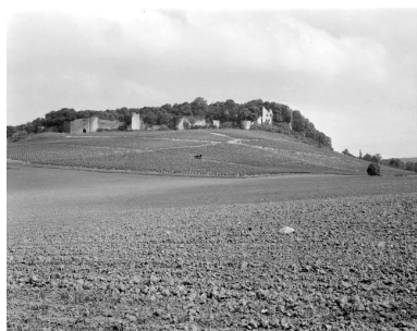
Vue générale depuis le sud-est. Phot. Bernard Lardière IVR43_19793900329X
