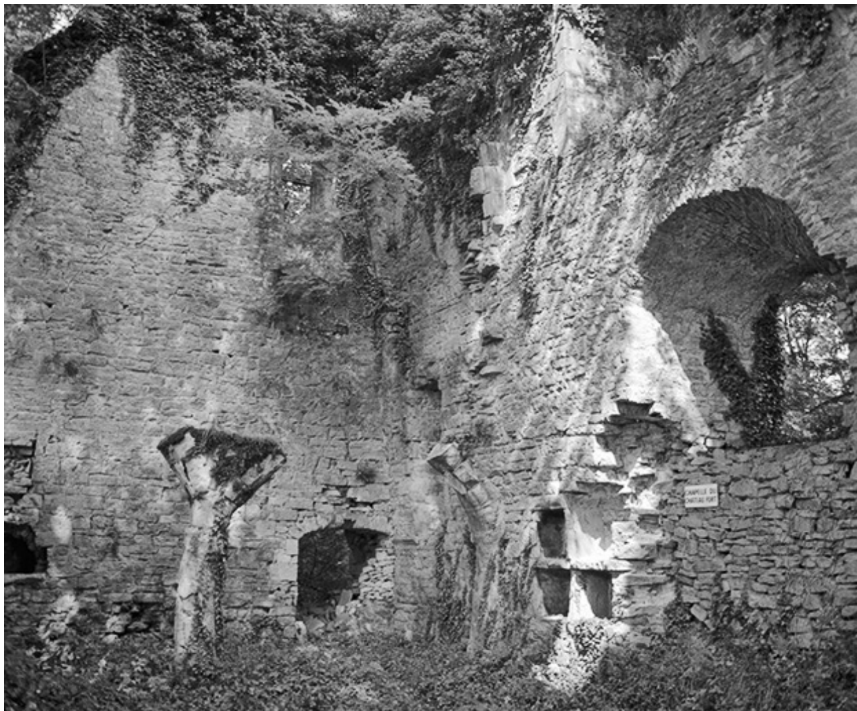
Chapelle du château, vue intérieure.
