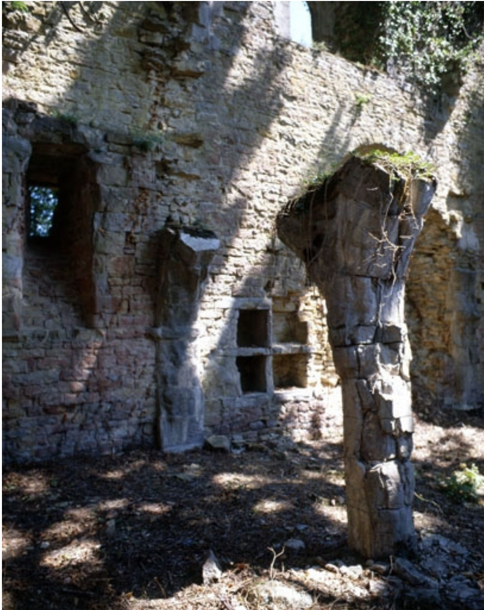
Ruines d'une chapelle, salle probablement en sous-sol, constituée de deux vaisseaux à deux travées : colonne centrale qui recevait les retombées des ogives.
