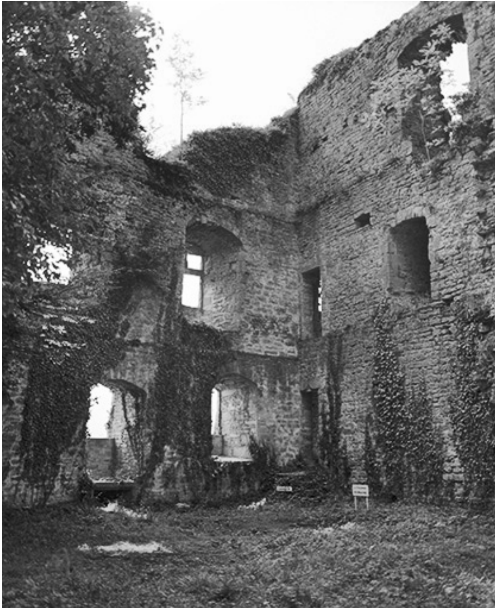
Le donjon, vue intérieure de l'angle sud-est.
