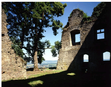
Murs du château vus de l'intérieur en 1990. Phot. Yves Sancey IVR43_19903901080VA
