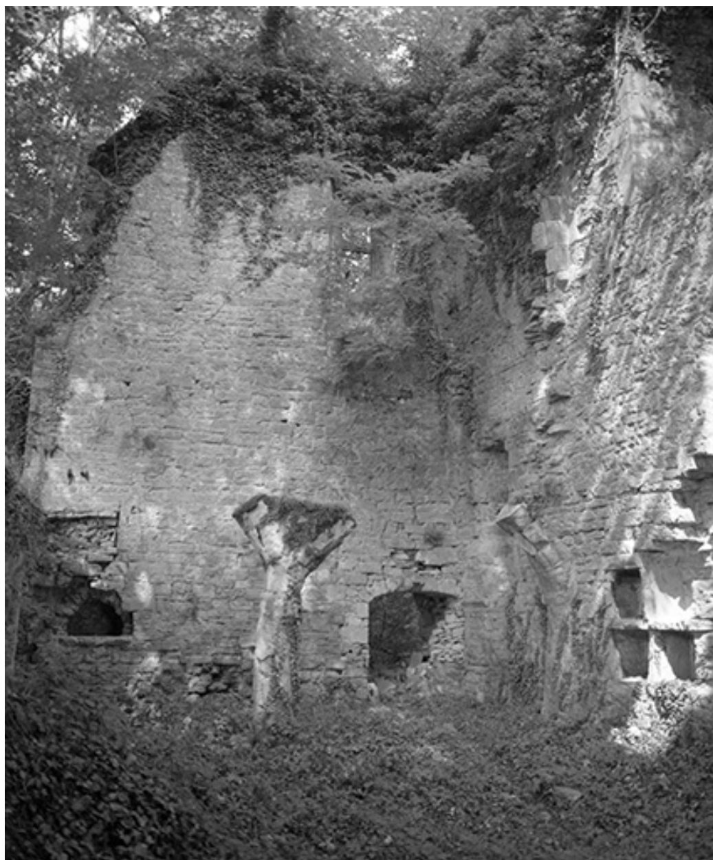
Chapelle du château, vue intérieure.
