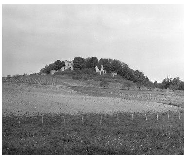
Vue générale depuis l'est. Phot. Yves Sancey IVR43_19793900277X
