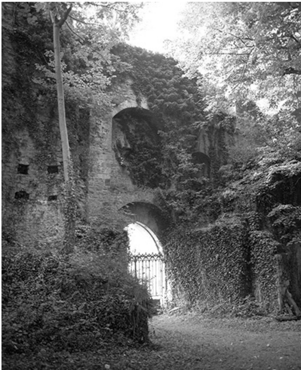
Porte de l'Épinette, vue intérieure.
