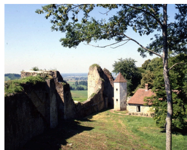
Rempart médiéval du Bourg-Dessus, volontairement échancré pour ouvrir le parc sur les paysages des Côtes du Jura, en 1990. Phot. Yves Sancey IVR43_19903901079XA
