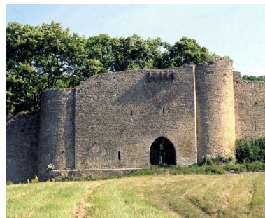
Porte de l'Épinette, ouverte au sud, en 1990. Phot. Yves Sancey IVR43_19903901072XA
