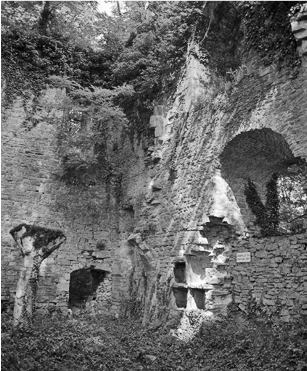
Chapelle du château, vue intérieure.
