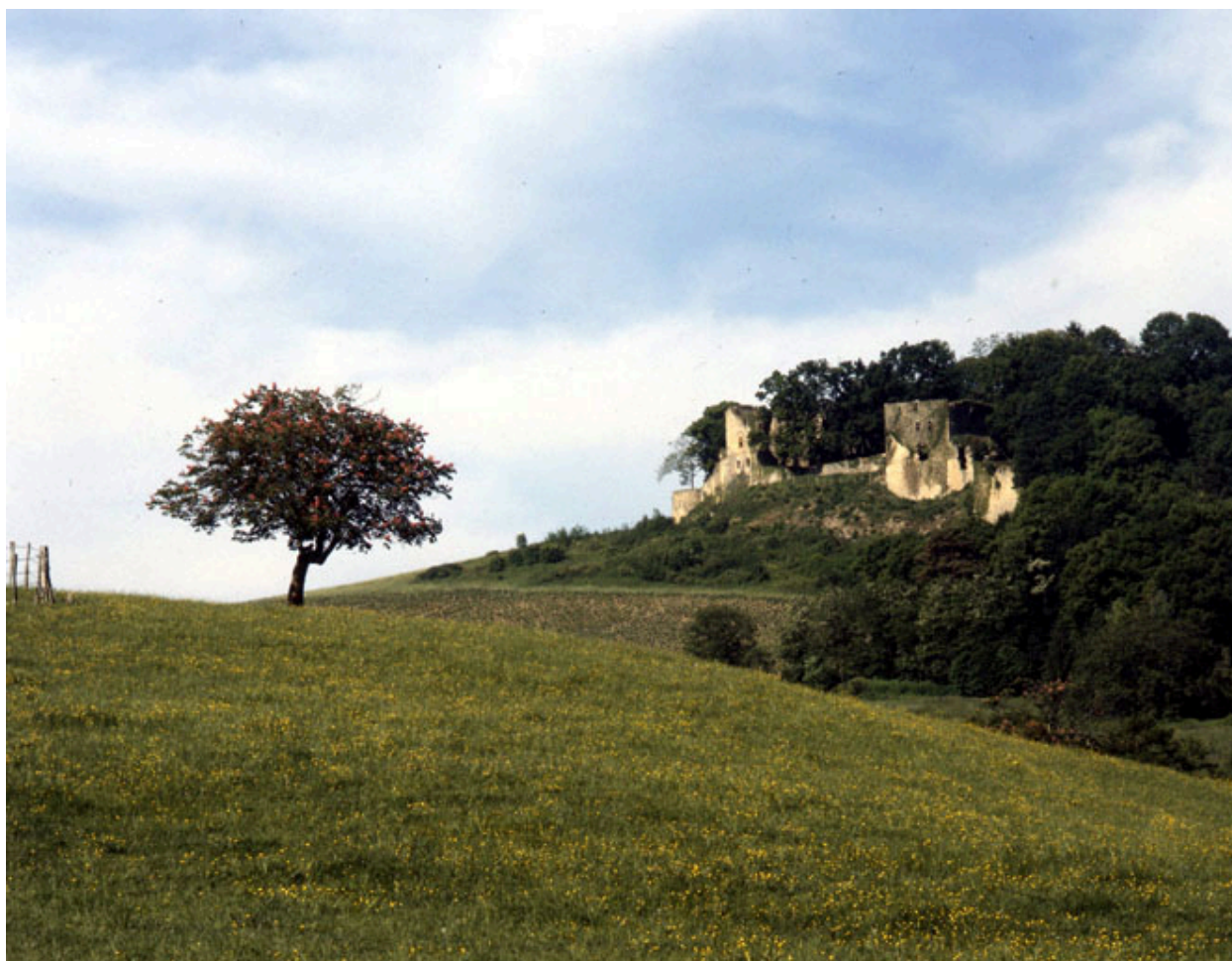
Vestiges du château vus depuis le nord-est.
