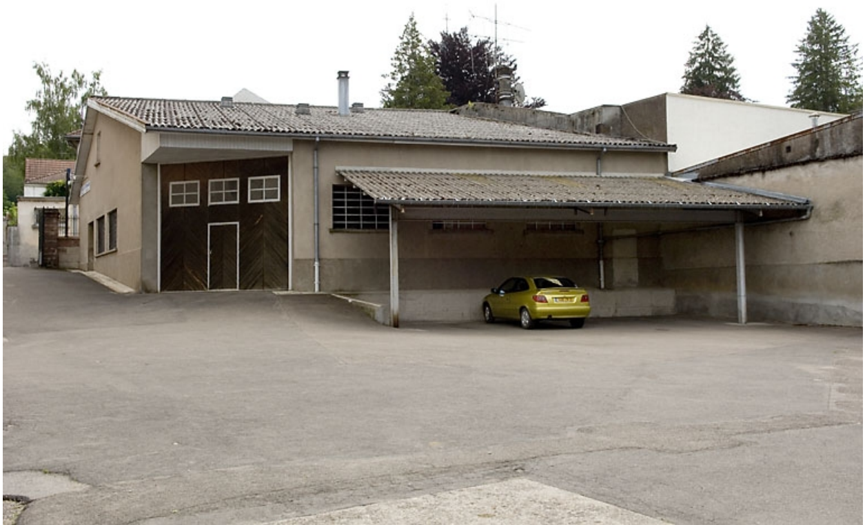
Atelier de fabrication (?). Vue depuis la cour.
