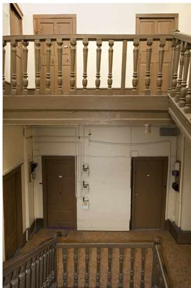
Détail de la rampe de l'escalier. Phot. Yves Sancey IVR43_20082500266NUC2A
