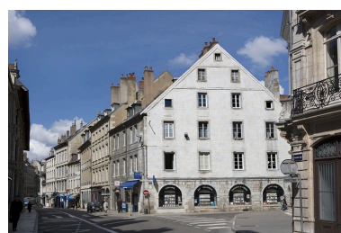
Vue d'ensemble du logis principal de trois quarts droit. Phot. Yves Sancey IVR43_20082500272NUC2A
