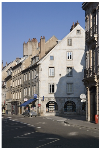
Vue d'ensemble du logis principal de trois quarts droit. Phot. Yves Sancey IVR43_20082500267NUC2A
