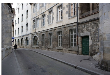
Détail des rez-de-chaussée de la façade latérale du logis principal et du logis secondaire depuis la rue de la Bibliothèque. Phot. Yves Sancey IVR43_20082500270NUC2A
