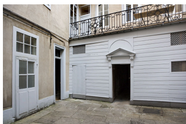
Vue du rez-de-chaussée des bâtiments au fond de la première cour : de trois quarts gauche. Phot. Yves Sancey IVR43_20082500264NUC2A
