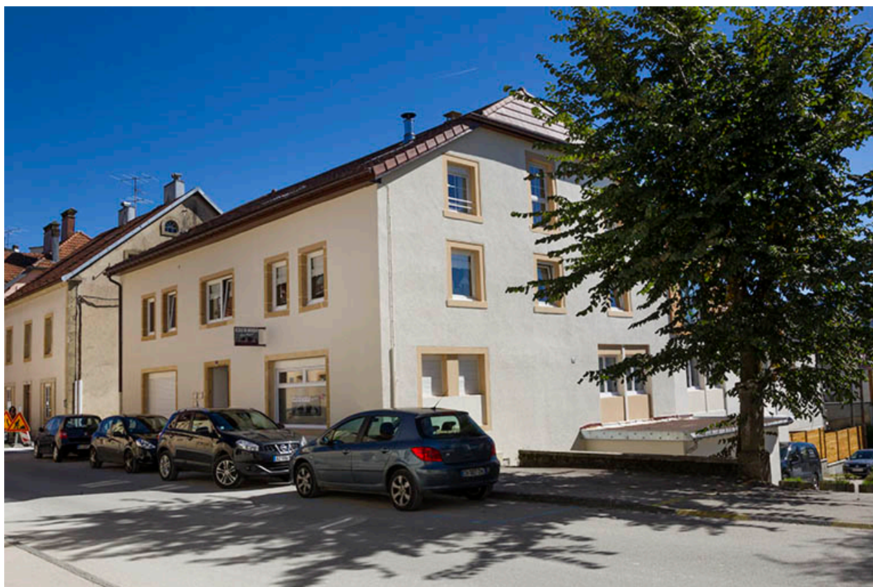
Façades antérieure et latérale droite.
