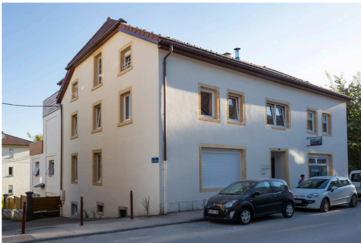
Façades antérieure et latérale gauche.
