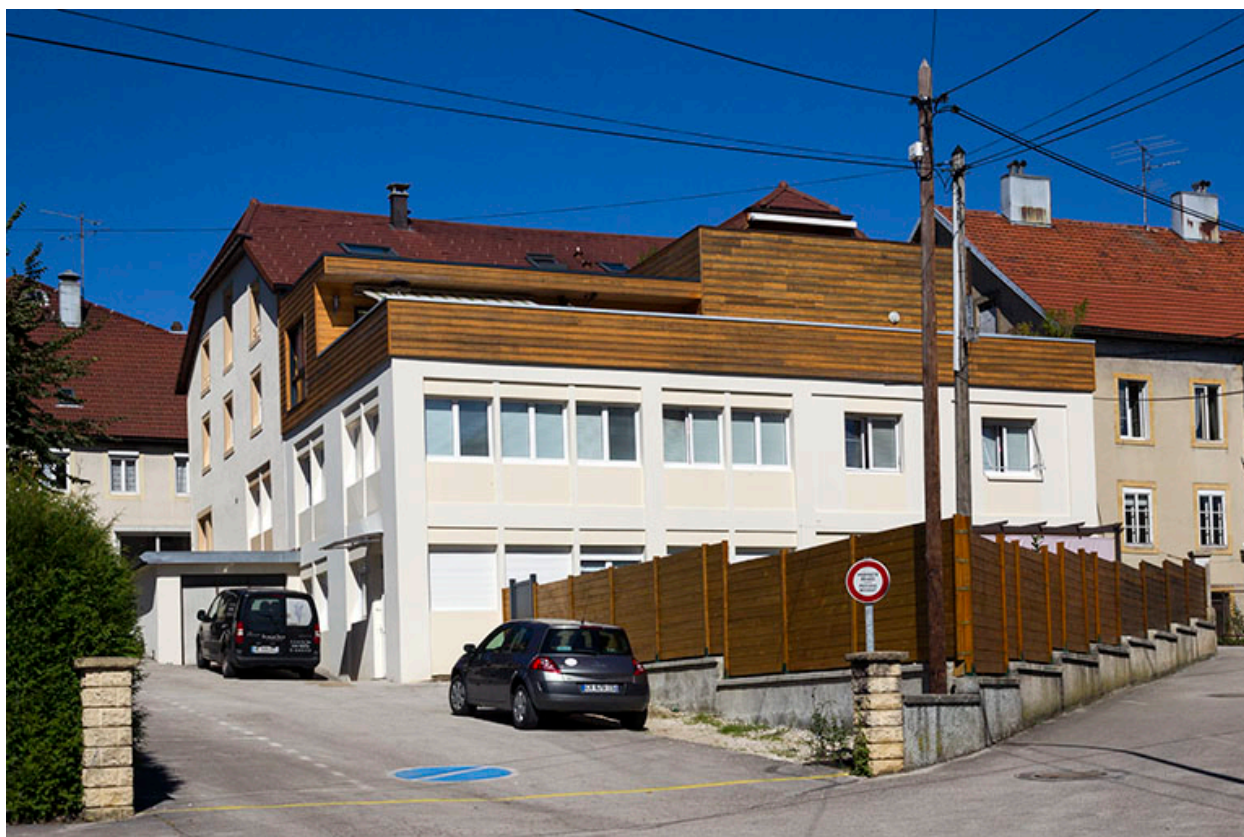
Façades postérieure et latérale droite.
