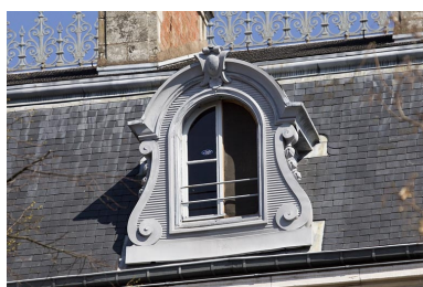
Toiture : détail d'une lucarne.
