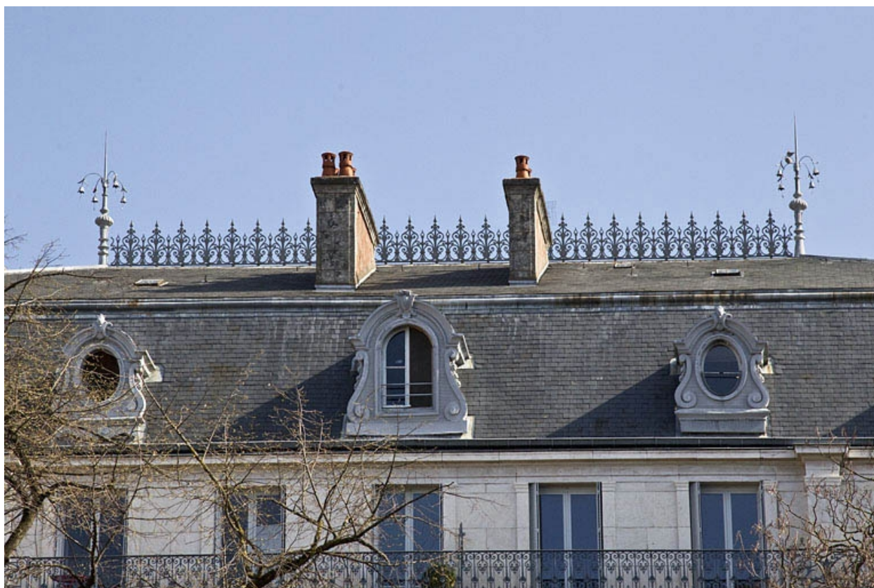
Détail de la toiture en ardoise.
