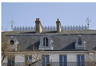
Détail de la toiture en ardoise.
