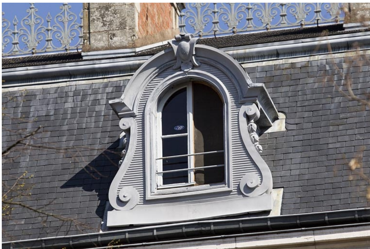
Toiture : détail d'une lucarne.
