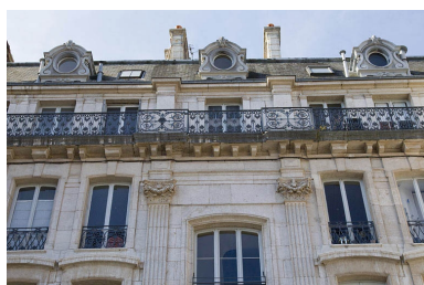
Façade antérieure : détail de la partie supérieure.
