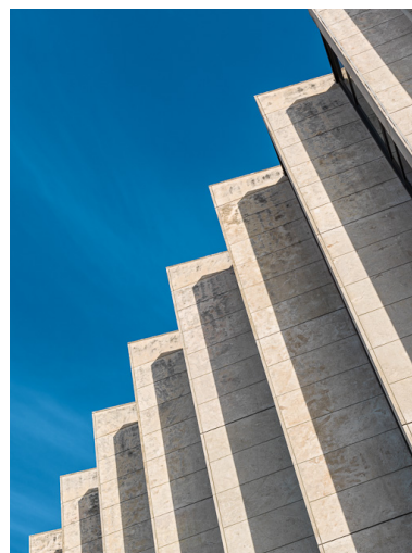
Façade antérieure : détail des lames obliques séparant les travées. Phot. Pierre-Marie Barbe-Richaud IVR26_20142102130NUC4A
