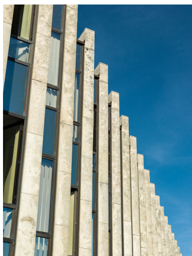
Façade postérieure : détail des baies du deuxième et troisième étages. Phot. Pierre-Marie Barbe-Richaud IVR26_20142102124NUC2A
