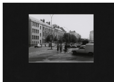
Vue du boulevard de la Trémouille depuis le Cellier de Clairvaux.
