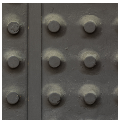
Façade antérieure : détail des cabochons aplatis d'un vantail de la porte réalisée par P. Sabatier. Phot. Pierre-Marie Barbe-Richaud IVR26_20142102131NUC2A
