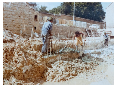
Vue du chantier en juillet 1977 : recépage et dégagement des attentes devant le bâtiment du Conseil général. Photographie ancienne. (Archives départementales de la Côte-d'Or, Dijon, 32 J 57) Phot. Pierre-Marie Barbe-Richaud IVR26_20142100576NUC2A
