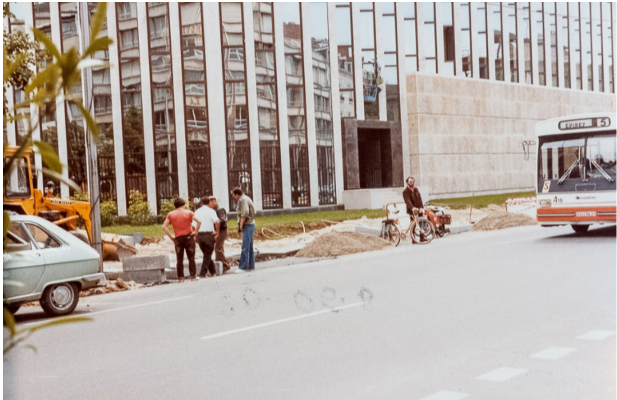
Vue du chantier en juin 1980 : installation des bordures de trottoir. Photographie ancienne. (Archives départementales de la Côte-d'Or, Dijon, 32 J 57)
