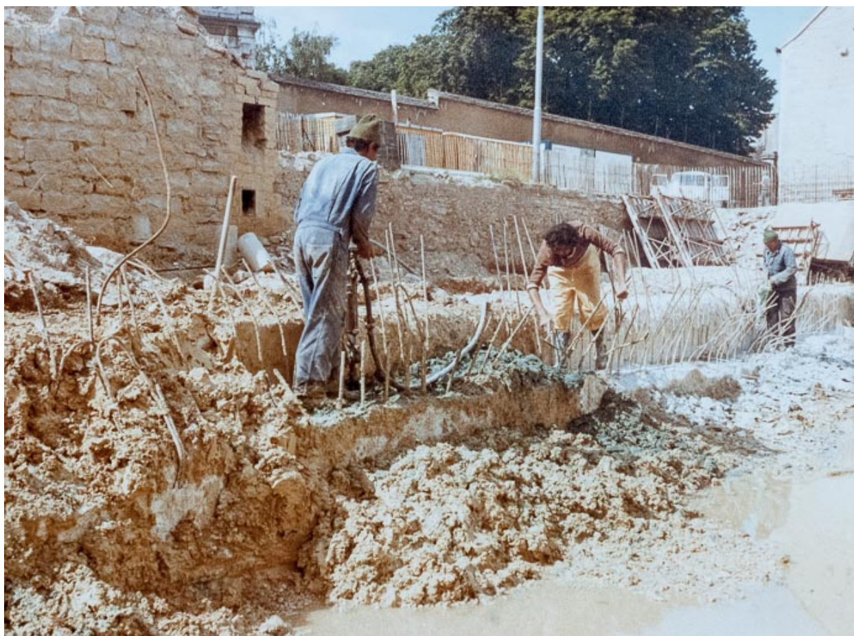
Vue du chantier en juillet 1977 : recépage et dégagement des attentes devant le bâtiment du Conseil général. Photographie ancienne. (Archives départementales de la Côte-d'Or, Dijon, 32 J 57)
