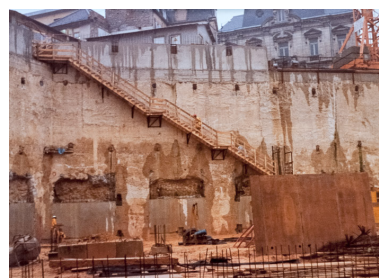
Vue du chantier en novembre 1977 : paroi de la face sud avec
