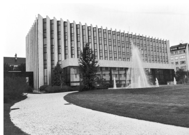
Hôtel de région : façade postérieure et jardin. Photographie ancienne, ca. 1990-1995. (Archives Conseil régional de Bourgogne) Phot. Pierre-Marie Barbe-Richaud, Autr. Paysant IVR26_20142102413NUC2
