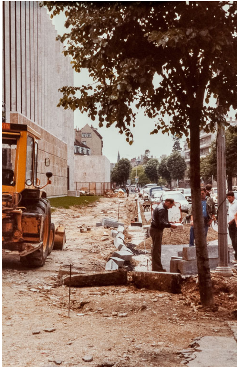
Vue du chantier en juin 1980 : installation des bordures de trottoir. Photographie ancienne. (Archives départementales de la Côte-d'Or, Dijon, 32 J 57)
