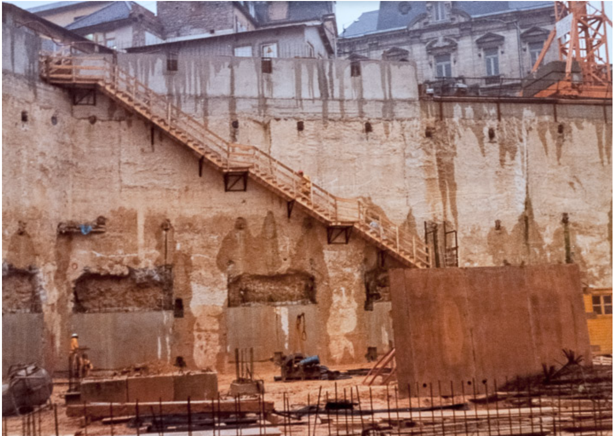
Vue du chantier en novembre 1977 : paroi de la face sud avec l'escalier d'accès. Photographie ancienne. (Archives départementales de la Côte-d'Or, Dijon, 32 J 57)
