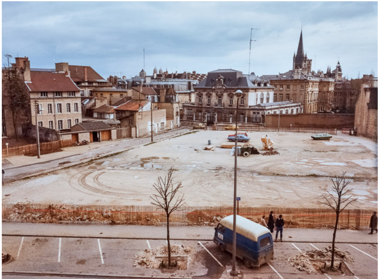
Vue du chantier en mars 1977 : terrain avant travaux. Photographie ancienne. (Archives départementales de la Côte-d'Or, Dijon, 32 J 57)
