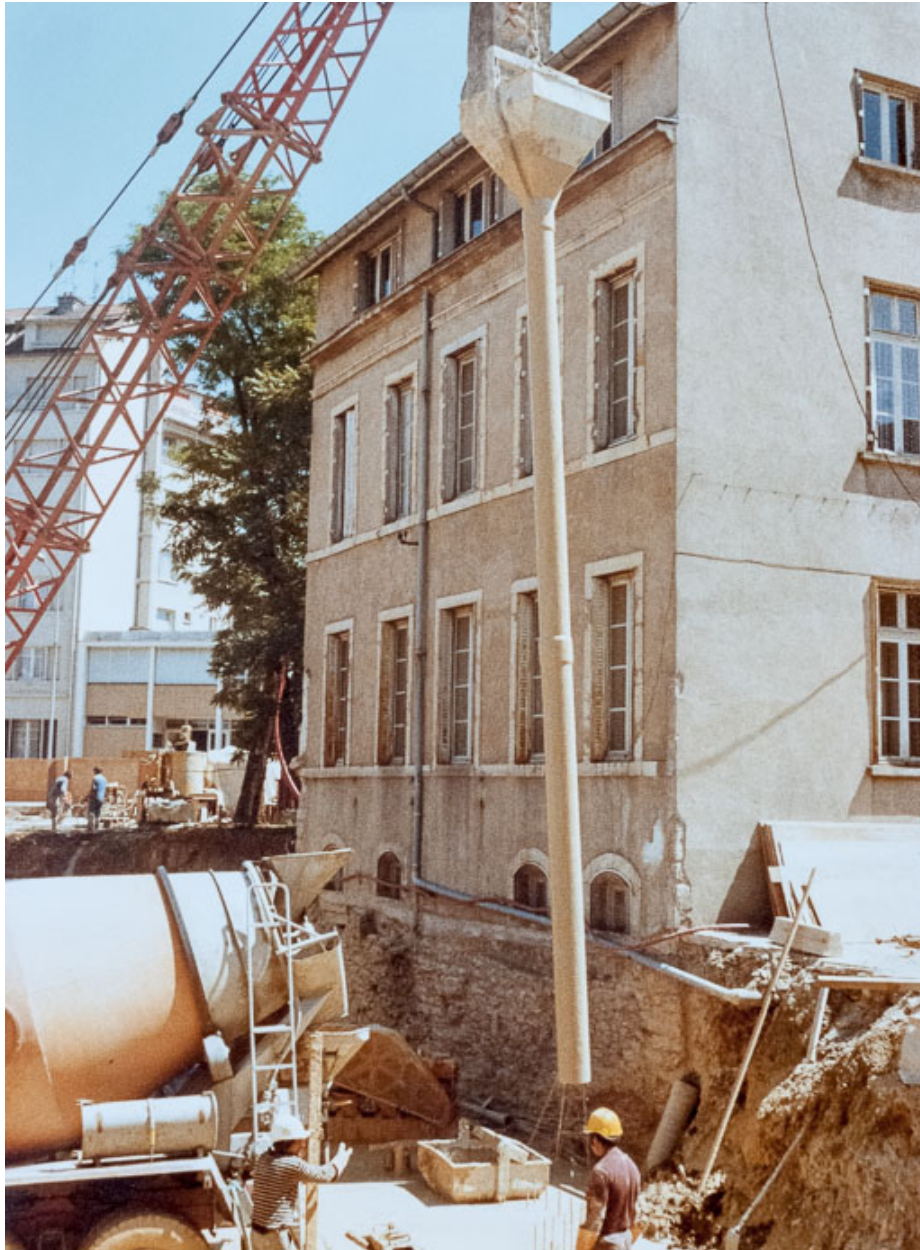
Vue du chantier en juillet 1977 : tube plongeur avant coulage du béton de paroi moulé. Photographie ancienne. (Archives départementales de la Côte-d'Or, Dijon, 32 J 57)
