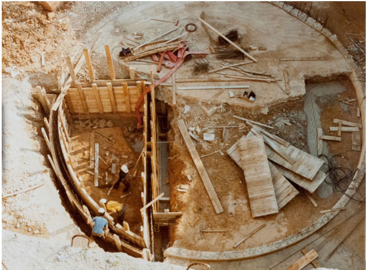
Vue du chantier en mai 1978 : fondations et coffrage de la cuve à fuel enterrée. Photographie ancienne. (Archives départementales de la Côte-d'Or, Dijon, 32 J 57)
