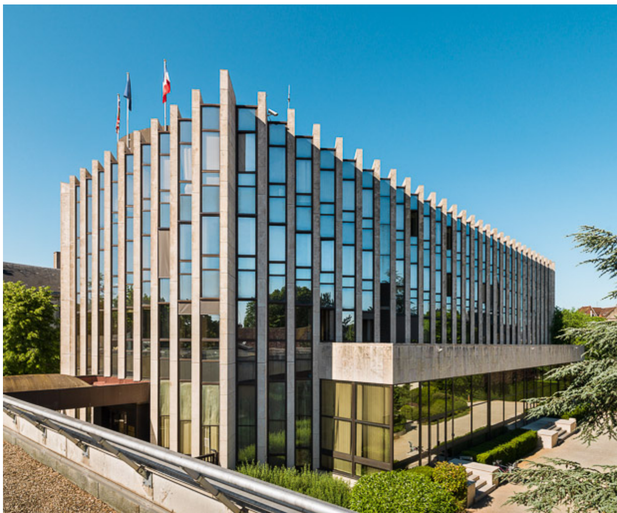
Façades postérieure et latérale : angle sud-ouest avec la galerie François-Mitterrand.
