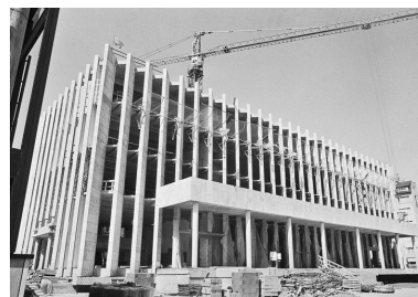
Chantier de construction de l'hôtel de région. Photographie ancienne, août 1979. (Archives du quotidien Le Bien Public, Dijon) Phot. Pierre-Marie Barbe- Richaud, Autr. Paysant IVR26_20142102209NUC2
