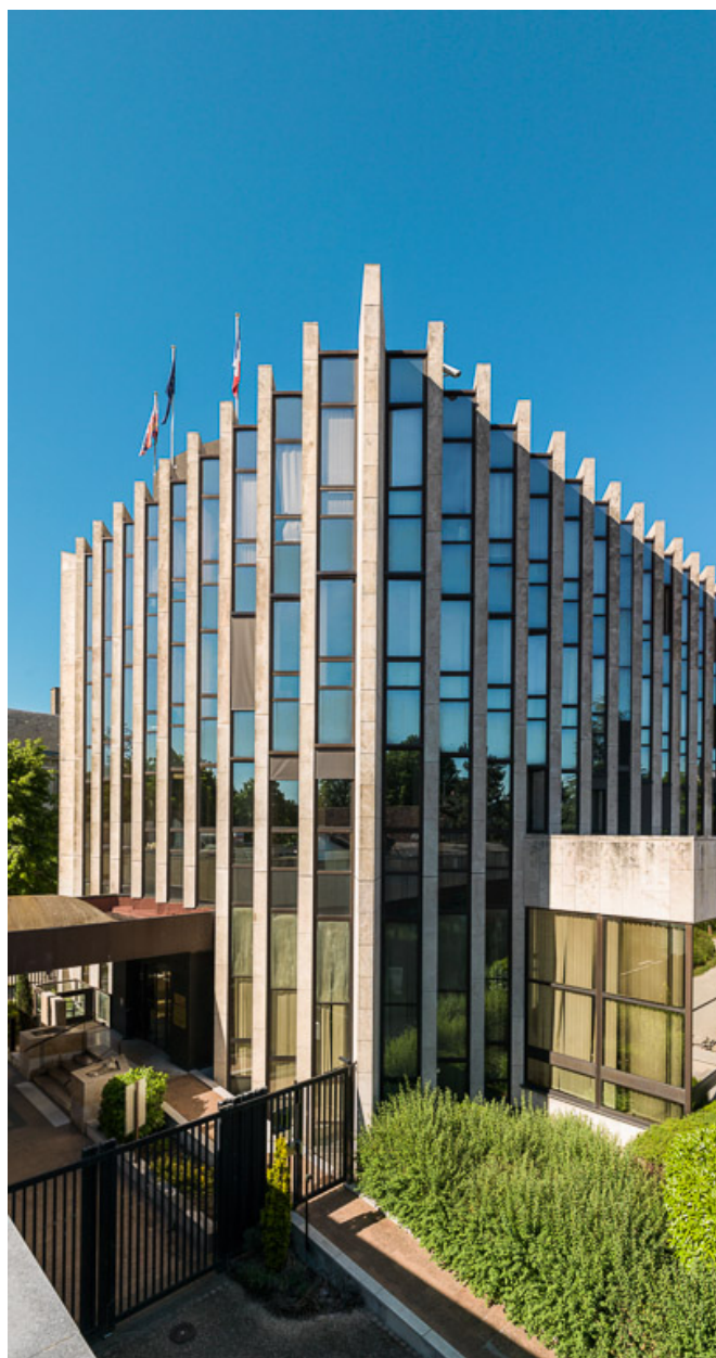
Façades postérieure et latérale : angle sud-ouest.
