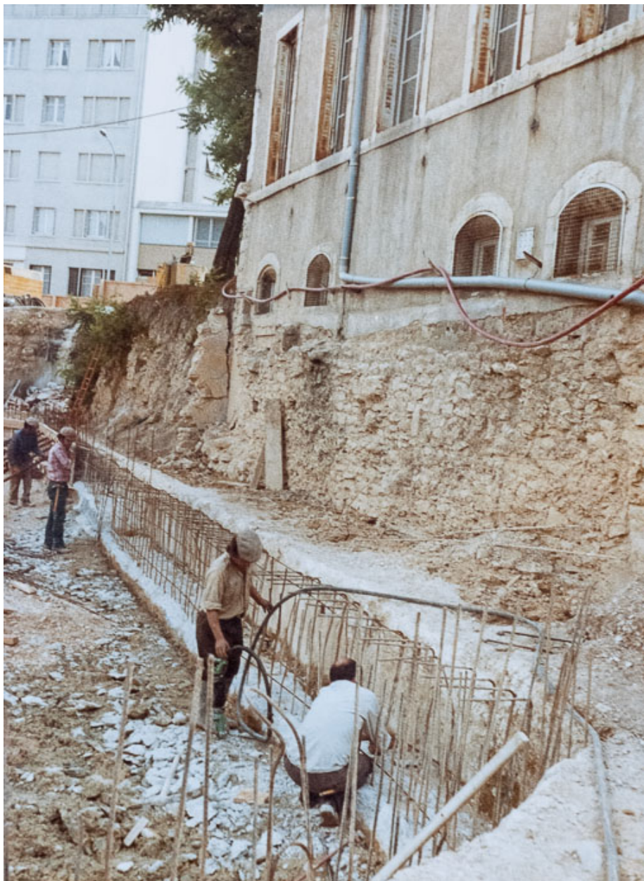
Vue du chantier en juillet 1977 : dégagement des attentes et ferrailage du mur périphérique près du bâtiment dit "le petit château". Photographie ancienne. (Archives départementales de la Côte-d'Or, Dijon, 32 J 57)
