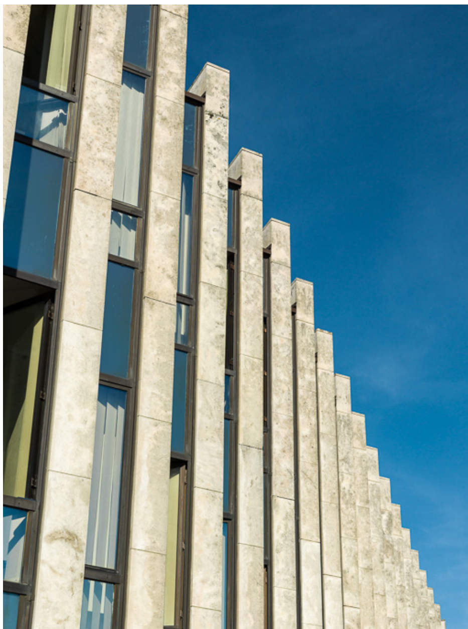
Façade postérieure : détail des baies du deuxième et troisième étages.
