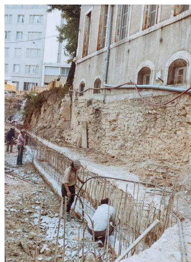
Vue du chantier en juillet 1977 : dégagement des attentes et ferrailage du mur périphérique près du bâtiment dit "le petit château". Photographie ancienne. (Archives départementales de la Côte-d'Or, Dijon, 32 J 57) Phot. Pierre-Marie Barbe-Richaud IVR26_20142100575NUC2A
