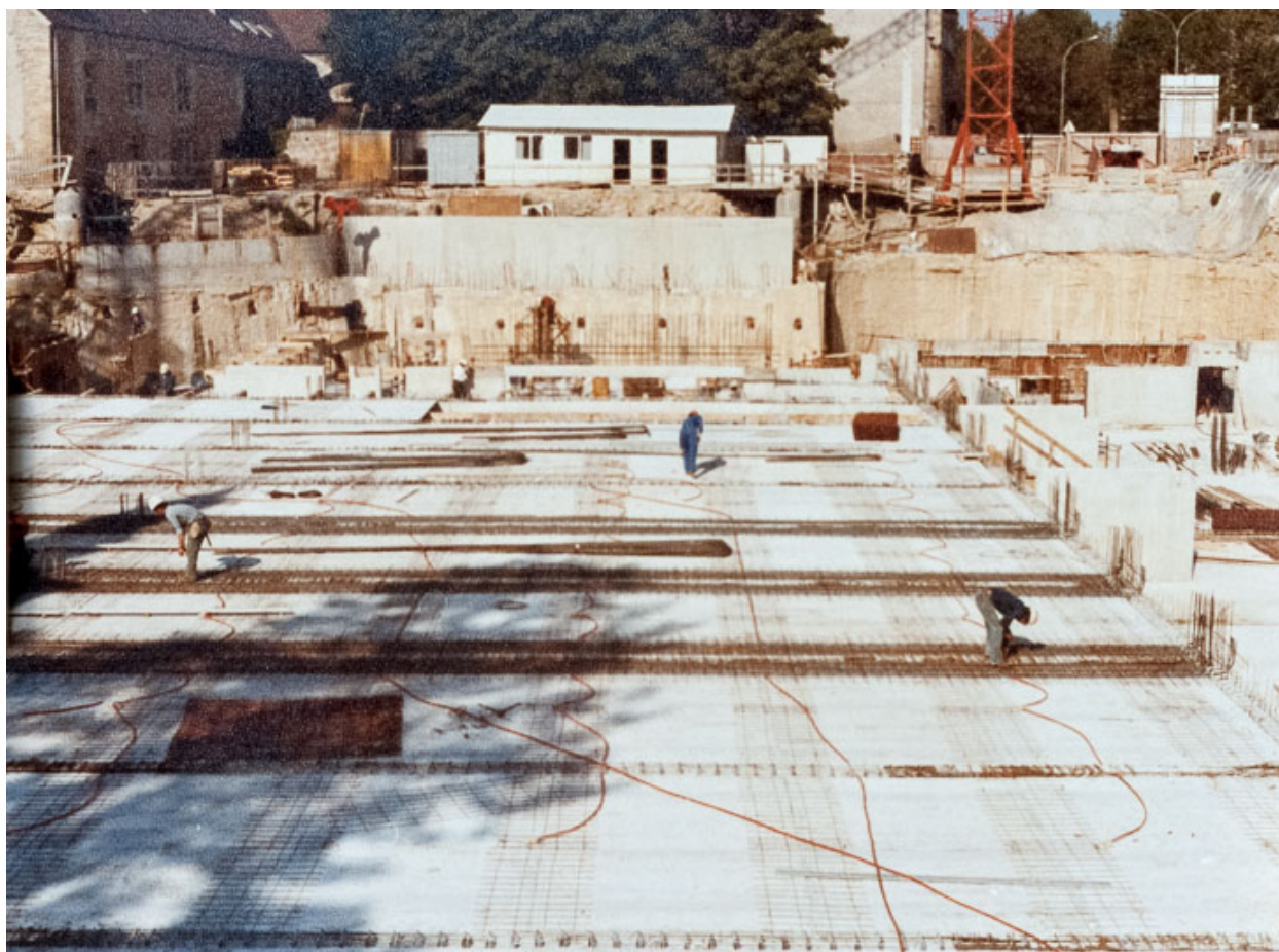
Vue du chantier en mai 1978 : ferrailage des tirants incorporés dans la dalle du plafond du deuxième niveau de sous-sol. Photographie ancienne. (Archives départementales de la Côte-d'Or, Dijon, 32 J 57)
