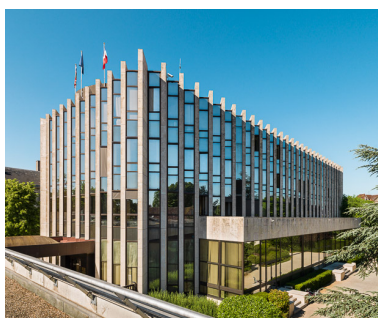
Façades postérieure et latérale : angle sud-ouest avec la galerie François-Mitterrand. Phot. Pierre-Marie Barbe-Richaud IVR26_20142102133NUC2A
