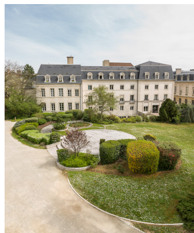
Vue du jardin, en arrière-plan le bâtiment du conseil départemental de la Côte-d'Or (archi. : R.-M. Barade). Phot. Pierre-Marie Barbe-Richaud IVR26_20142102125NUC2A
