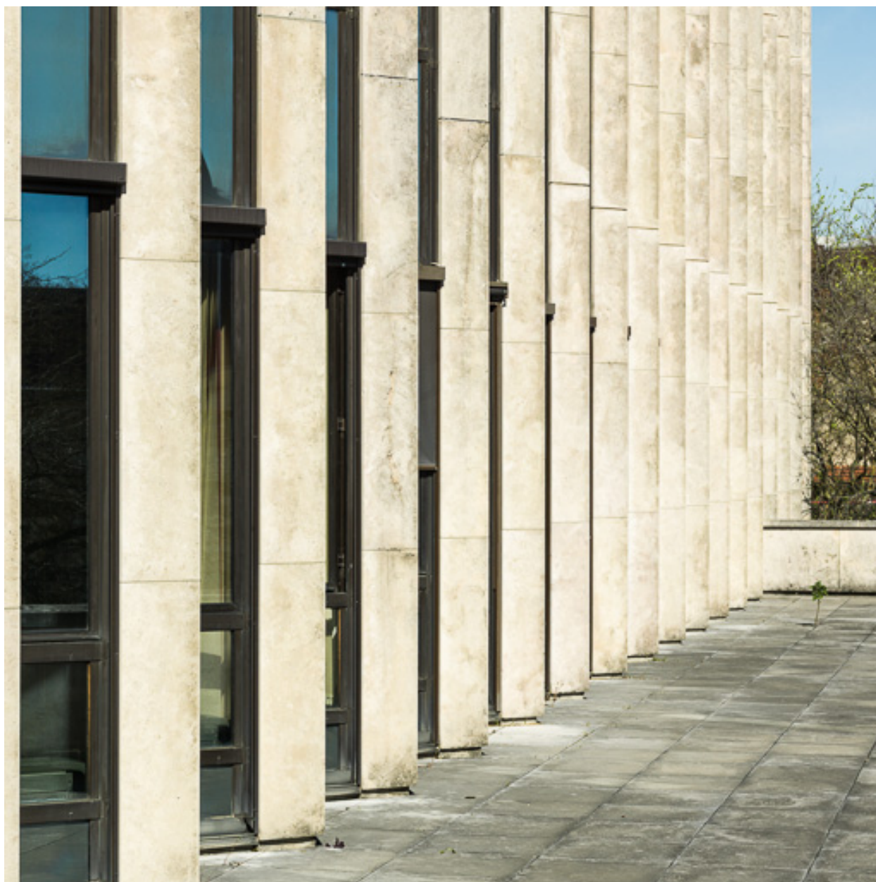
Façade postérieure : travées du premier étage depuis le toit-terrasse de la galerie.
