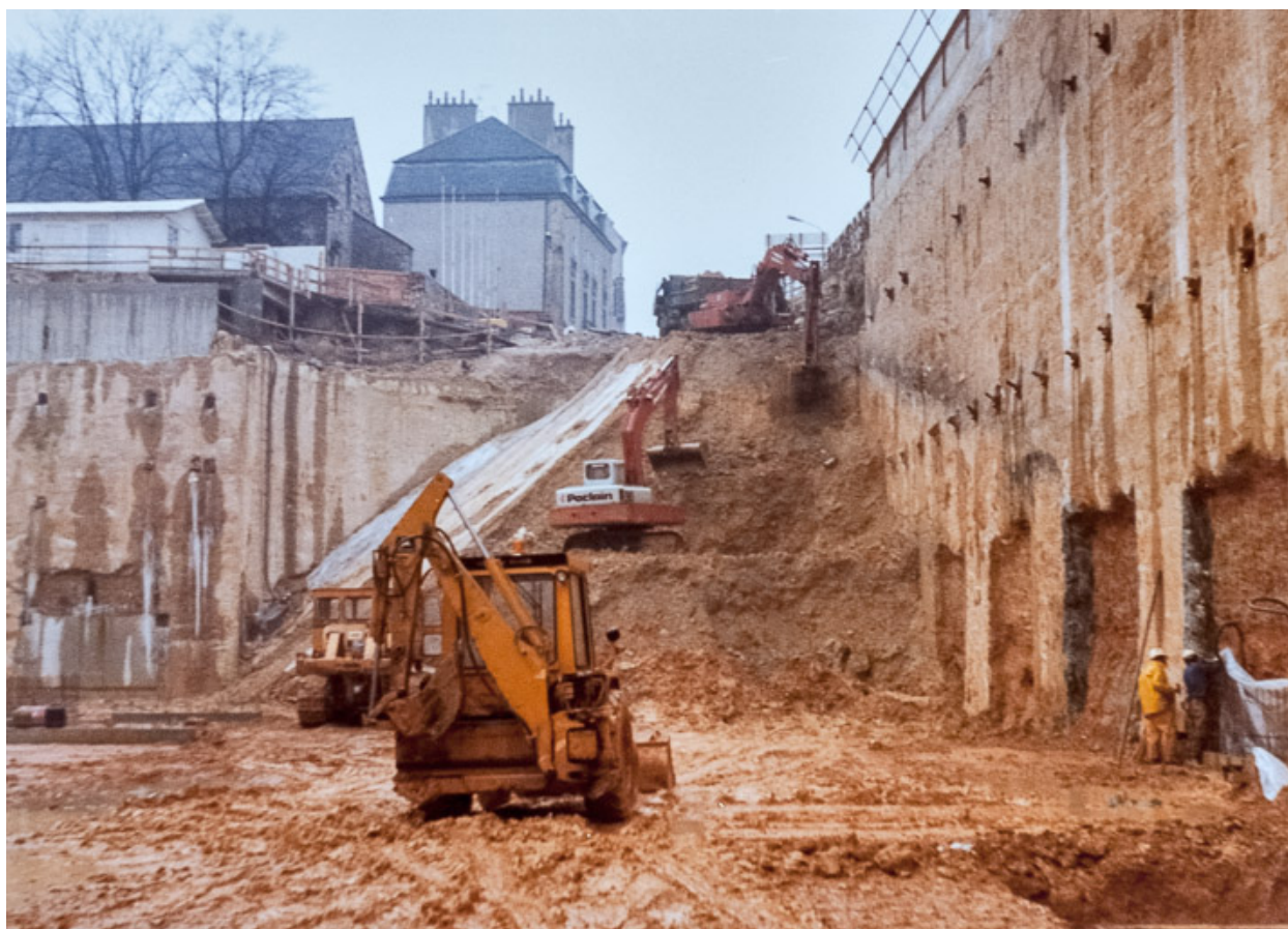
Vue du chantier en novembre 1977 : terrassement pleine masse et terrassement des fondations. Photographie ancienne. (Archives départementales de la Côte-d'Or, Dijon, 32 J 57)
