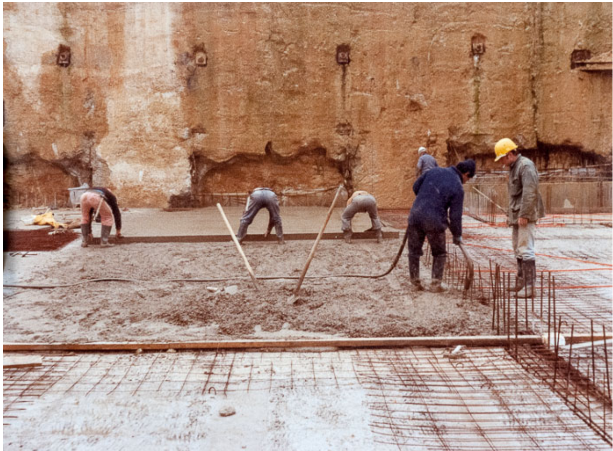
Vue du chantier en février 1978 : coulage de la dalle de compression du quatrième niveau du sous-sol. Photographie ancienne. (Archives départementales de la Côte-d'Or, Dijon, 32 J 57)
