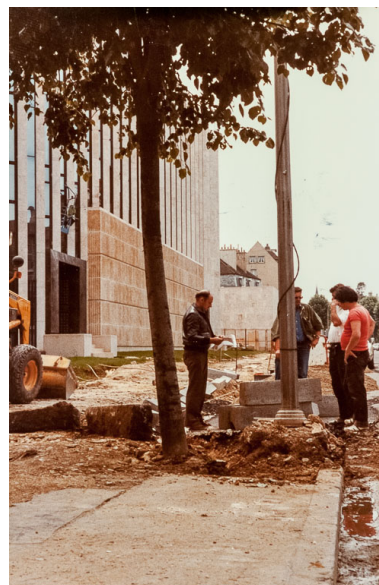
Vue du chantier en juin 1980 : installation des bordures de trottoir. Photographie ancienne. (Archives départementales de la Côte-d'Or, Dijon, 32 J 57) Phot. Pierre-Marie Barbe-Richaud IVR26_20142100595NUC2A
