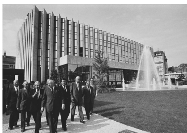
Inauguration de l'hôtel de région : façade postérieure et jardin. Photographie ancienne, ca. 1980. (Archives du quotidien Le Bien Public, Dijon) Phot. Pierre-Marie Barbe- Richaud, Autr. Paysant IVR26_20142102197NUC2
