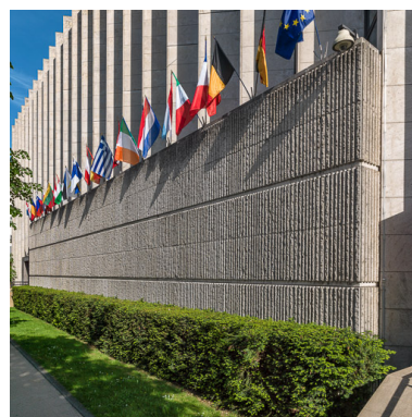
Façade antérieure : détail du parement matérialisant la salle des Assemblées. Phot. Pierre-Marie Barbe-Richaud IVR26_20142102129NUC2A
