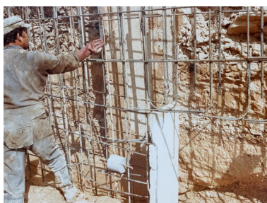
Vue du chantier en juillet 1977 : détail de dalle en béton maigre avec aciers en attente pour entrejambe. Photographie ancienne. (Archives départementales de la Côte-d'Or, Dijon, 32 J 57) Phot. Pierre-Marie Barbe-Richaud IVR26_20142100572NUC2A
