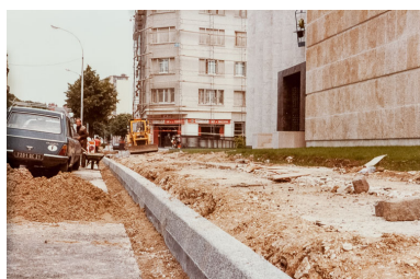
Vue du chantier en juin 1980 : installation des bordures de trottoir. Photographie ancienne. (Archives départementales de la Côte-d'Or, Dijon, 32 J 57) Phot. Pierre-Marie Barbe-Richaud IVR26_20142100596NUC2A
