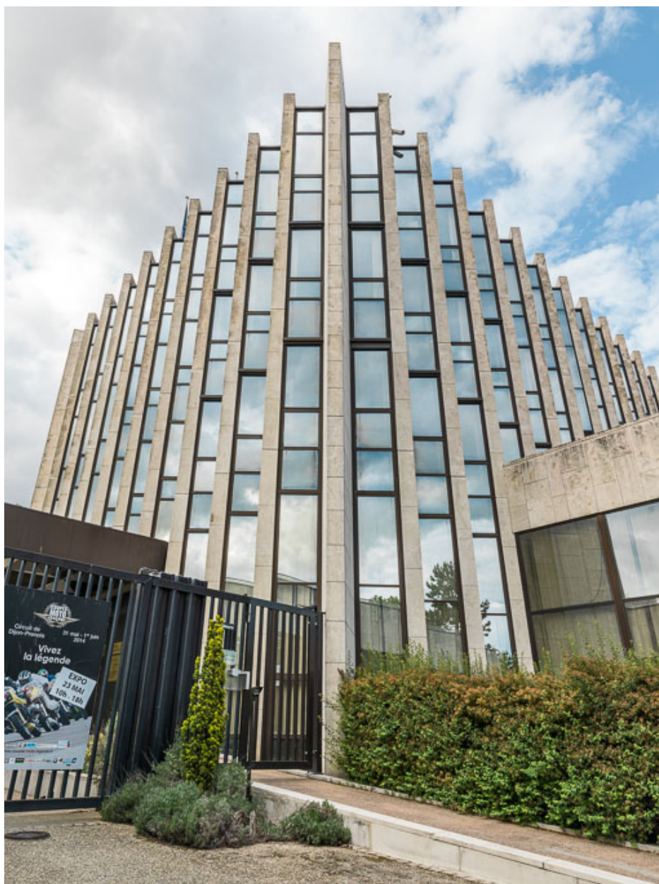
Façades latérale et postérieure, angle sud-ouest.
