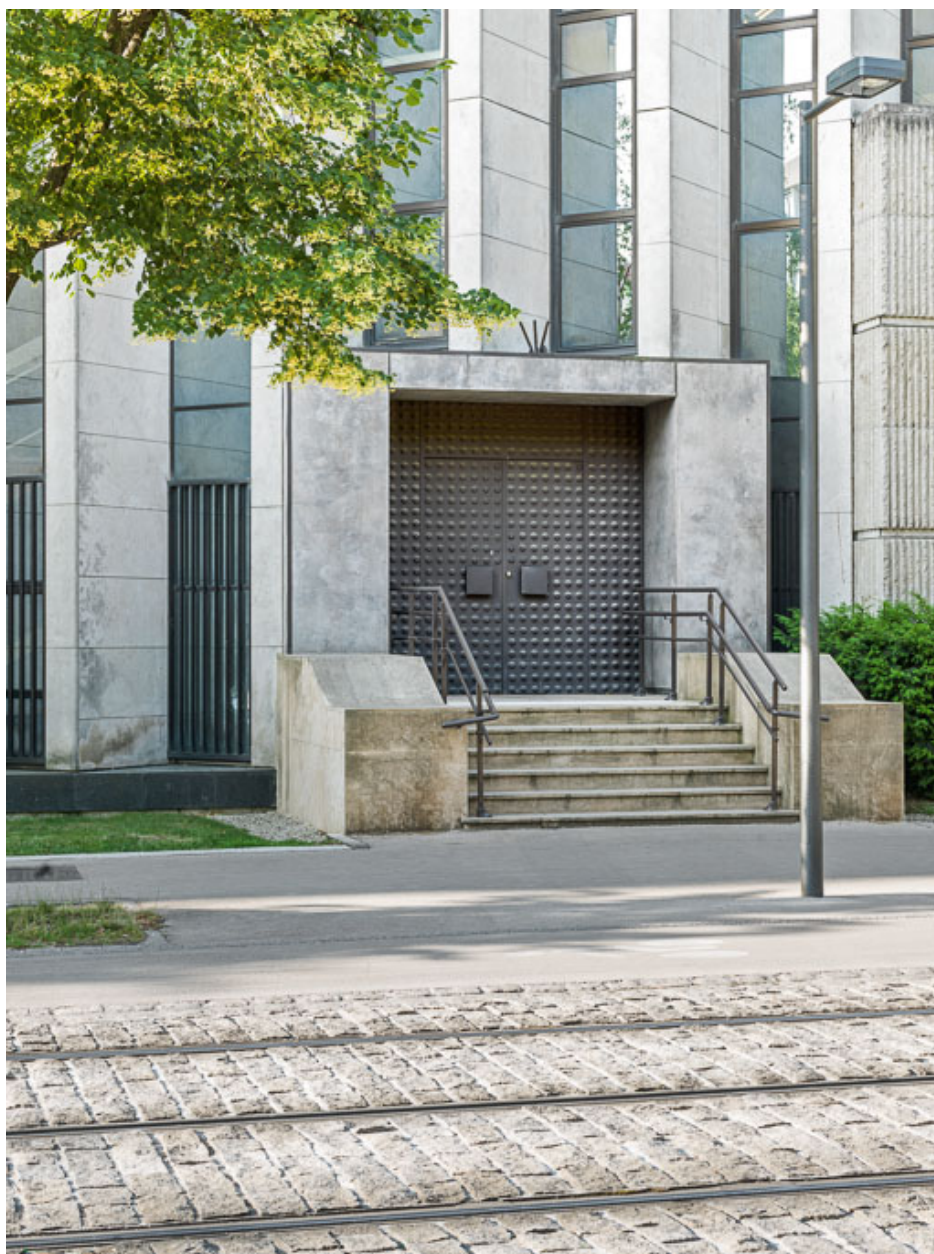
Façade antérieure : porte est.
