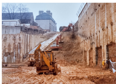
Vue du chantier en novembre 1977 : terrassement pleine
