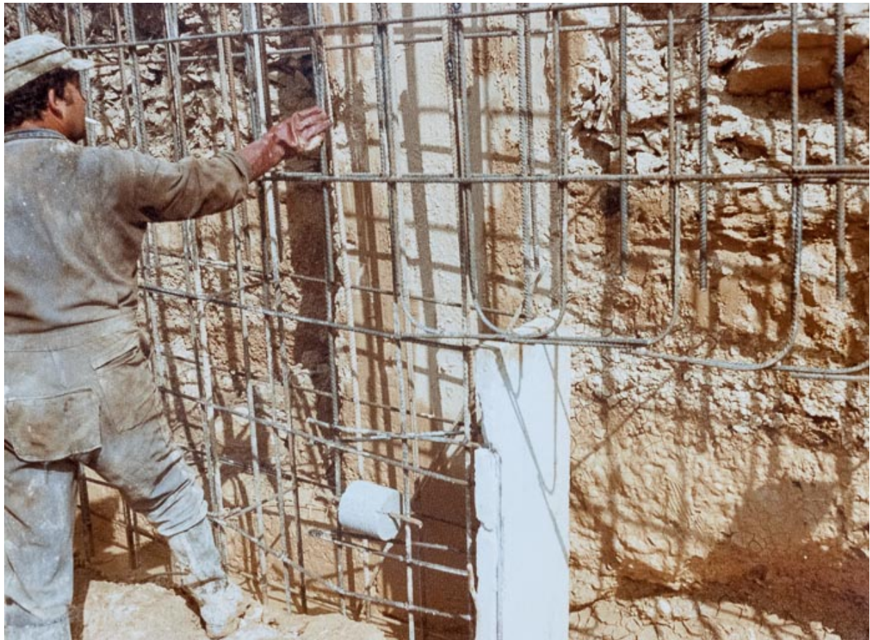
Vue du chantier en juillet 1977 : détail de dalle en béton maigre avec aciers en attente pour entrejambe. Photographie ancienne. (Archives départementales de la Côte-d'Or, Dijon, 32 J 57)
