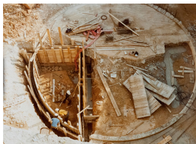
Vue du chantier en mai 1978 : fondations et coffrage de la cuve à fuel enterrée. Photographie ancienne. (Archives départementales de la Côte-d'Or, Dijon, 32 J 57) Phot. Pierre-Marie Barbe-Richaud IVR26_20142100599NUC2A
