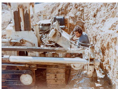
Vue du chantier en juillet 1977 : tête de forage avant pénétration. Photographie ancienne. (Archives départementales de la Côte-d'Or, Dijon, 32 J 57) Phot. Pierre-Marie Barbe-Richaud IVR26_20142100578NUC2A
