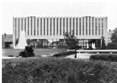
Hôtel de région : façade postérieure et jardin. Photographie ancienne, ca. 1990-1995. (Archives Conseil régional de Bourgogne) Phot. Pierre-Marie Barbe-Richaud, Autr. Paysant IVR26_20142102412NUC2
