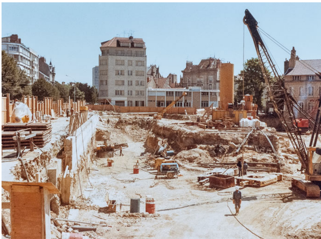
Vue du chantier en juillet 1977 : réalisation de la paroi moulée et première phase de terrassement. Photographie ancienne. (Archives départementales de la Côte-d'Or, Dijon, 32 J 57)
