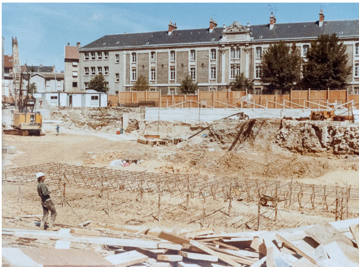
Vue du chantier en juillet 1977 : ferrailage d'un panneau de paroi moulée. Photographie ancienne. (Archives départementales de la Côte-d'Or, Dijon, 32 J 57)
