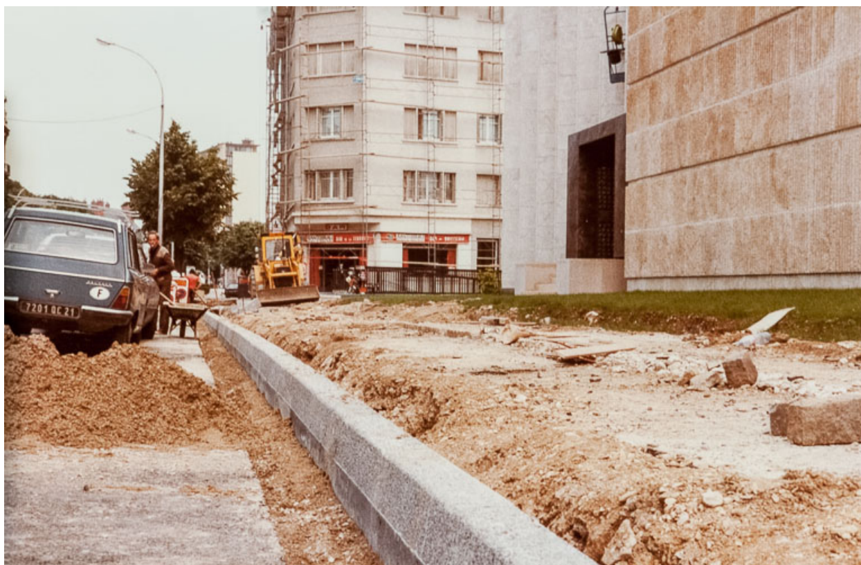
Vue du chantier en juin 1980 : installation des bordures de trottoir. Photographie ancienne. (Archives départementales de la Côte-d'Or, Dijon, 32 J 57)
