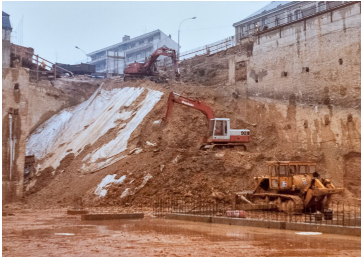
Vue du chantier en novembre 1977 : fin du terrassement d'une rampe et fondation d'un voile de béton au premier plan. Photographie ancienne. (Archives départementales de la Côte-d'Or, Dijon, 32 J 57)
