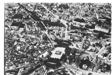
Vue aérienne de Dijon où l'on aperçoit les anciennes constructions présentes sur les deux îlots avant la réalisation de l'hôtel de région. (Carte postale ancienne, ca. 1900-1920, collection privée). Phot. Pierre-Marie Barbe-Richaud, Autr. Paysant IVR26_20142102219NUC2
