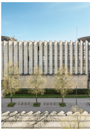
Vue de la façade antérieure centrée sur le parement matérialisant la salle des Assemblées. Phot. Pierre-Marie Barbe-Richaud IVR26_20142102122NUC4AQ
