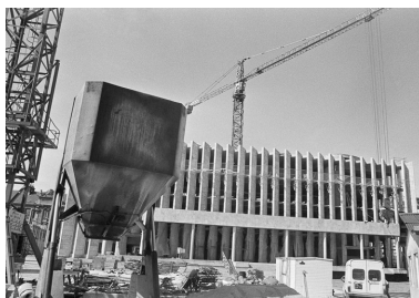
Chantier de construction de l'hôtel de région. Photographie ancienne, août 1979. (Archives du quotidien Le Bien Public, Dijon) Phot. Pierre-Marie Barbe- Richaud, Autr. Paysant IVR26_20142102210NUC2
