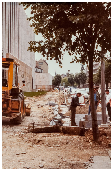
Vue du chantier en juin 1980 : installation des bordures de trottoir. Photographie ancienne. (Archives départementales de la Côte-d'Or, Dijon, 32 J 57) Phot. Pierre-Marie Barbe-Richaud IVR26_20142100593NUC2A
