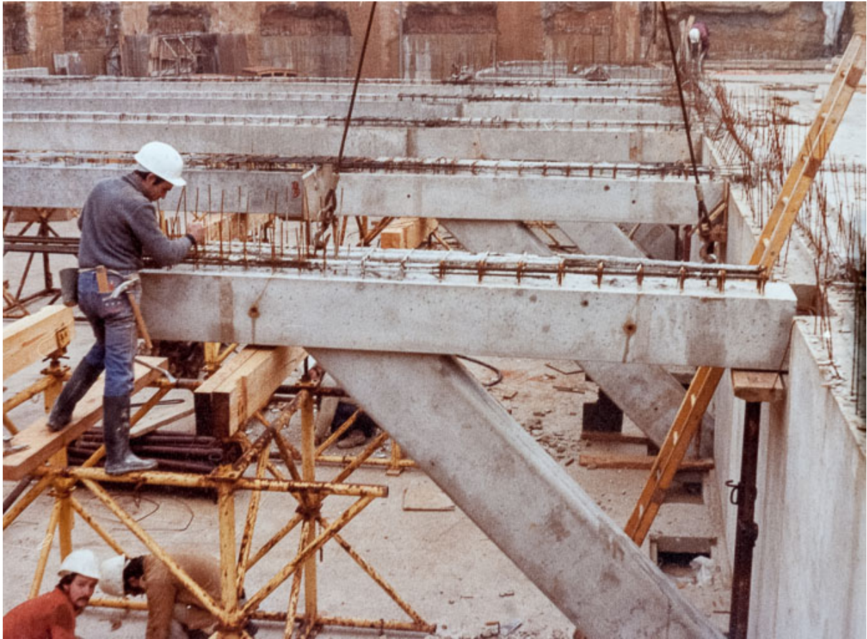
Vue du chantier en février 1978 : mise en place d'un bracon en travée T1 au cinquième niveau du sous-sol. Photographie ancienne. (Archives départementales de la Côte-d'Or, Dijon, 32 J 57)
