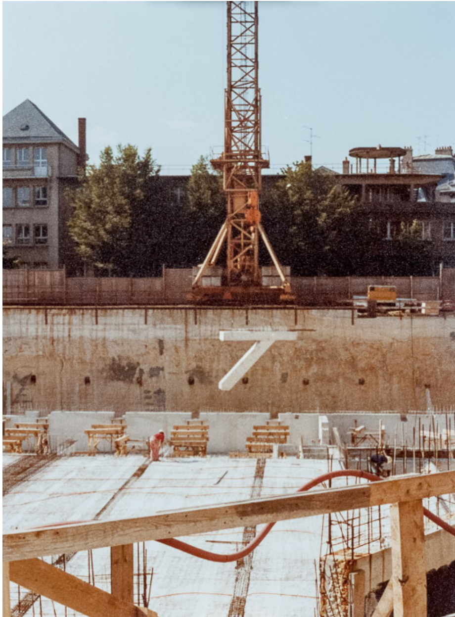
Vue du chantier en mai 1978 : plancher du deuxième niveau du sous-sol et transport d'un bracon. Photographie ancienne. (Archives départementales de la Côte-d'Or, Dijon, 32 J 57)
