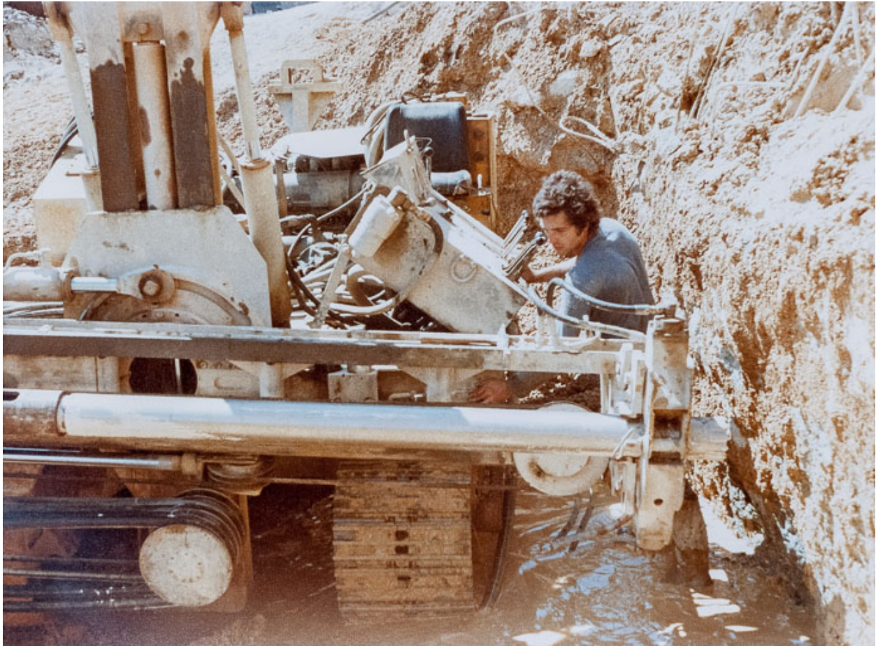
Vue du chantier en juillet 1977 : tête de forage avant pénétration. Photographie ancienne. (Archives départementales de la Côte-d'Or, Dijon, 32 J 57)
