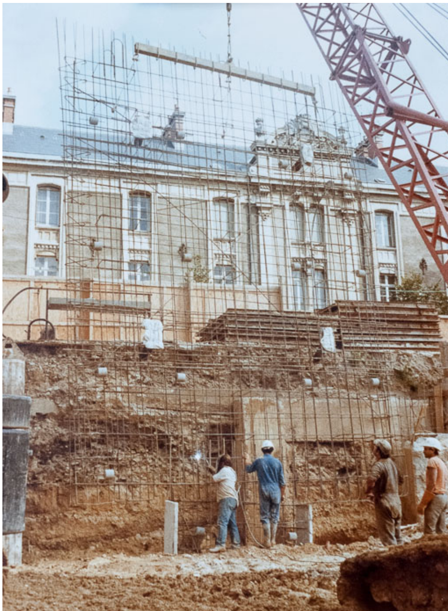
Vue du chantier en juillet 1977 : mise en place d'un panneau de ferrailage. Photographie ancienne. (Archives départementales de la Côte-d'Or, Dijon, 32 J 57)
