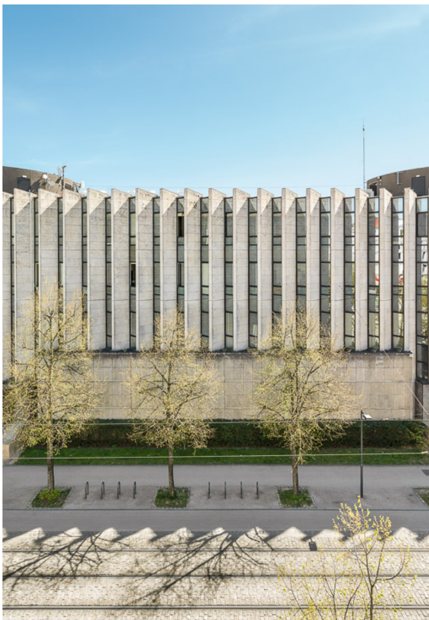
Vue de la façade antérieure centrée sur le parement matérialisant la salle des Assemblées.
