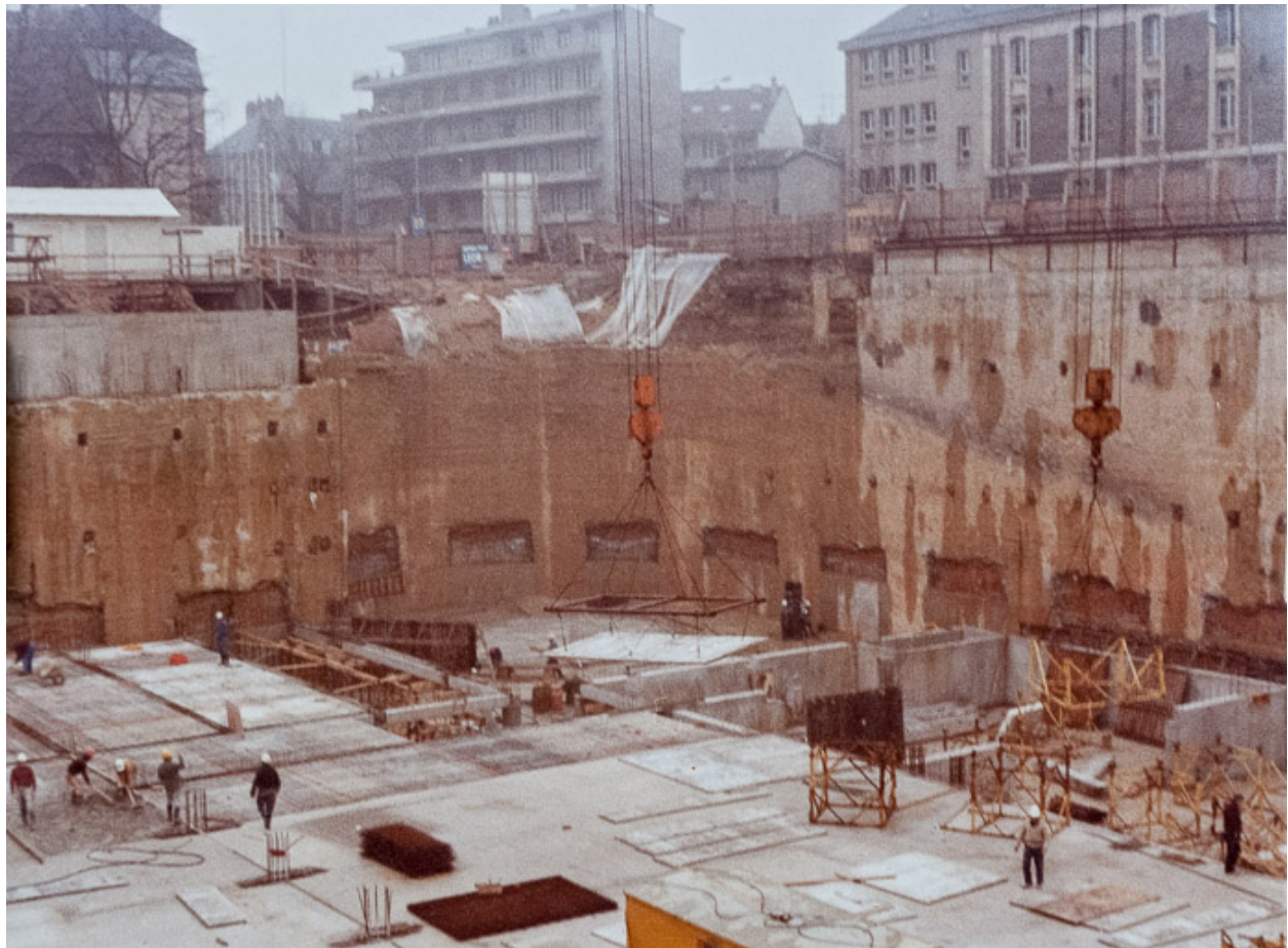
Vue du chantier en février 1978 : transport d'une prédalle pour sa mise en place. Photographie ancienne. (Archives départementales de la Côte-d'Or, Dijon, 32 J 57)
