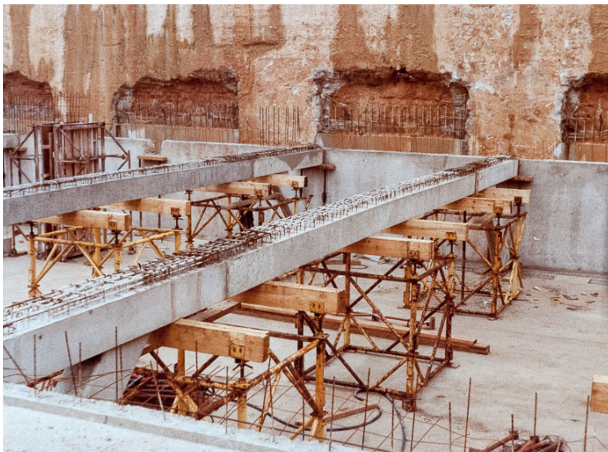
Vue du chantier en février 1978 : un portique courant et son étaieement dans la travée T1 au cinquième niveau du sous-sol. Photographie ancienne. (Archives départementales de la Côte-d'Or, Dijon, 32 J 57)
