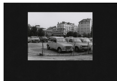
Vue depuis le sud du site servant de parking après la démolitions des anciennes constructions. Photographie ancienne, août 1975. (Archives départementales de la Côte-d'Or, Dijon, 32 J 48) Phot. Petot Frédéric IVR26_20142100637NUC2A
