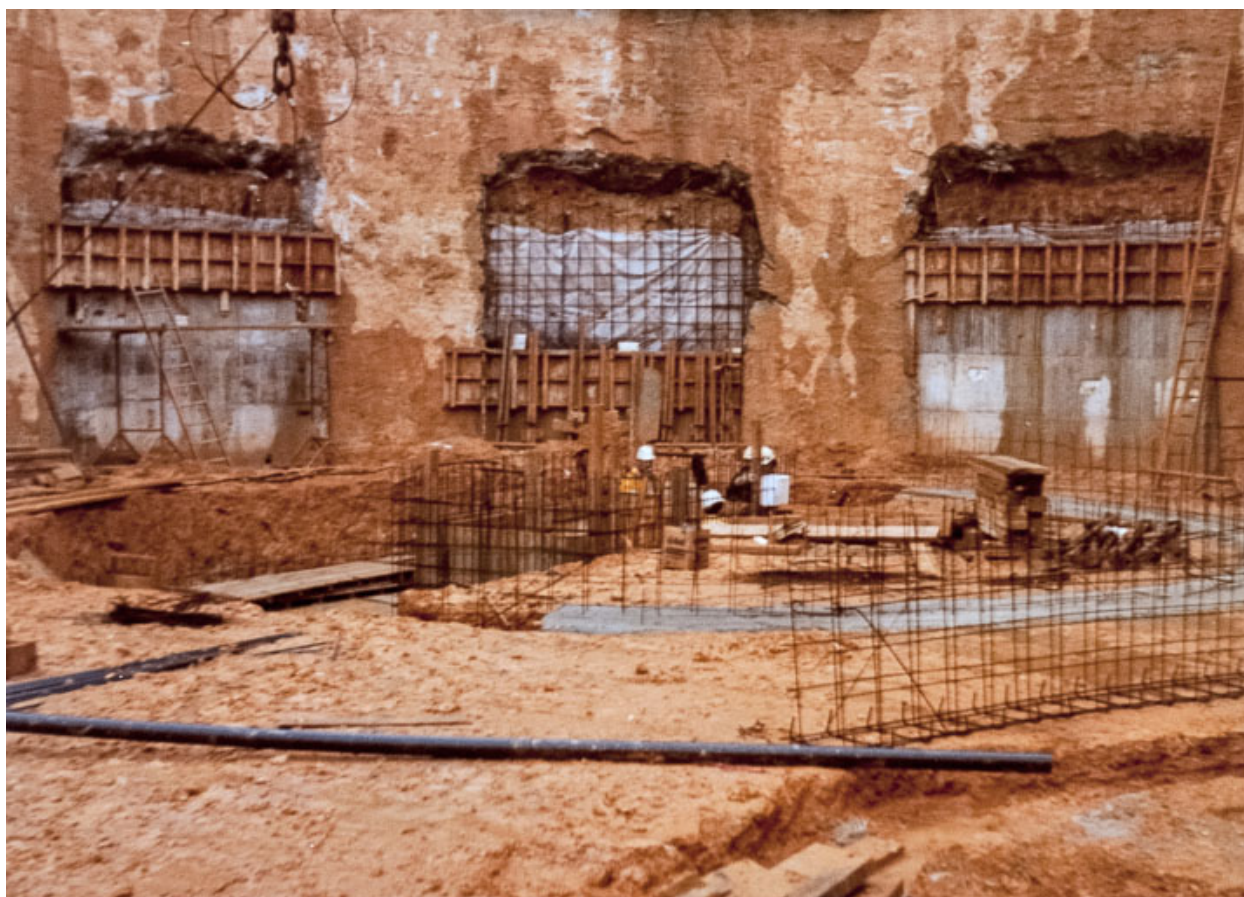
Vue du chantier en novembre 1977 : fondation de la fosse de décantation du parking. Photographie ancienne. (Archives départementales de la Côte-d'Or, Dijon, 32 J 57)
