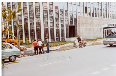
Vue du chantier en juin 1980 : installation des bordures de trottoir. Photographie ancienne. (Archives départementales de la Côte-d'Or, Dijon, 32 J 57) Phot. Pierre-Marie Barbe-Richaud IVR26_20142100594NUC2A
