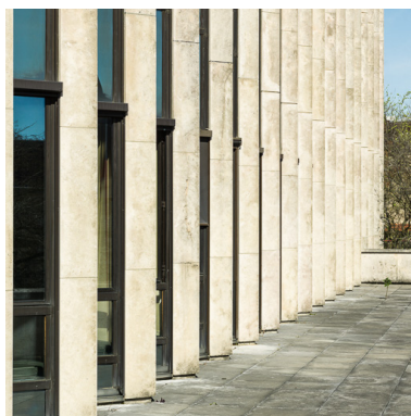
Façade postérieure : travées du premier étage depuis le toit-terrasse de la galerie. Phot. Pierre-Marie Barbe-Richaud IVR26_20142102123NUC2A
