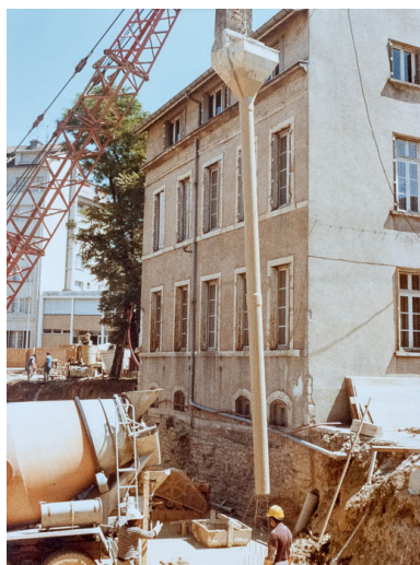
Vue du chantier en juillet 1977 : tube plongeur avant coulage du béton de paroi moulé. Photographie ancienne. (Archives départementales de la Côte-d'Or, Dijon, 32 J 57) Phot. Pierre-Marie Barbe-Richaud IVR26_20142100573NUC2A
