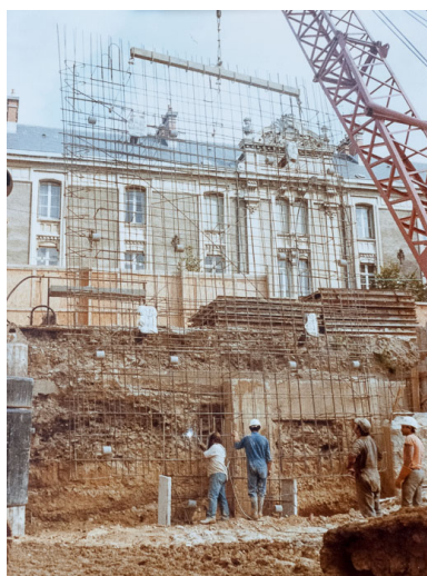
Vue du chantier en juillet 1977 : mise en place d'un panneau de ferrailage. Photographie ancienne. (Archives départementales de la Côte-d'Or, Dijon, 32 J 57) Phot. Pierre-Marie Barbe-Richaud IVR26_20142100570NUC2A
