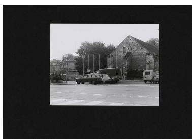
Boulevard de la Trémouille, façade nord du Cellier de Clairvaux et bâtiment du conseil général (arrière-plan). Photographie ancienne, août 1975. (Archives départementales de la Côte-d'Or, Dijon, 32 J 48)
