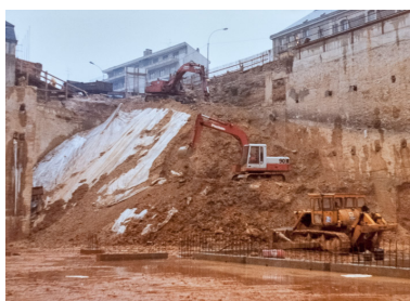
Vue du chantier en novembre 1977 : fin du terrassement d'une rampe
