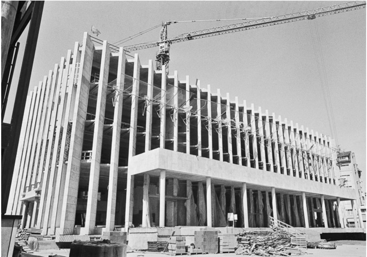
Chantier de construction de l'hôtel de région. Photographie ancienne, août 1979. (Archives du quotidien Le Bien Public, Dijon)
