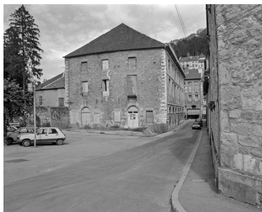
Vue d'ensemble depuis le sud-ouest (1987). Phot. Yves Sancey IVR43_19873900030X
