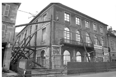
Le théâtre en chantier. Vue depuis le sud-est, s.d. [1988]. IVR43_20243900935NUC2A
