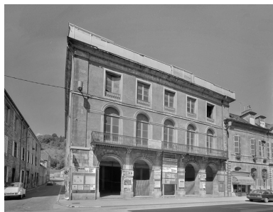
Vue de la façade est avant déconstruction (1987). Phot. Yves Sancey IVR43_19873900027V
