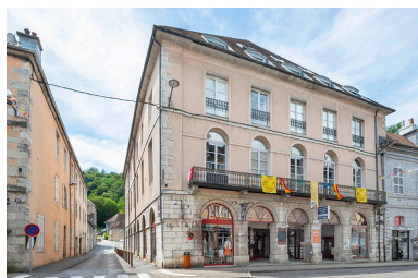
Vue de trois quarts droite. Phot. Jérôme Mongreville IVR43_20233900848NUC4A
