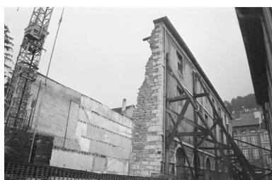
Le théâtre en chantier. Vue depuis le sud-ouest, s.d. [1988]. IVR43_20243900937NUC2A
