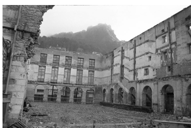
Le théâtre en chantier. Le bâtiment vidé, s.d. [1988]. IVR43_20243900939NUC2A
