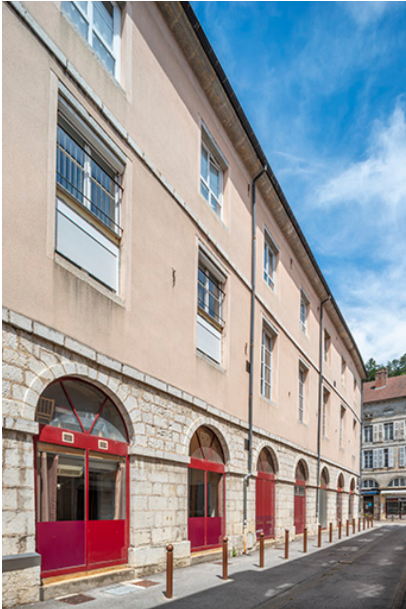
Façade sud, vue de trois quarts.
