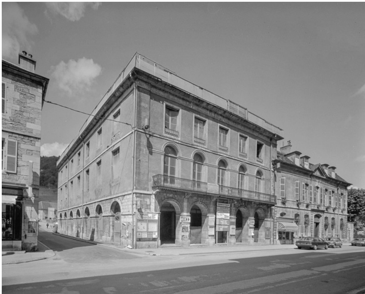
Vue avant déconstruction (1987).
