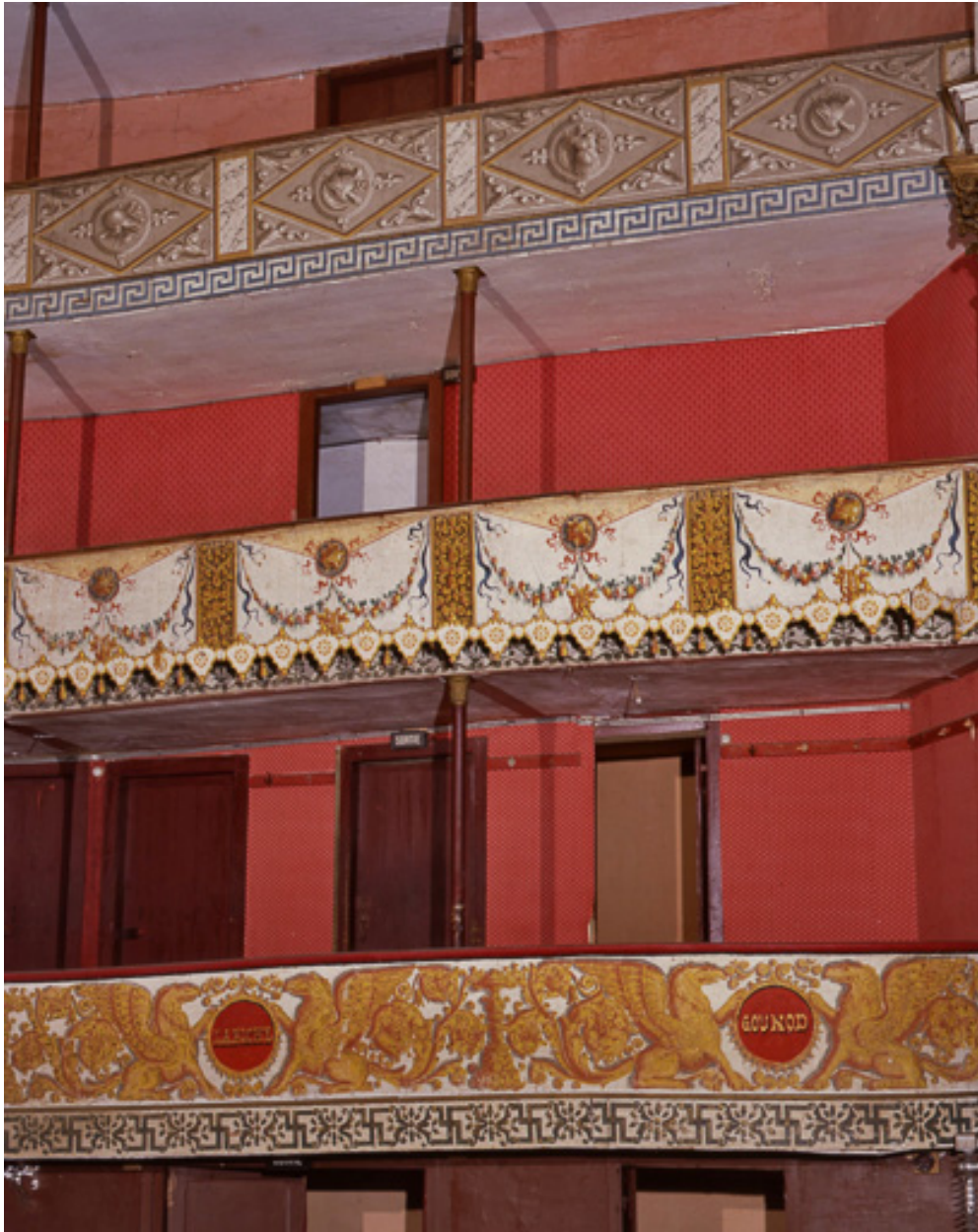
Elévation des balcons et décor peint (1987).
