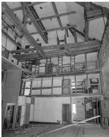
Vue des cintres (1987). Phot. Yves Sancey IVR43_19873900040X
