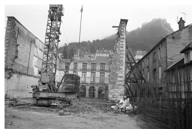
Le théâtre en chantier. Vue depuis l'ouest, s.d. [1988]. IVR43_20243900938NUC2A
