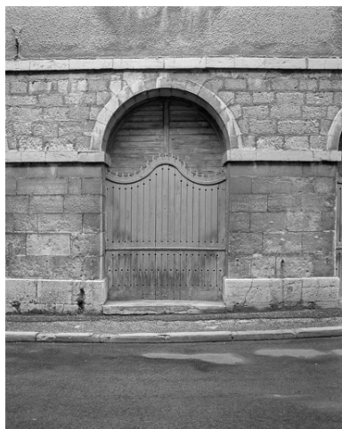
Porte de la façade sud (1987). Phot. Yves Sancey IVR43_19873900032X
