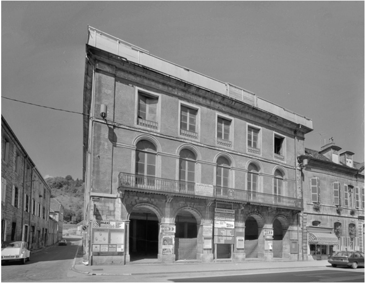
Vue de la façade est avant déconstruction (1987).
