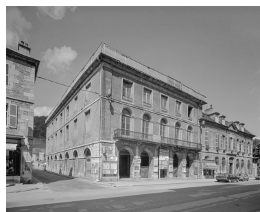
Vue avant déconstruction (1987). Phot. Yves Sancey IVR43_19873900026V
