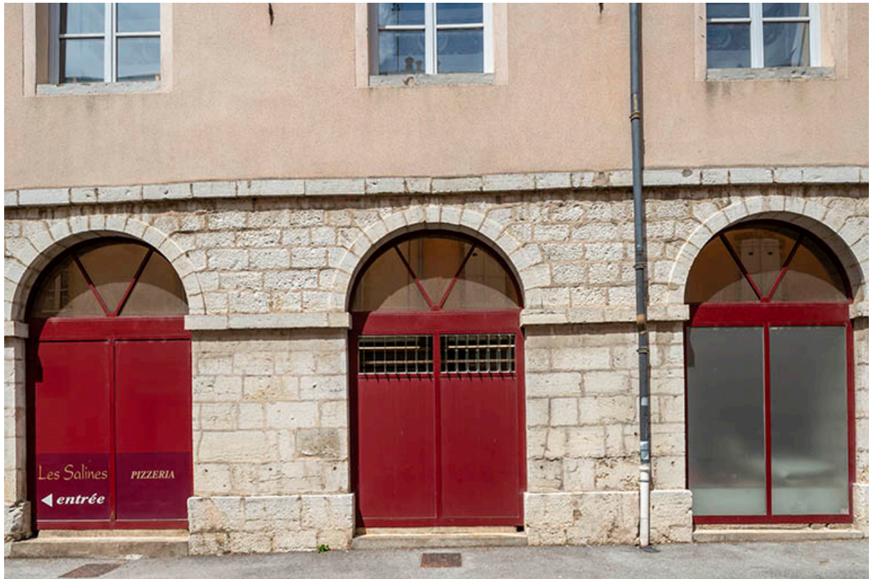
Portes de la façade sud.
