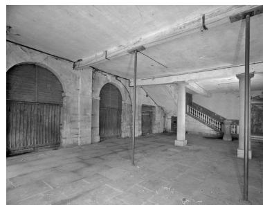
Esplanade du marché couvert et escalier sud (1987). Phot. Yves Sancey IVR43_19873900028V
