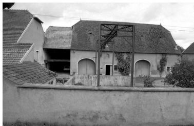
Vue du bâtiment agricole. Phot. Bernard Lardière IVR43_19817000380Z
