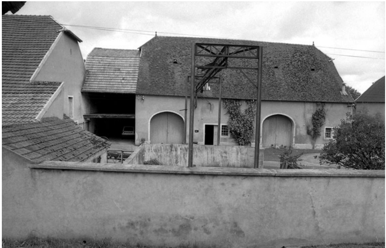
Vue du bâtiment agricole.
