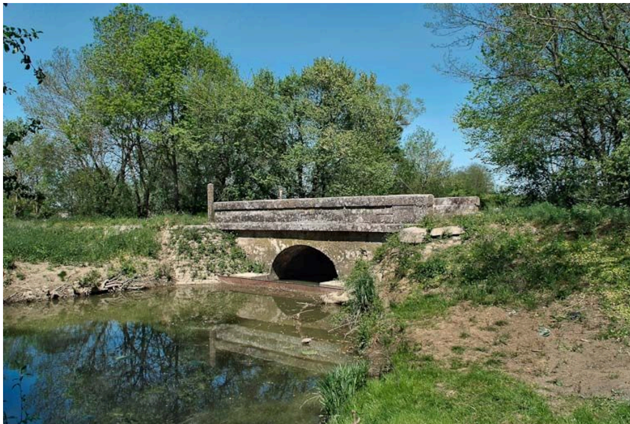
Ponceau sur un ancien lit de la Seille.
