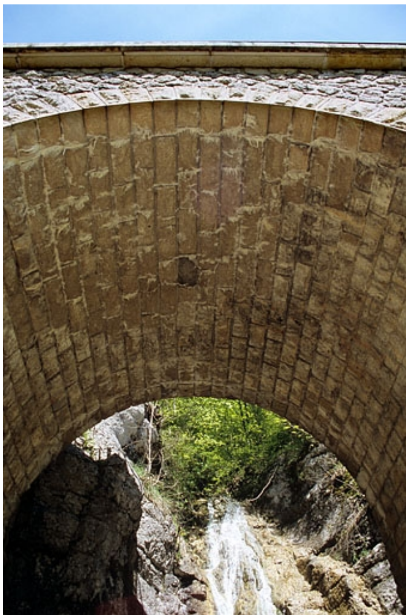
Viaduc : arche, vue du dessous.
