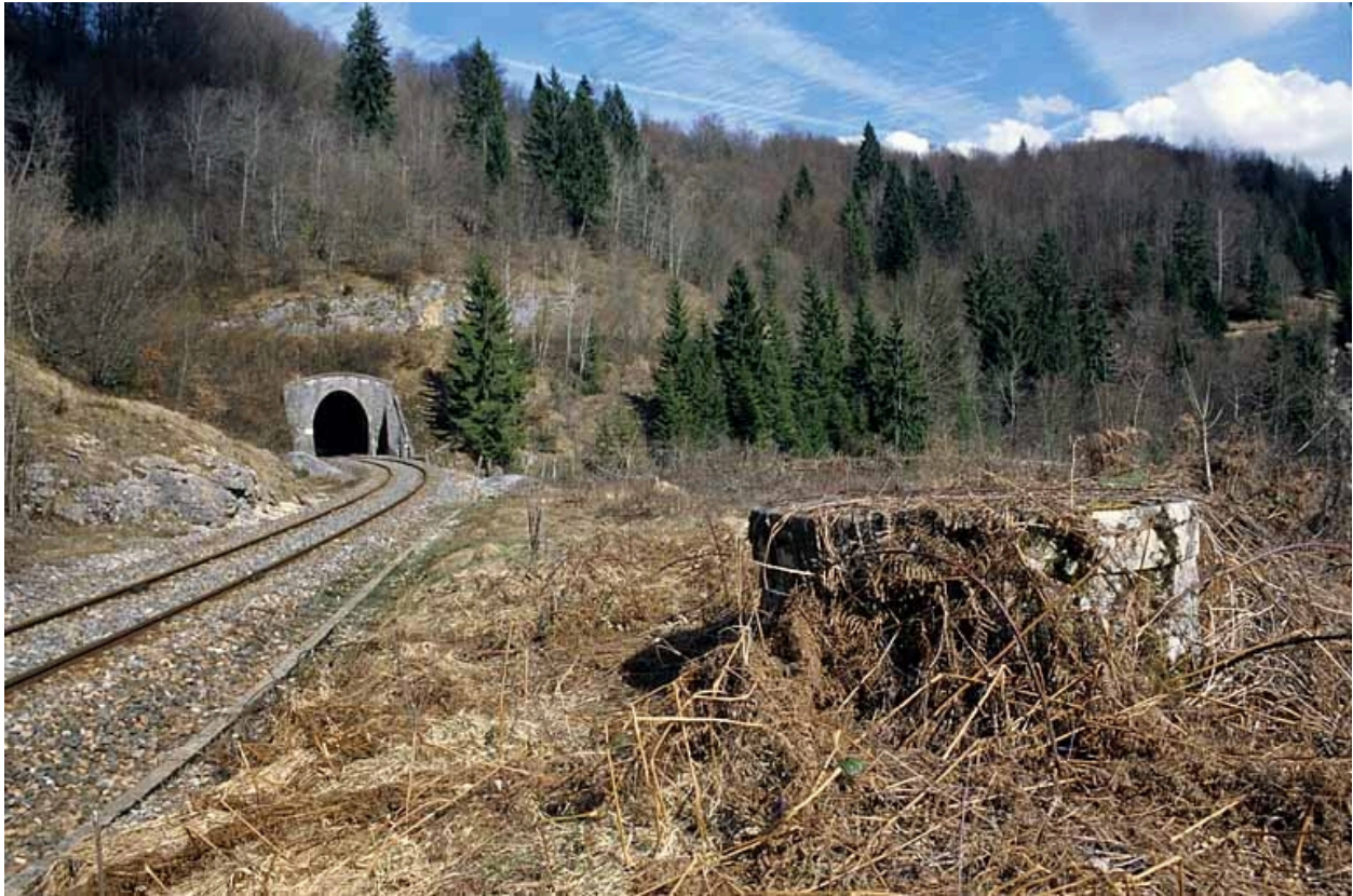
Vue d'ensemble, depuis le côté La Cluse (ouest). Au premier plan, puits de la maison de garde-barrière n° 42 (détruite).
