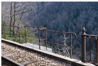
Garde-corps métalliques du mur (à gauche) et du viaduc (à droite), depuis la voie.
