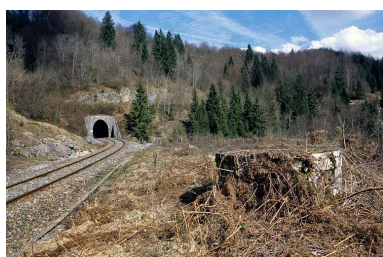
Vue d'ensemble, depuis le côté La Cluse (ouest). Au premier plan, puits de la maison de garde-barrière n° 42 (détruite). Phot. Yves Sancey IVR43_20053900652ZA
