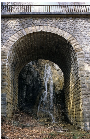
Viaduc : arche, montrant le ruisseau de la Culée.
