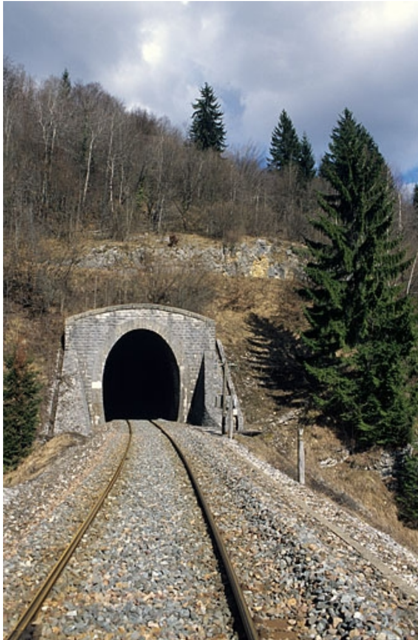
Tunnel : tête côté La Cluse (ouest).
