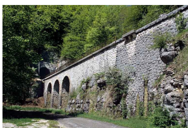
Murs de soutènement et viaduc, depuis le chemin départemental n° 126 à l'est (côté Andelot-en-Montagne). Phot. Yves Sancey IVR43_20053900636ZA
