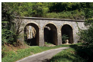
Viaduc, vu de trois quarts gauche. Phot. Yves Sancey IVR43_20053900645ZA
