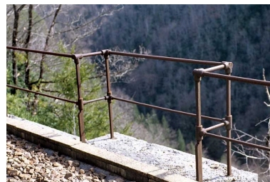
Mur : garde-corps métallique d'un refuge.
