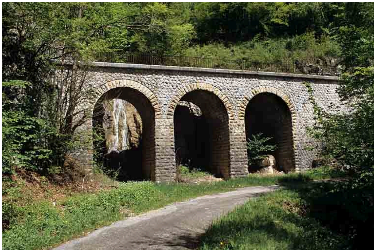
Viaduc, vu de trois quarts gauche.
