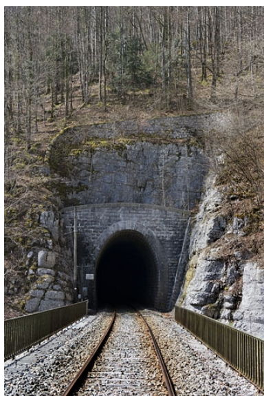
Tunnel : tête côté Andelot-en-Montagne (est).
