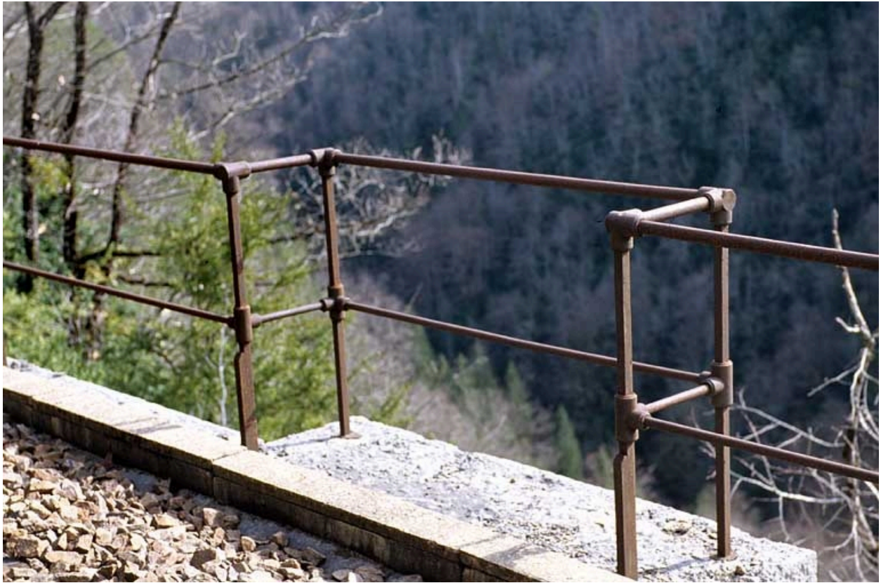
Mur : garde-corps métallique d'un refuge.
