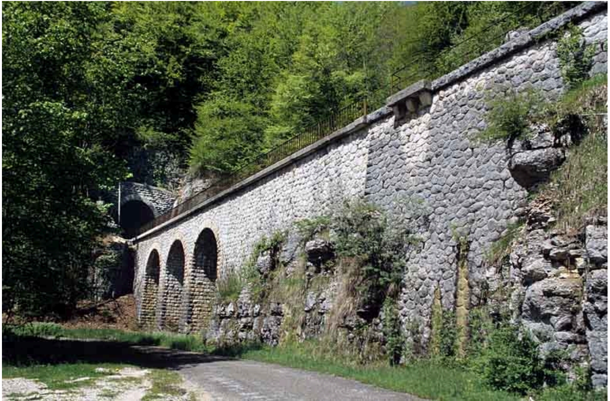
Murs de soutènement et viaduc, depuis le chemin départemental n° 126 à l'est (côté Andelot-en-Montagne).
