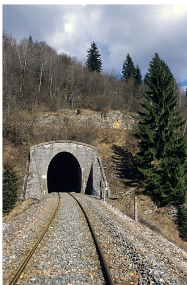
Tunnel : tête côté La Cluse (ouest).
