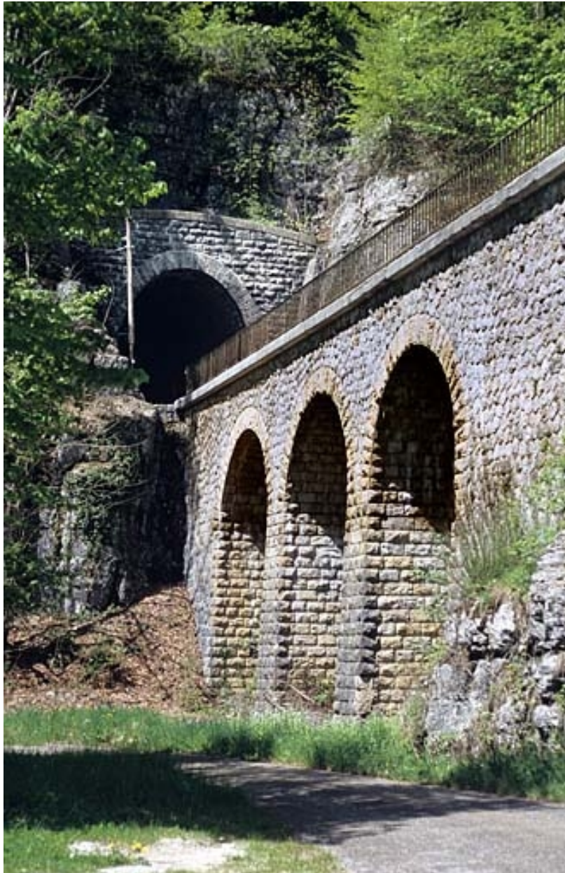
Viaduc et tunnel, depuis le chemin départemental n° 126 à l'est (côté Andelot-en-Montagne).
