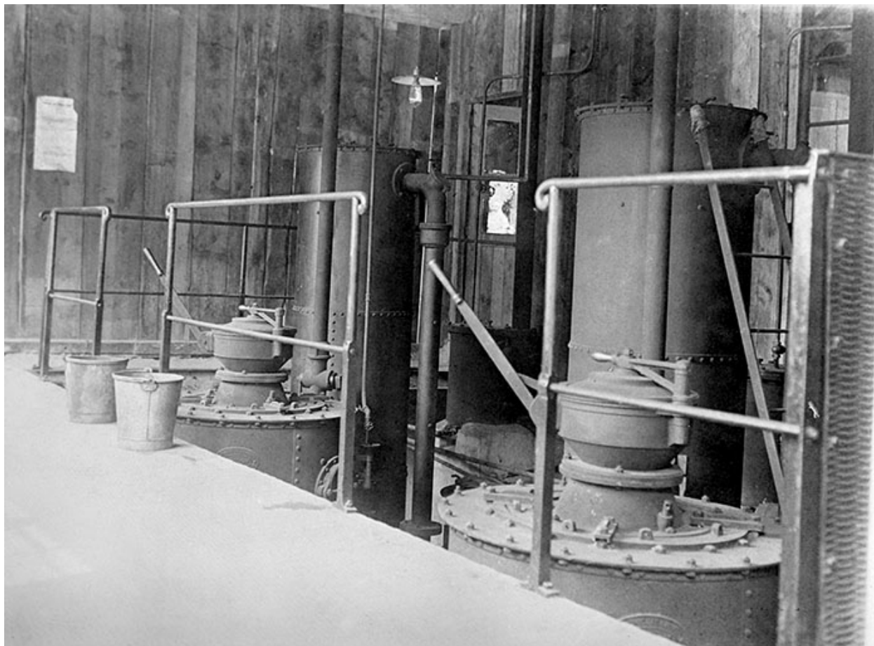
Suction Gas Producers [Gazogène à aspiration en 1910].
