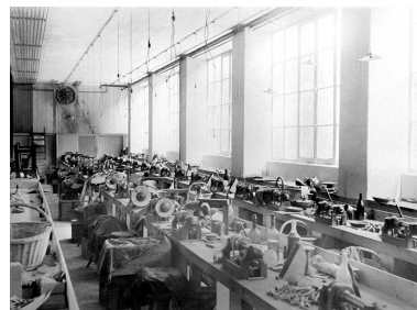
Ground Floor. Polissage [Rez-de-chaussée. Polissage en 1910]. Phot. Jérôme Mongreville IVR43_19923900136X
