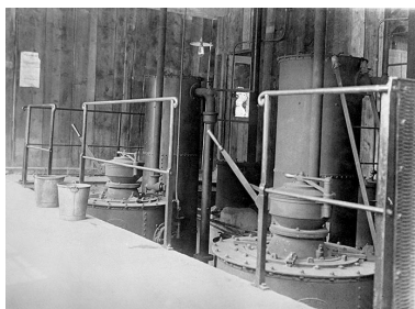
Suction Gas Producers [Gazogène à aspiration en 1910]. Phot. Jérôme Mongreville IVR43_19923900132X
