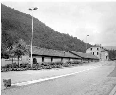
Entrepôts et logement. Phot. Jérôme Mongreville IVR43_19923900492X
