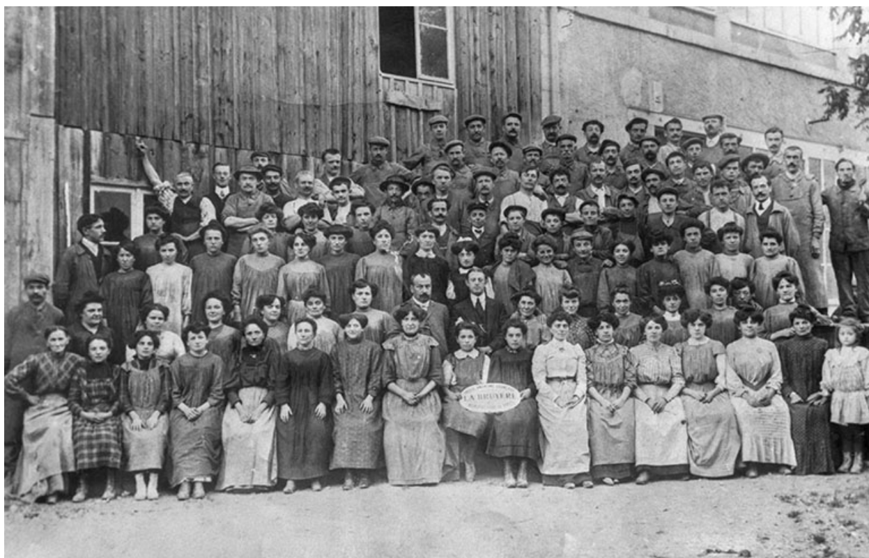
[Le personnel de l'usine].
