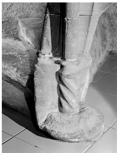
Escalier. Départ du noyau. Phot. Jérôme Mongreville IVR43_19872500573X
