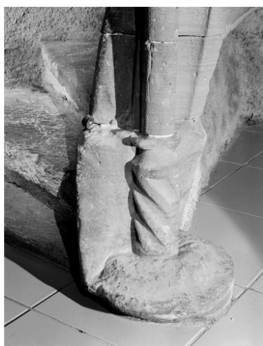
Escalier. Départ du noyau. Phot. Jérôme Mongreville IVR43_19872500573X
