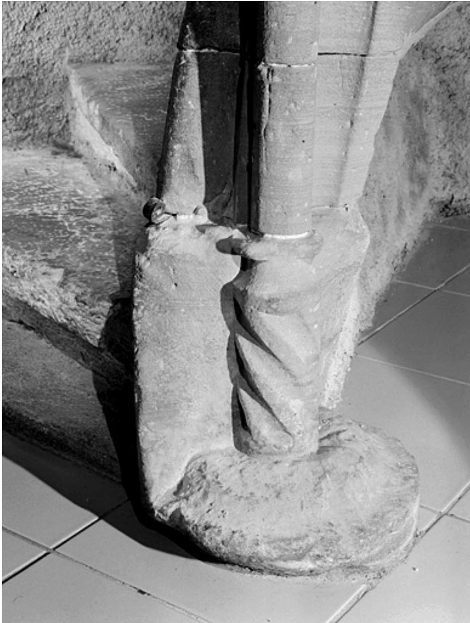
Escalier. Départ du noyau.
