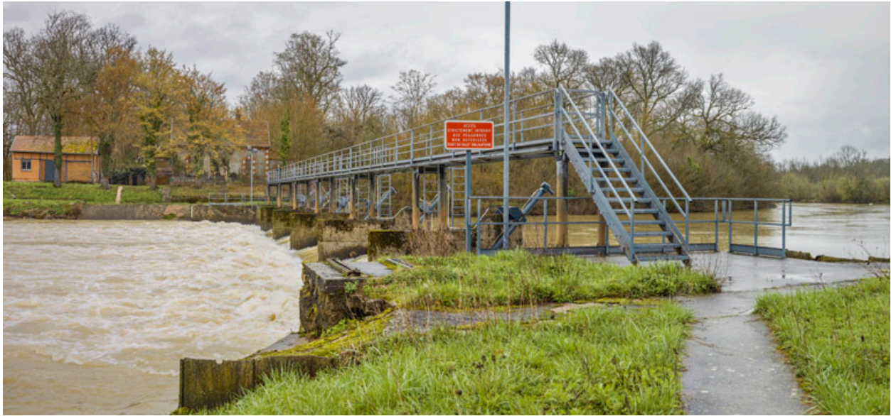
Le barrage, la maison et le magasin à aiguilles.
