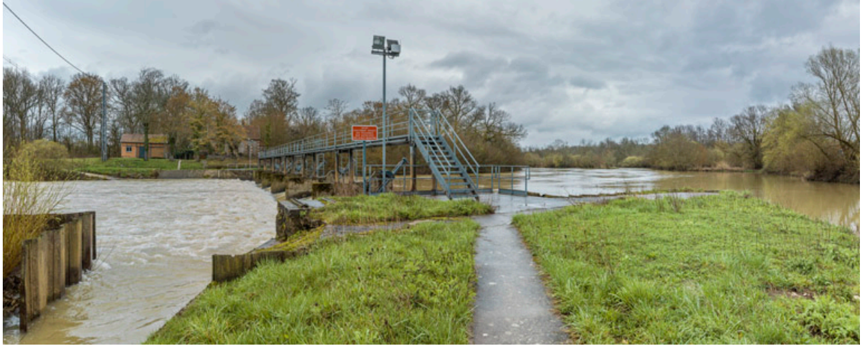
Le barrage, la maison et le magasin à aiguilles.
