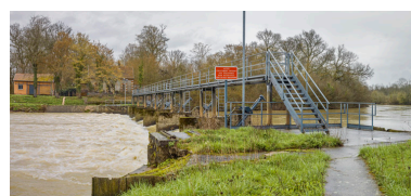
Le barrage, la maison et le magasin à aiguilles. Phot. Thierry Kuntz IVR26_20182100262NUC4A
