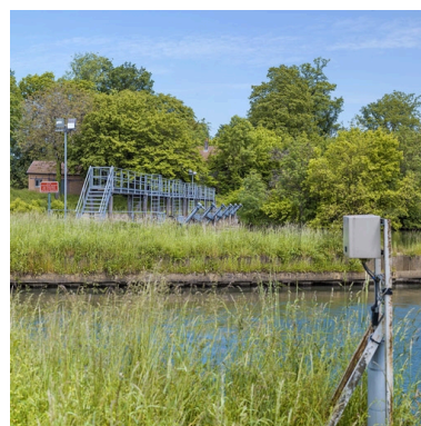
Les vérens du barrage. Phot. Thierry Kuntz IVR26_20162101251NUC4A
