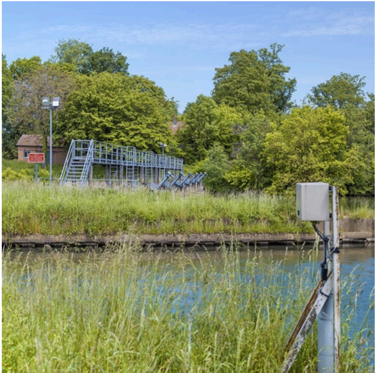
Les vérens du barrage.
