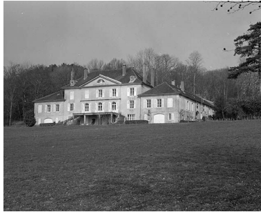
Façade antérieure vue de trois-quarts droit. Phot. Jérôme Mongreville IVR43_19853900066X
