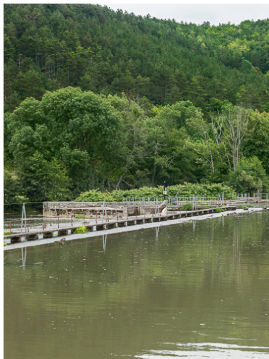
Vue du barrage.
