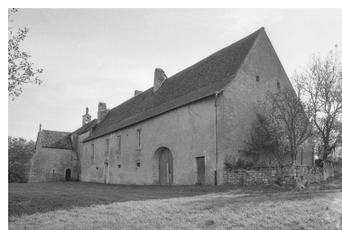
Bâtiment annexe, façade antérieure. Phot. Bernard Lardière IVR43_19797000191Z
