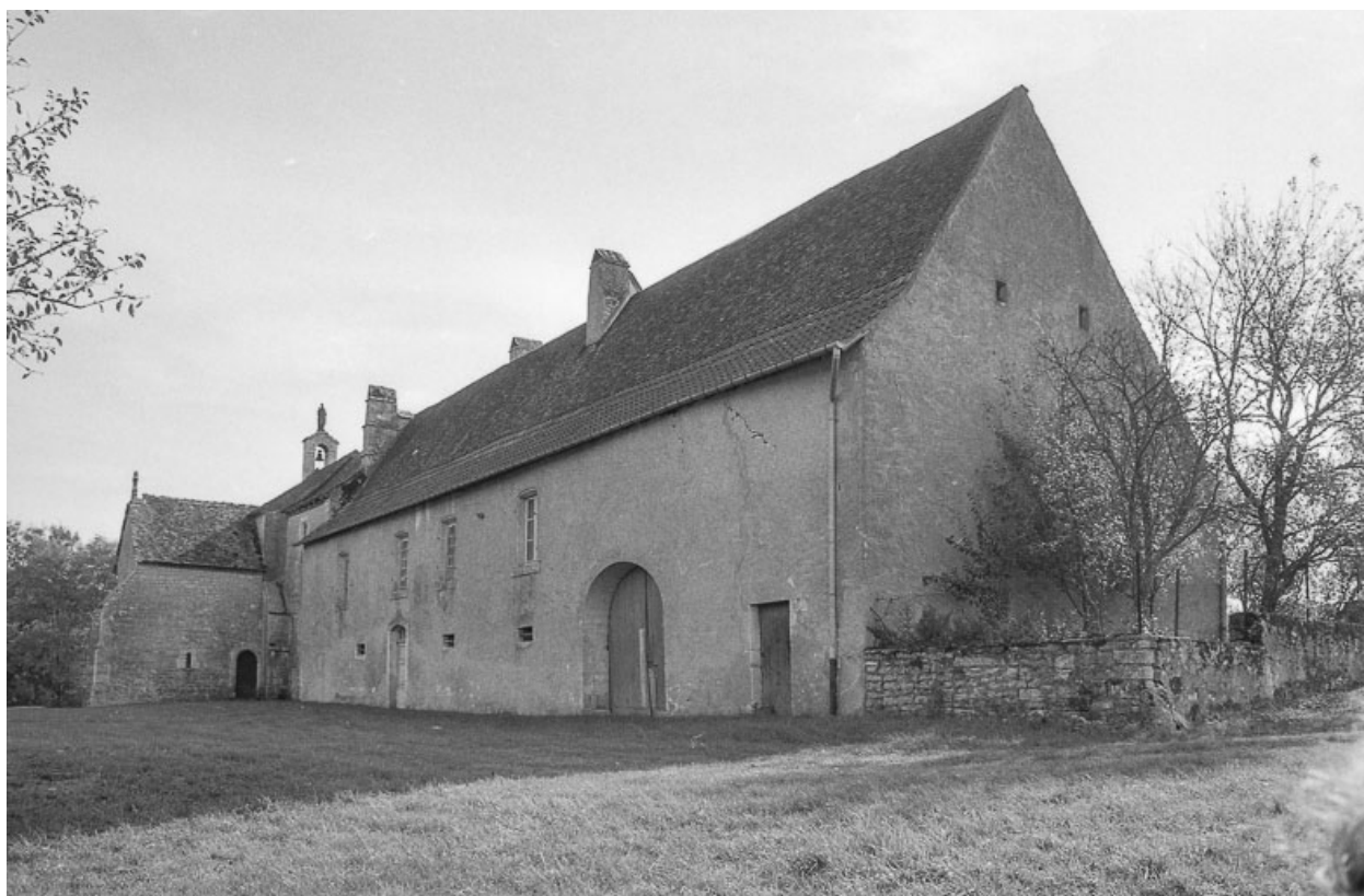
Bâtiment annexe, façade antérieure.
