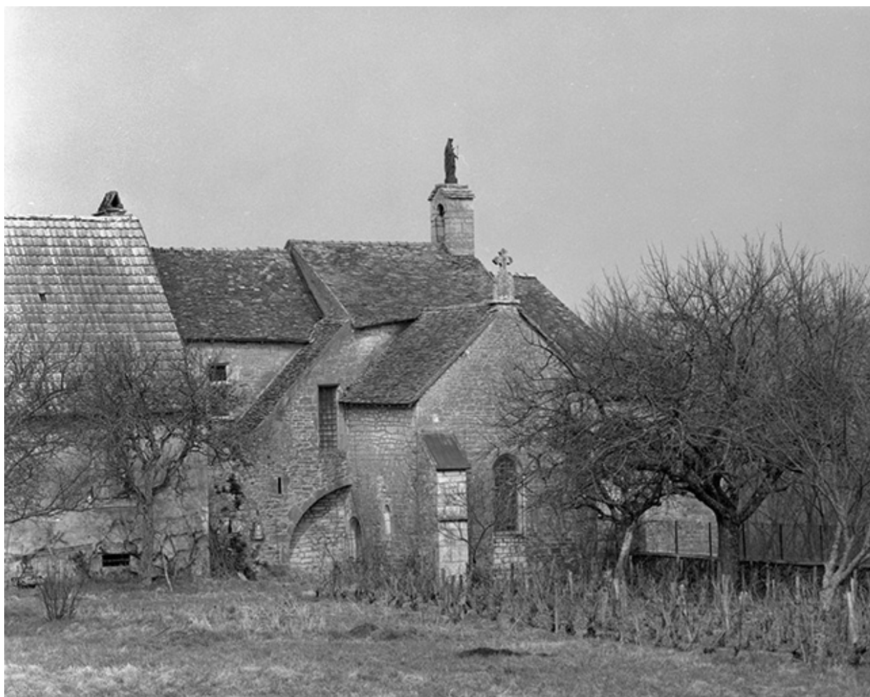
Façade latérale droite.
