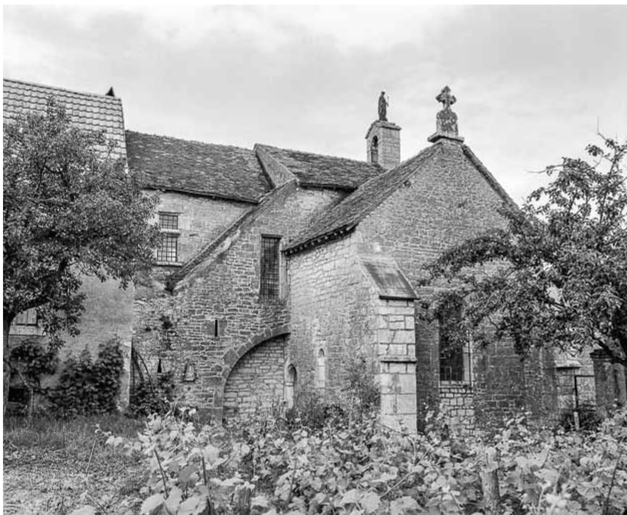
Extérieur : façade latérale droite.
