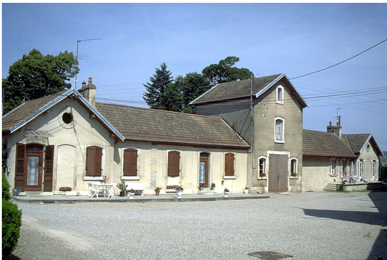
Façade antérieure du logement d'ouvriers.
