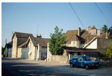
Vue d'ensemble depuis le sud. Phot. Laurent Poupard IVR43_19893900036ZA
