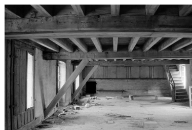
Atelier de fabrication : intérieur de la pièce de séchage du premier étage. Le fond de la pièce est fermé par le conduit d'amenée d'air chaud.
