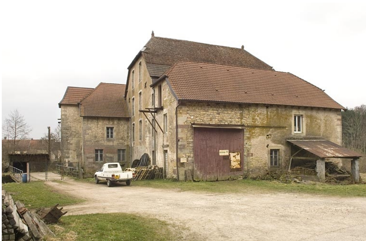
Vue depuis l'ouest.
