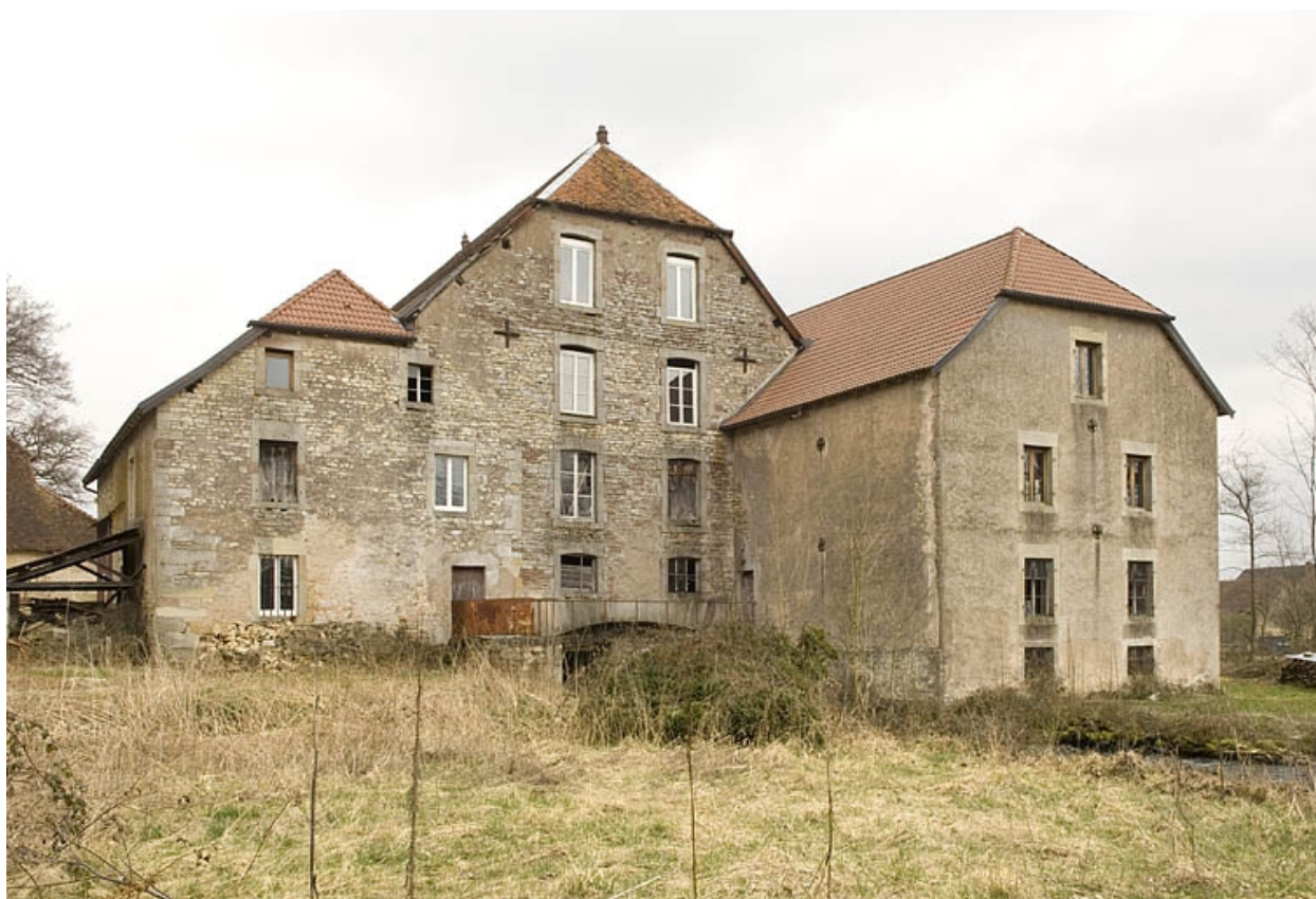
Vue de trois quarts, depuis l'ouest.
