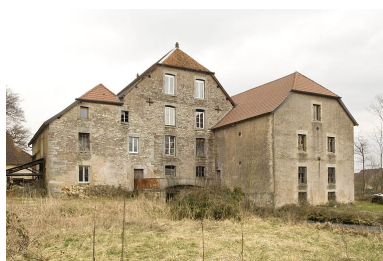
Vue de trois quarts, depuis l'ouest. Phot. Jérôme Mongreville IVR43_20097000239NUC2A
