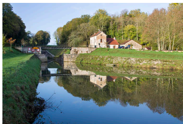
Entrée du canal depuis l'amont.
