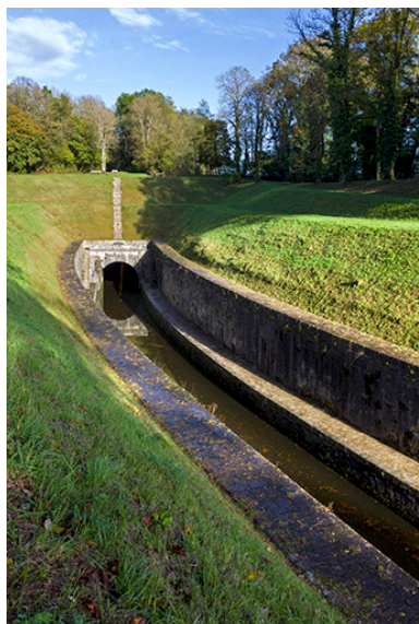
Entrée du tunnel depuis l'aval. Phot. Sonia Dourlot IVR43_20157000229NUC2A
