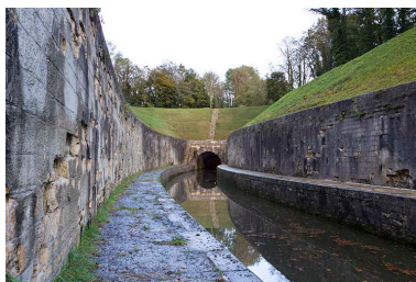
L'entrée du tunnel en aval, vue depuis la banquette de halage. Phot. Sonia Dourlot IVR43_20157000230NUC2A
