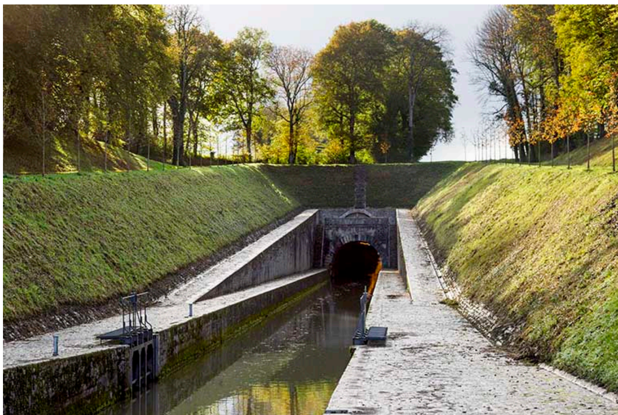
Le canal et le tunnel, vue amont.
