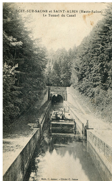
L'entrée amont du tunnel de Saint-Albin, carte postale. IVR43_20197000236NUC4A
