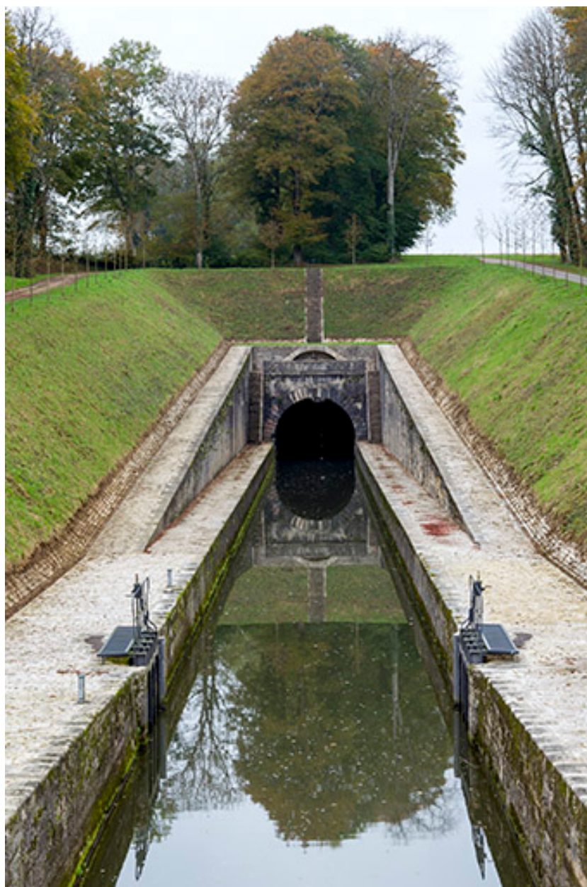
Vue de face de l'entrée du tunnel, vue amont.
