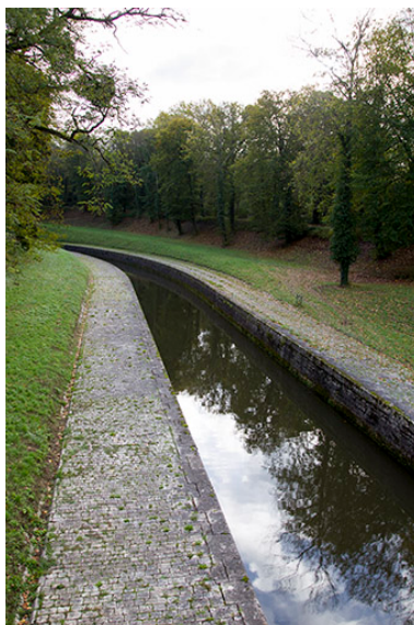
Le canal juste avant de rejoindre la dérivation. Phot. Sonia Dourlot IVR43_20157000234NUC2A
