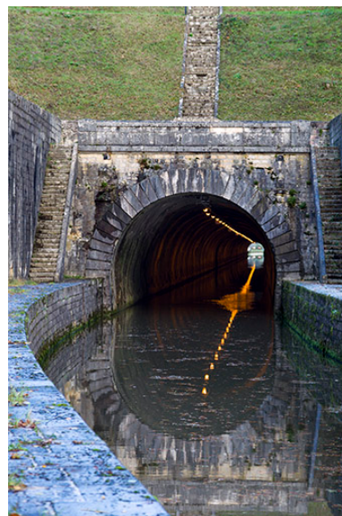
Le tunnel depuis l'aval. Phot. Sonia Dourlot IVR43_20157000232NUC2A
