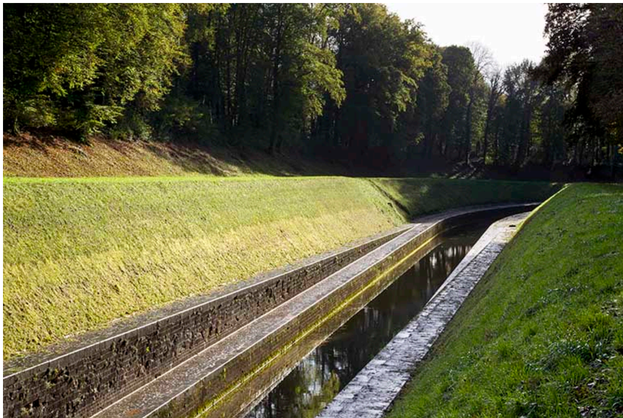
Le canal, vue aval.
