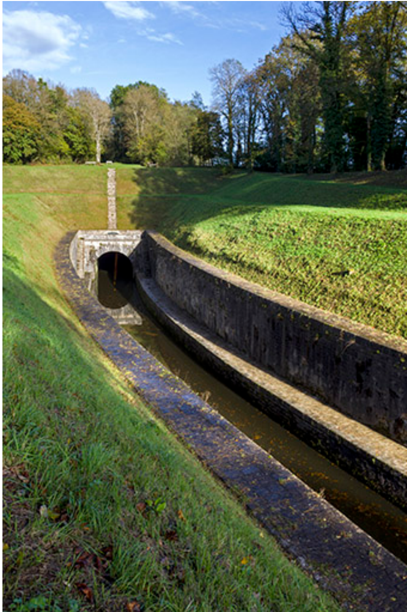
Entrée du tunnel depuis l'aval.
