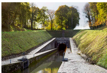
Le canal et le tunnel, vue amont.
