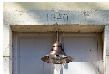
Date portée sur le linteau de la porte d'entrée. Phot. Sonia Dourlot IVR43_20157001003NUC2A
