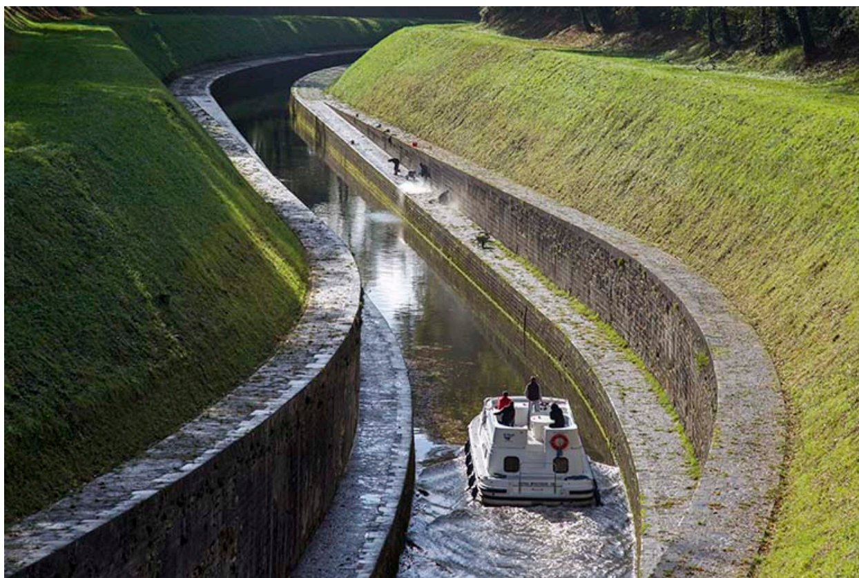
Le canal en aval formant un S.
