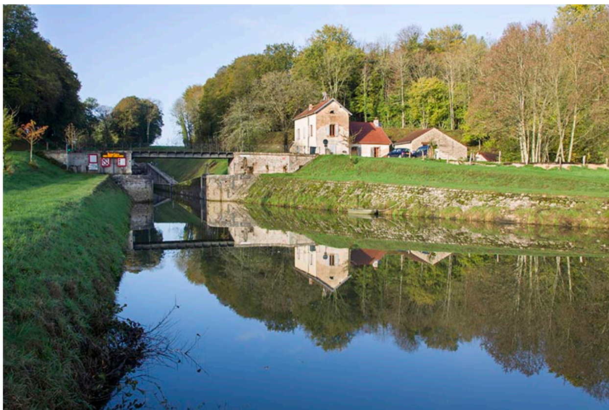
Entrée du canal depuis l'amont.
