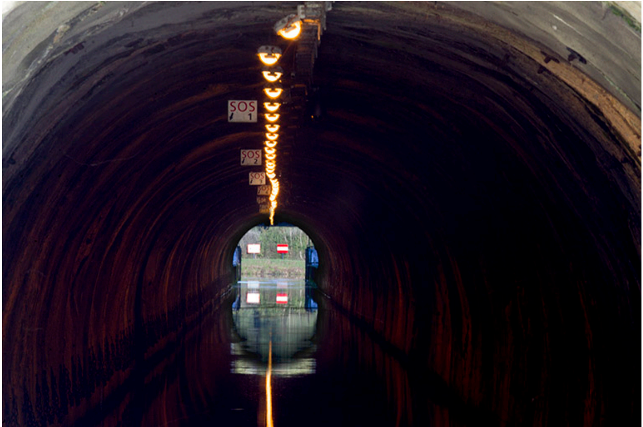
Le tunnel, vue intérieure.
