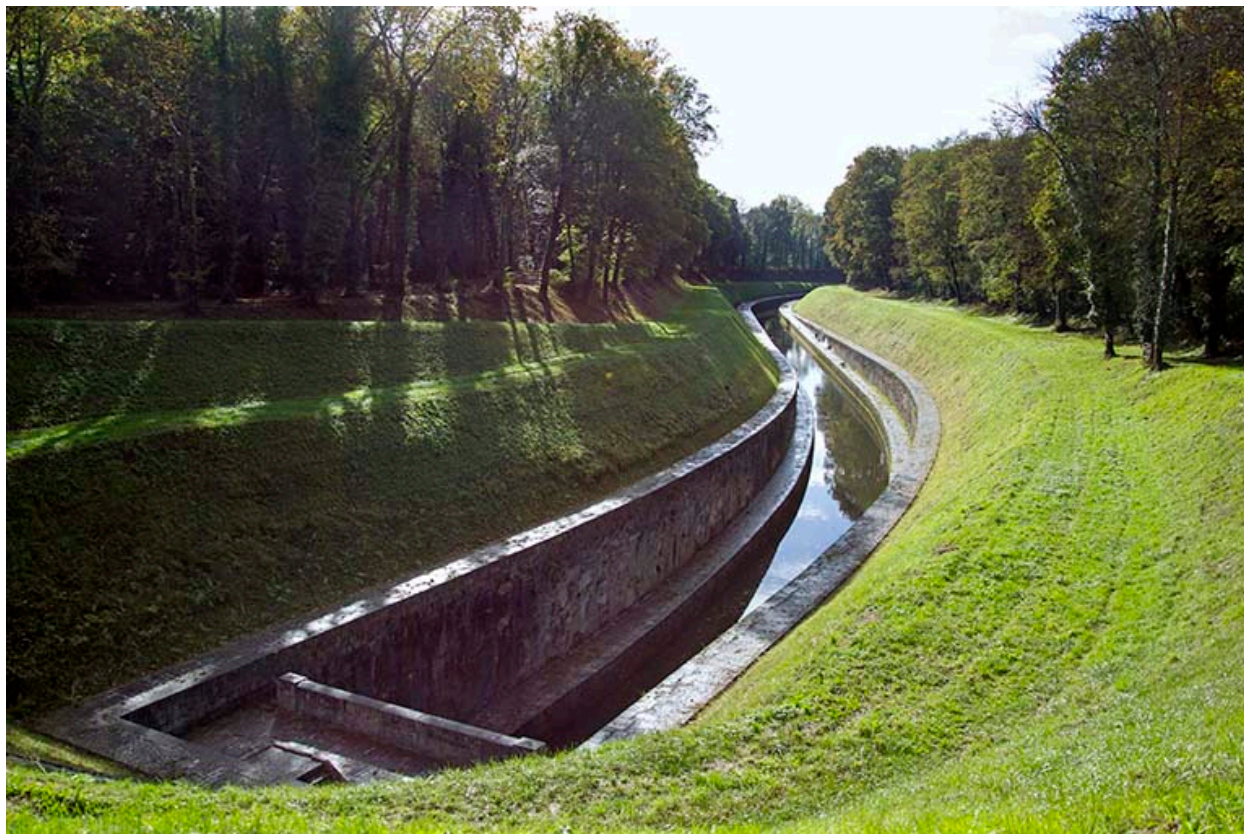
Le canal de navigation en aval.
