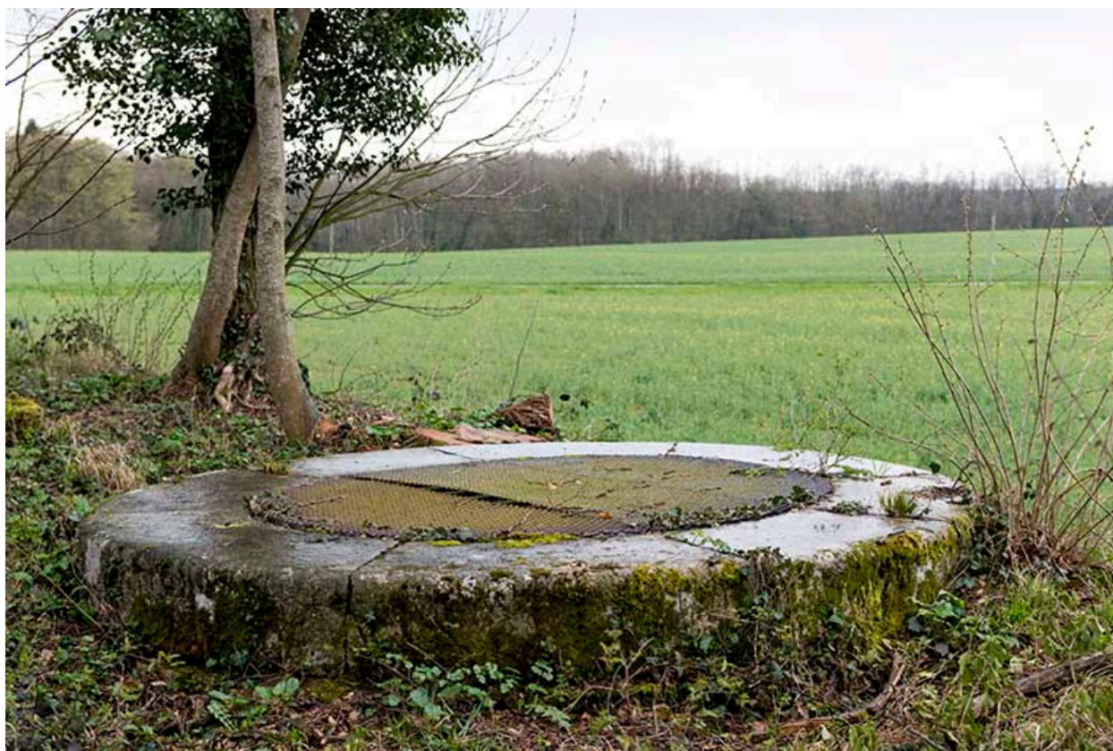
Dernier puits existant.
