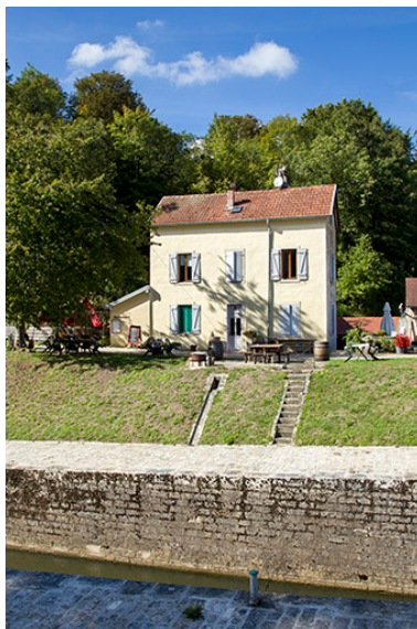
La maison du barragiste. Phot. Sonia Dourlot IVR43_20157001002NUC2A
