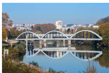
Vue d'ensemble depuis l'aval en 2013. Phot. Mary Ruffinoni IVR43_20132502710NUC4A
