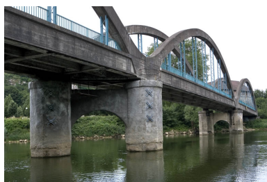
Face aval depuis la rive droite. Phot. Yves Sancey IVR43_20062500308NUCA
