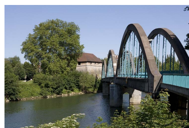
Face amont depuis la rive droite. Phot. Yves Sancey IVR43_20062500166NUCA
