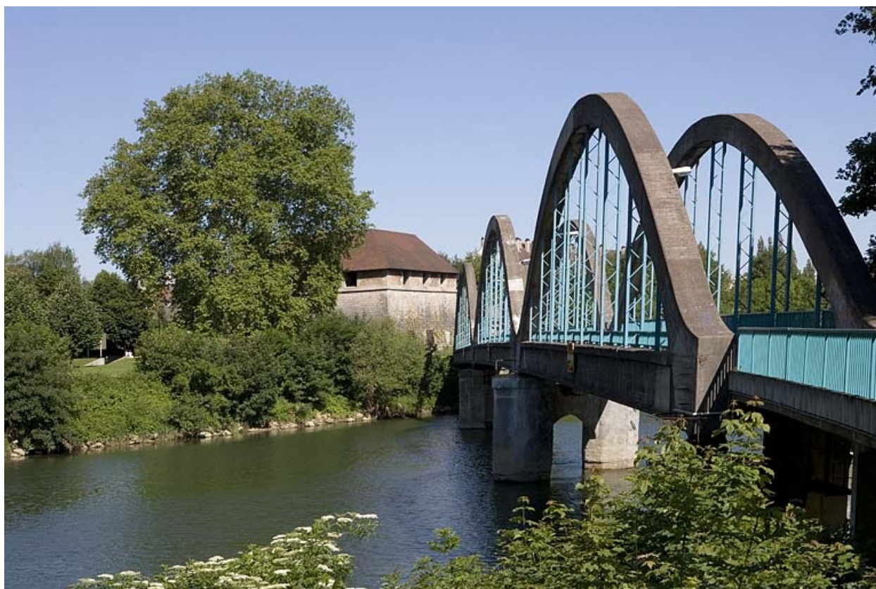
Face amont depuis la rive droite.
