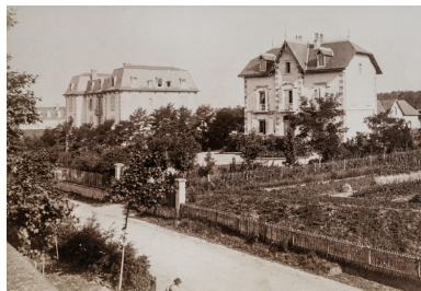
Situation de l'hôtel (à gauche) près de la Villa Beau Site (à droite).
