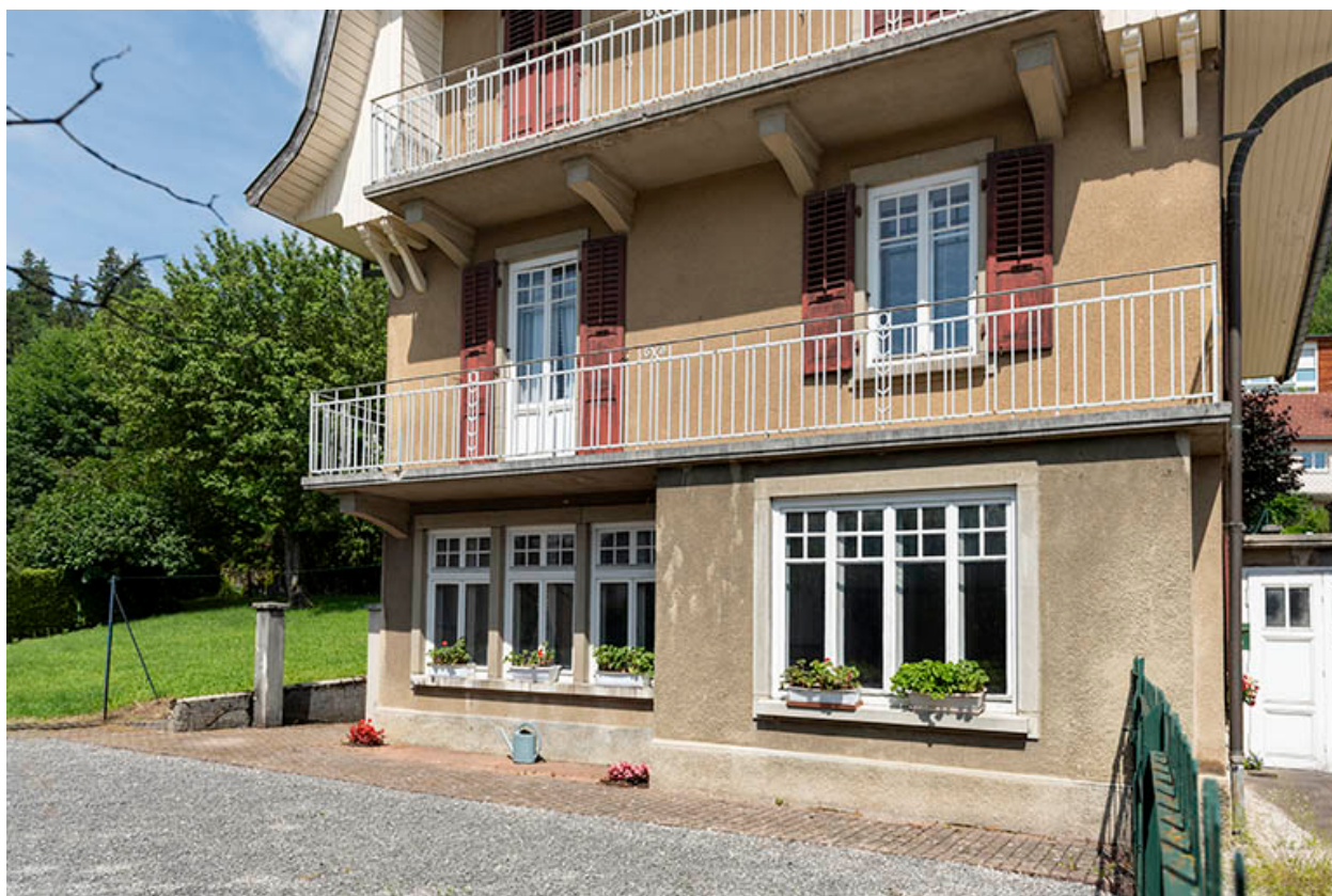
Façade antérieure : rez-de-chaussée et 1er étage.
