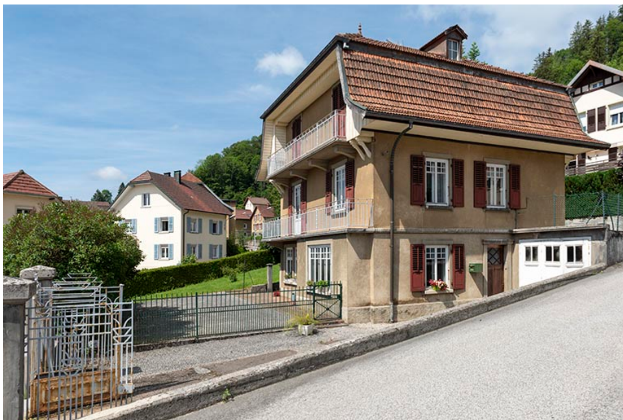
Façade latérale droite, de trois quarts gauche.
