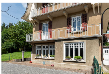
Façade antérieure : rez- de-chaussée et 1er étage. Phot. Sonia Dourlot IVR43_20182501037NUC4A
