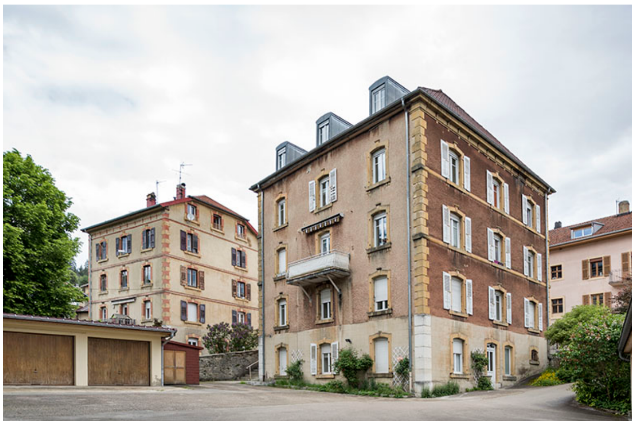
Façades postérieure et latérale gauche.
