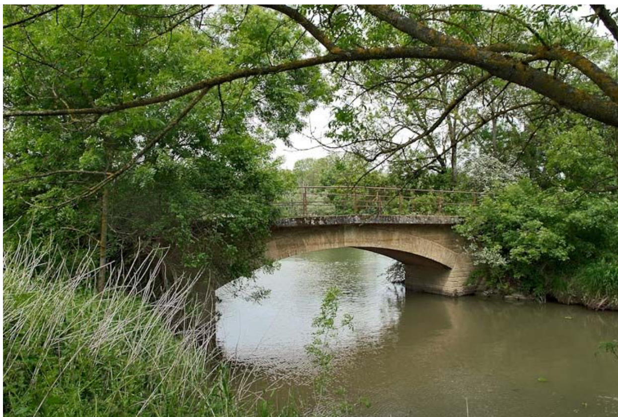
Vue d'ensemble du pont.
