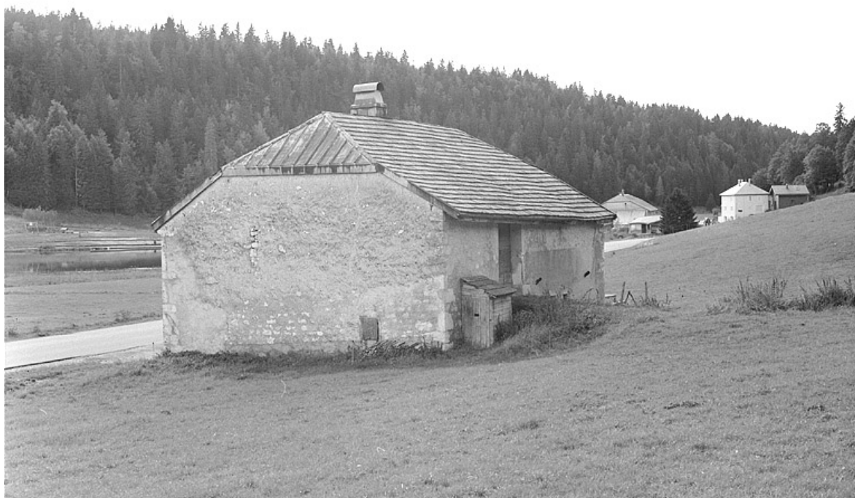
Façade postérieure et face nord-est.
