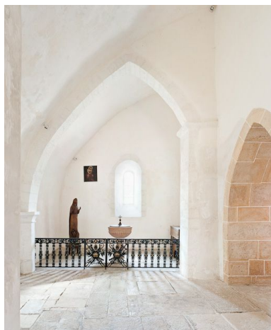
Chapelle des fonts baptismaux et sa clôture. Phot. Pierre-Marie Barbe-Richaud IVR26_20112100383NUC2AQ
