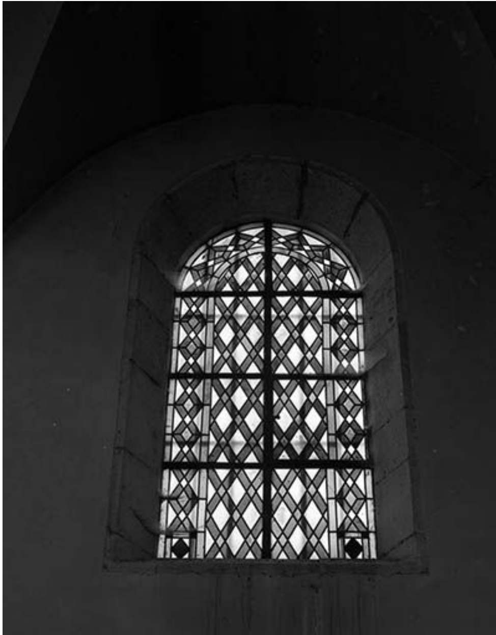
Vue générale de la baie n° 101.
