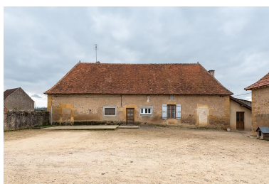
Vue de la façade antérieure de la maison Phot. Pierre-Marie Barbe-Richaud IVR26_20197100749NUC4A
