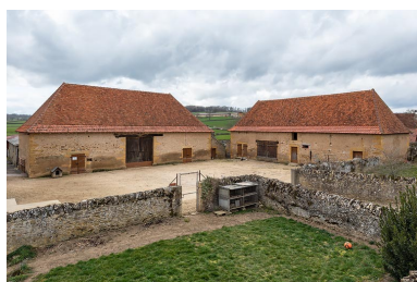
Vue de la grange, à l'ouest, et de la seconde dépendance, au nord de la cour Phot. Pierre-Marie Barbe-Richaud IVR26_20197100751NUC4A
