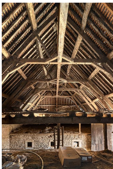
Charpente et fenil de la grange Phot. Pierre-Marie Barbe-Richaud IVR26_20197100754NUC4A
