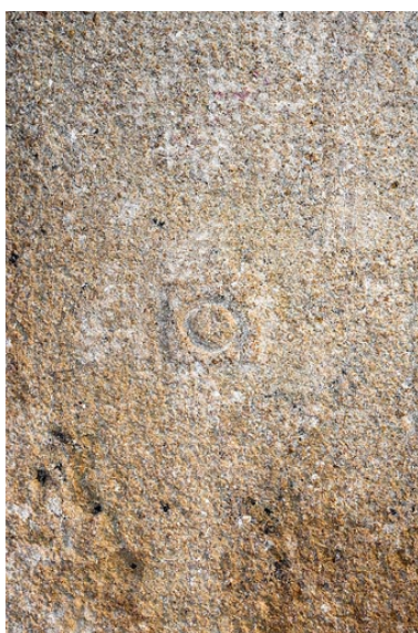
Pierre avec marque de tâcheron dans l'encadrement d'une porte, à l'intérieur de la maison Phot. Pierre-Marie Barbe-Richaud IVR26_20197100757NUC4A
