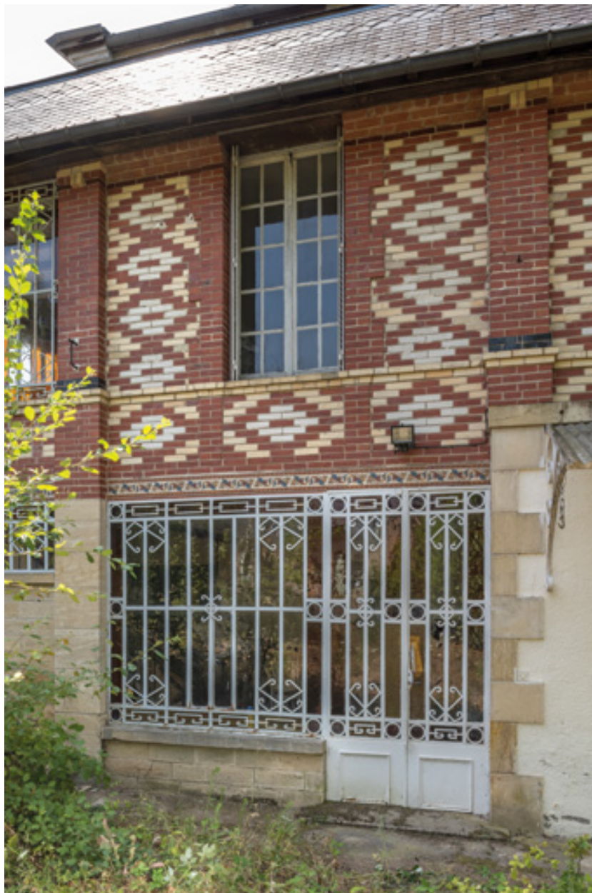
Élévation de l'extension en brique, côté nord.
