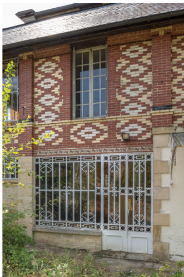
Élévation de l'extension en brique, côté nord. Phot. Pierre-Marie Barbe-Richaud IVR26_20195800526NUC4A
