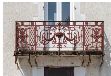
Balcon de la travée centrale de la partie sud, vue de face. Phot. Pierre-Marie Barbe-Richaud IVR26_20195800525NUC4A
