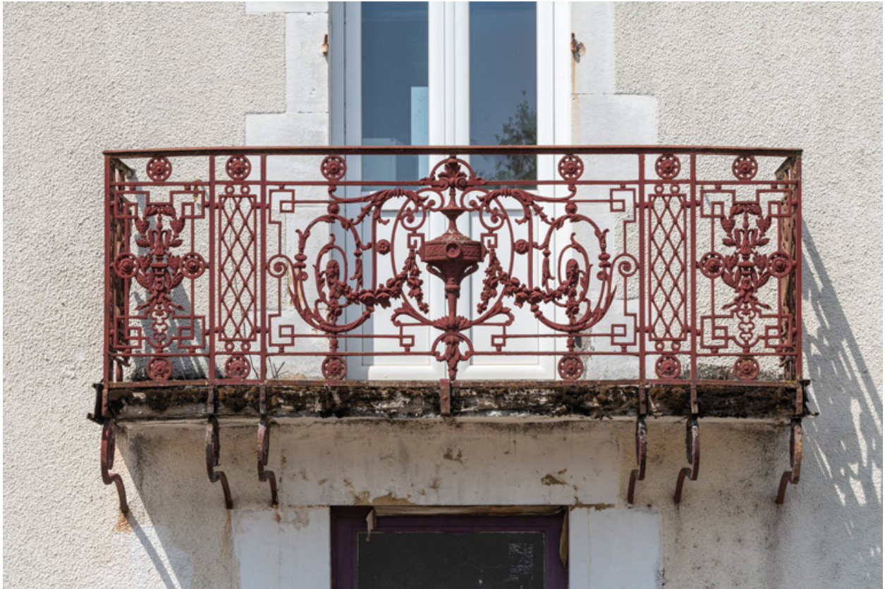
Balcon de la travée centrale de la partie sud, vue de face.
