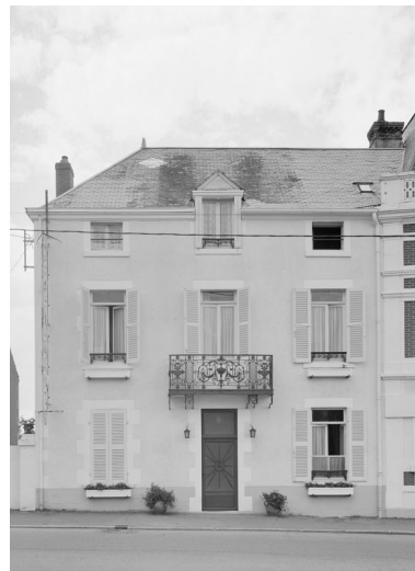
Façade sur l'actuelle avenue du Général d'Espeuilles, partie sud, en 1978. Phot. Michel Rosso IVR26_19785800229V
