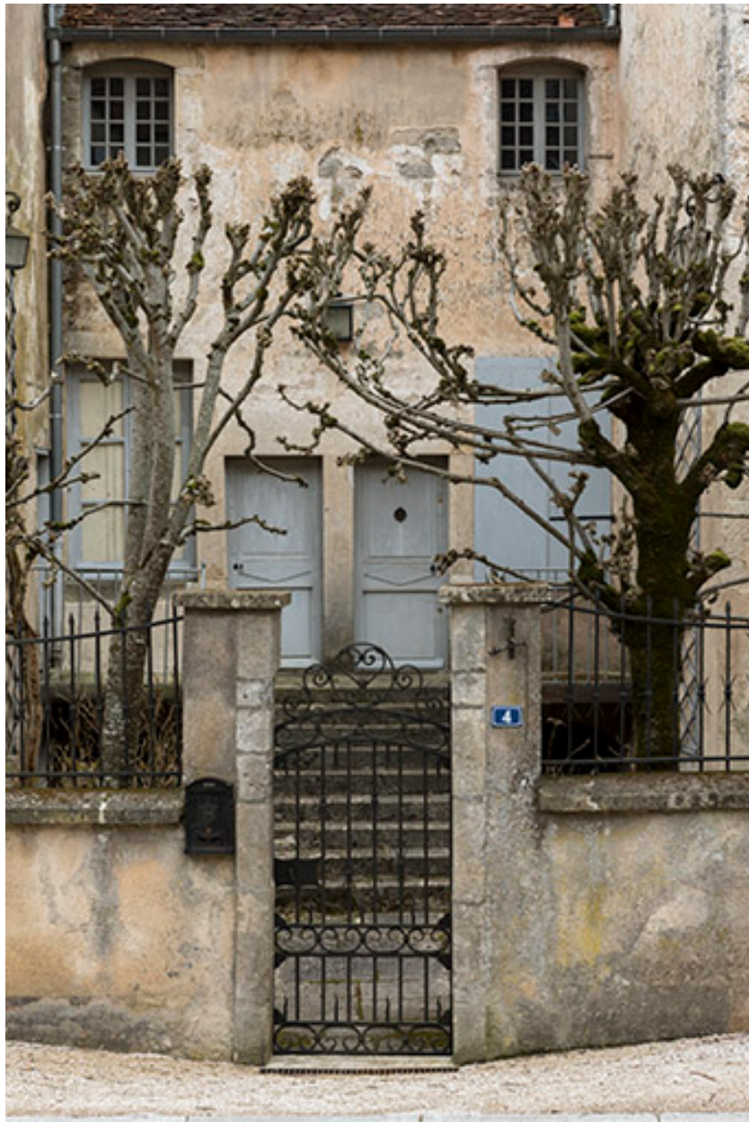
Façade antérieure : travées centrales.
