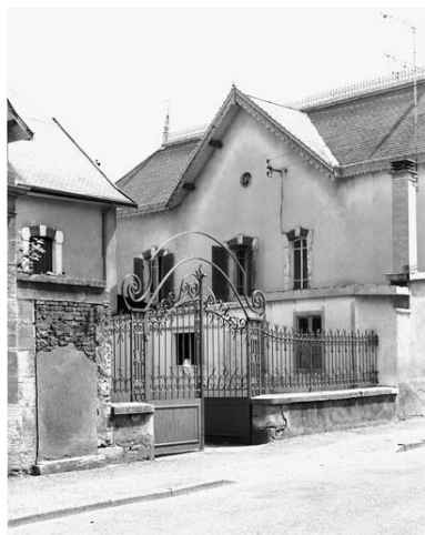
Détail de la clôture de la cour. Phot. Yves Sancey IVR43_19897000387V
