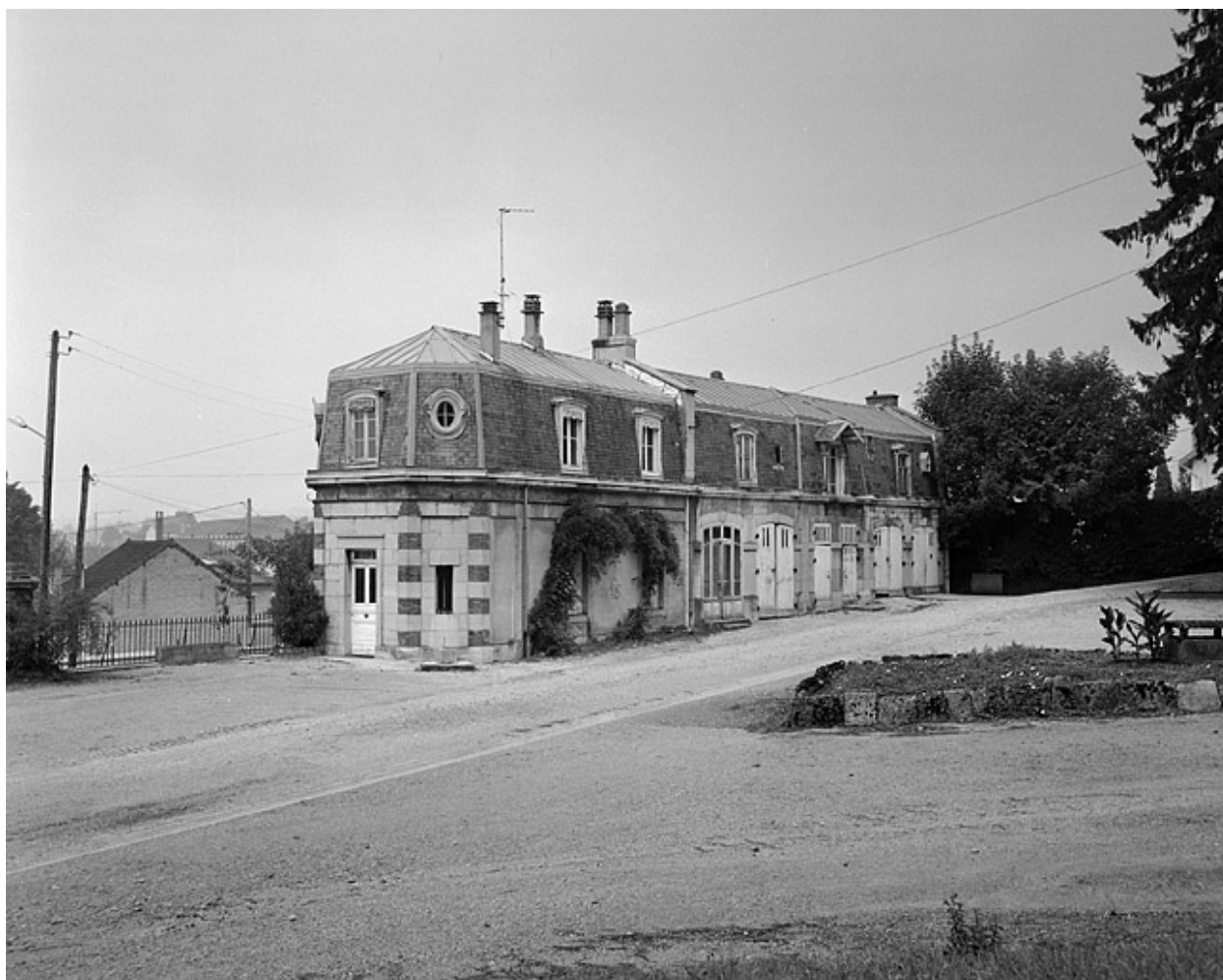
Bureau, logement et chai est.
