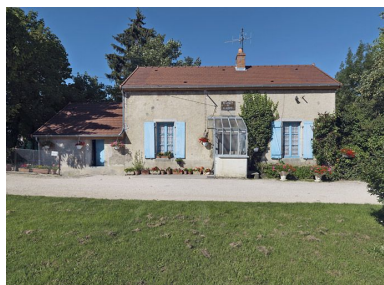
Vue de face. Phot. Thierry Kuntz IVR26_20112103164NUC4A
