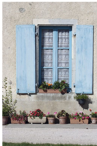
Détail d'une fenêtre. Phot. Thierry Kuntz IVR26_20112103169NUC2A
