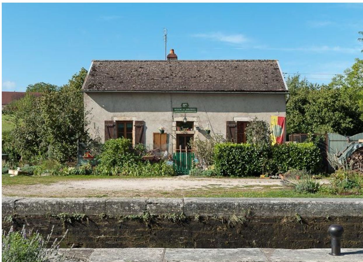
Vue de face de la maison éclusière.
