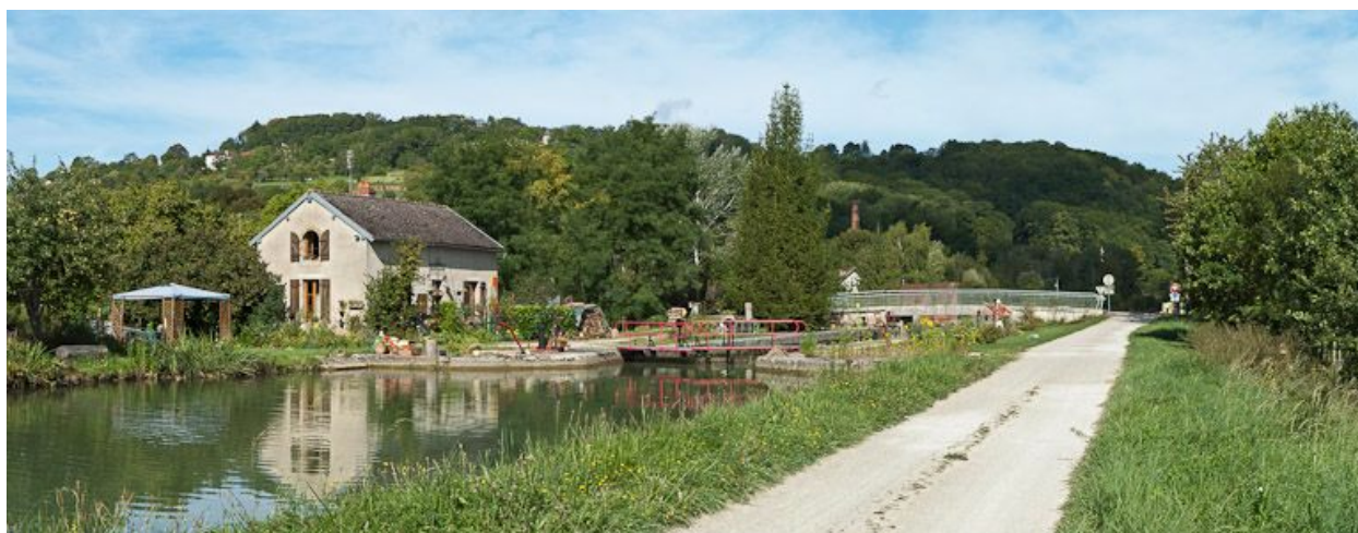
Vue du site d'écluse depuis l'amont.
