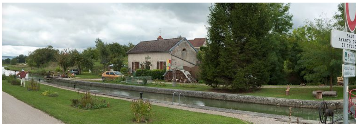
Vue d'ensemble du site d'écluse.
