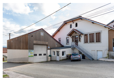
Garage, boutique et fromagerie. Phot. Sonia Dourlot IVR43_20192500926NUC4A
