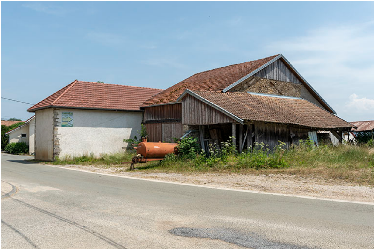
Cave d'affinage (façade postérieure), grange et hangar.
