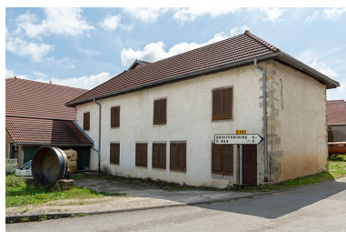
Cave d'affinage (ancienne école). Phot. Sonia Dourlot IVR43_20192500927NUC4A
