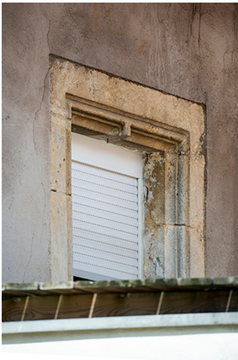
Ancienne maison : fenêtre à meneau (à l'étage).
