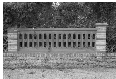
Mur de clôture constitué d'éléments en céramique produits par les établissements Perrusson & Desfontaines (73-74 route du Canal). Phot. Frédéric Pillet IVR26_19997100795Z
