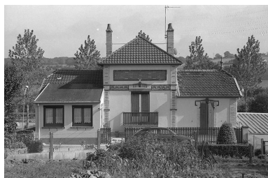
Façade postérieure (rue J.- B. Perrusson) de l'ancienne boulangerie-épicerie coopérative (façade de l'épicerie). Phot. Frédéric Pillet IVR26_19997100802Z
