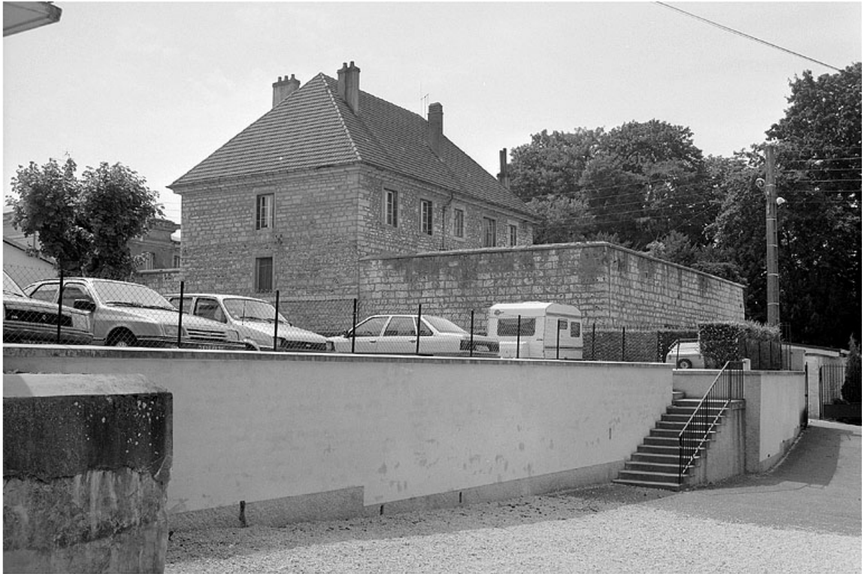
Façades postérieure et latérale droite.
