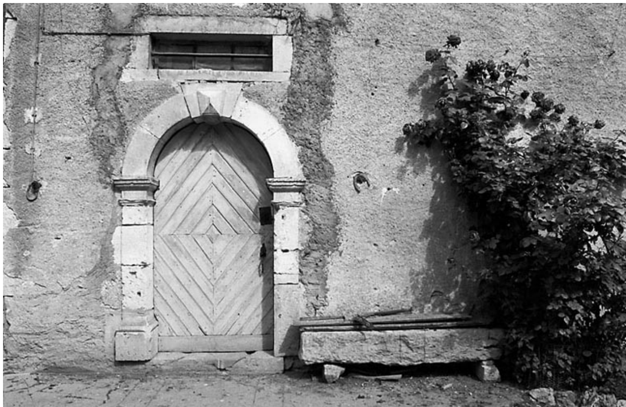
Entrée de l'habitation.
