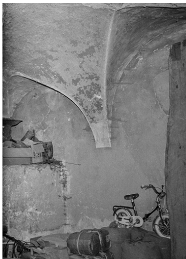
Intérieur : cuisine voûtée d'arêtes. Phot. Bernard Lardière IVR43_19817000860Z
