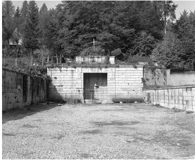
Vue générale. Phot. Bernard Lardière IVR43_19797000157X
