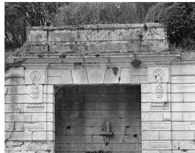
Partie supérieure du buffet d'eau. Phot. Yves Sancey IVR43_19827000462X
