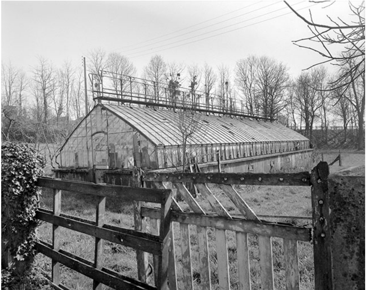
Vue d'ensemble de la serre.
