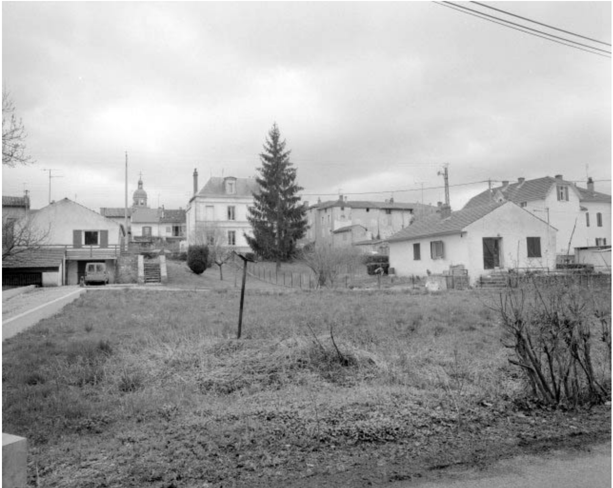
Vue d'ensemble des logements d'ouvriers, depuis l'ouest. Maison de 1956 à gauche, de 1959 à droite.
