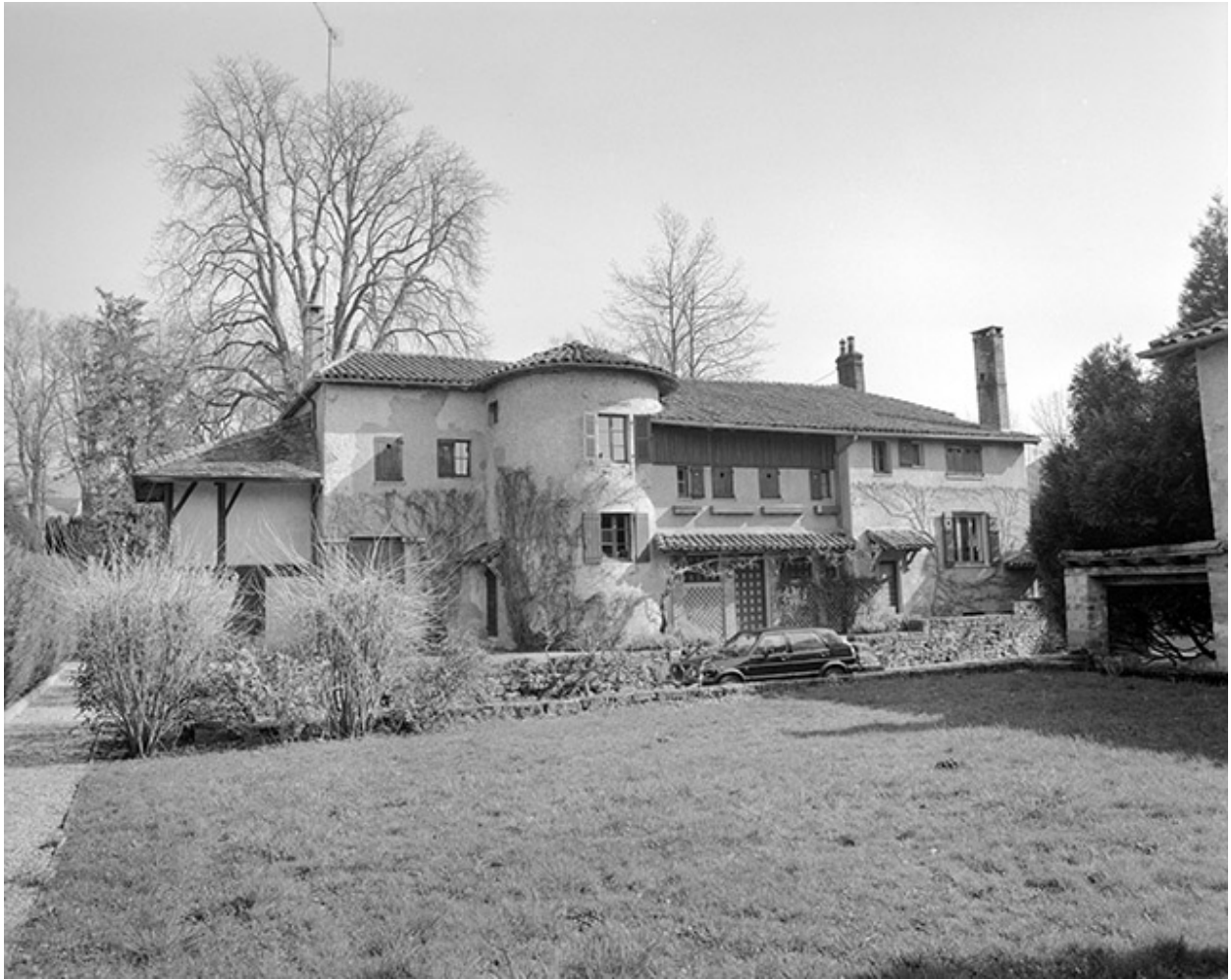
Façade antérieure du logement patronal (O).
