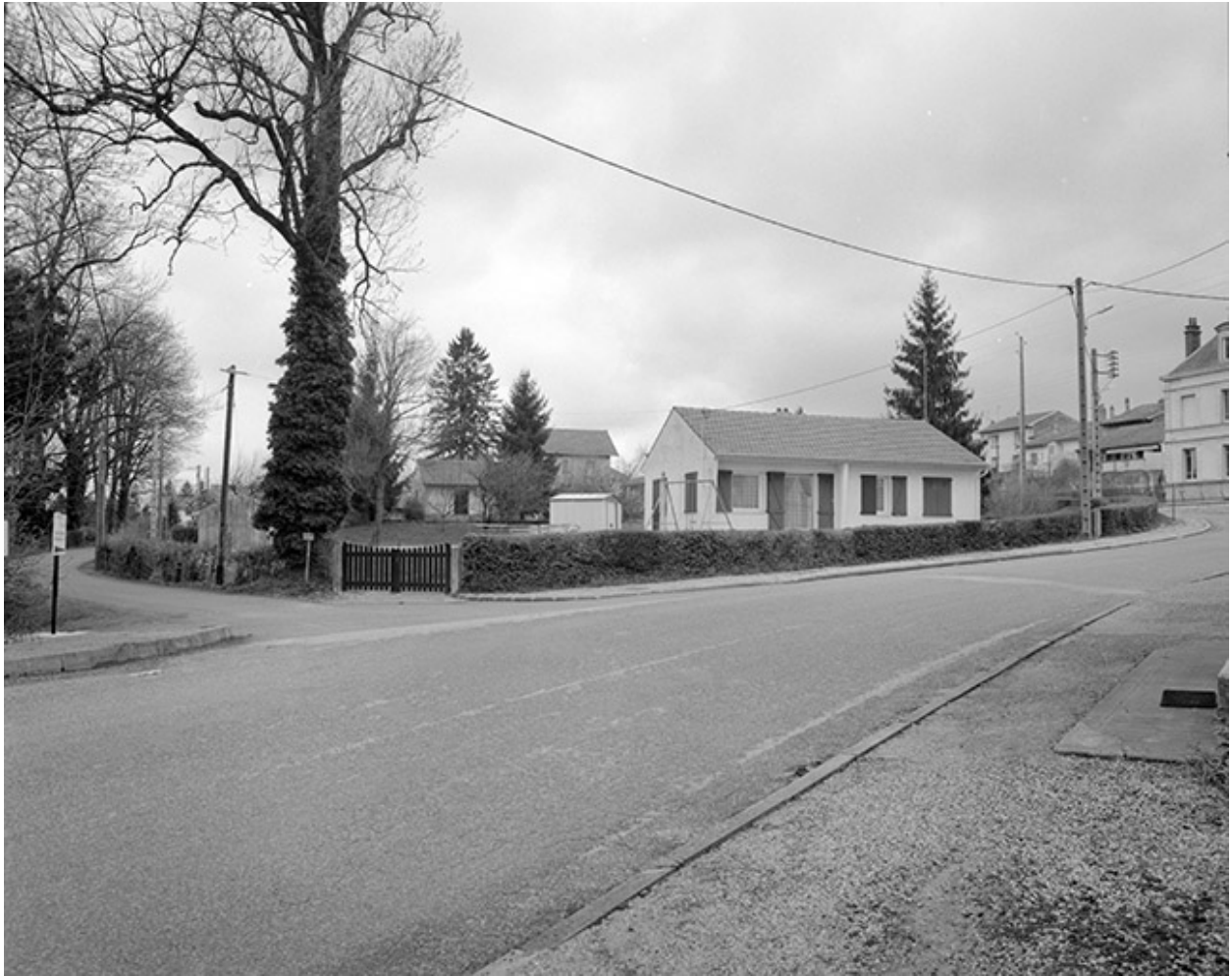
Vue d'ensemble des logements d'ouvriers, depuis le sud.
