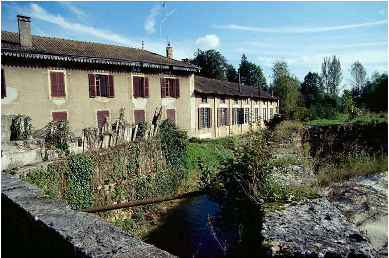
Logement patronal (H) et atelier des marbriers.
