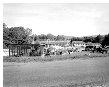
Vue d'ensemble depuis l'ouest. Phot. Yves Sancey IVR43_19933900244X
