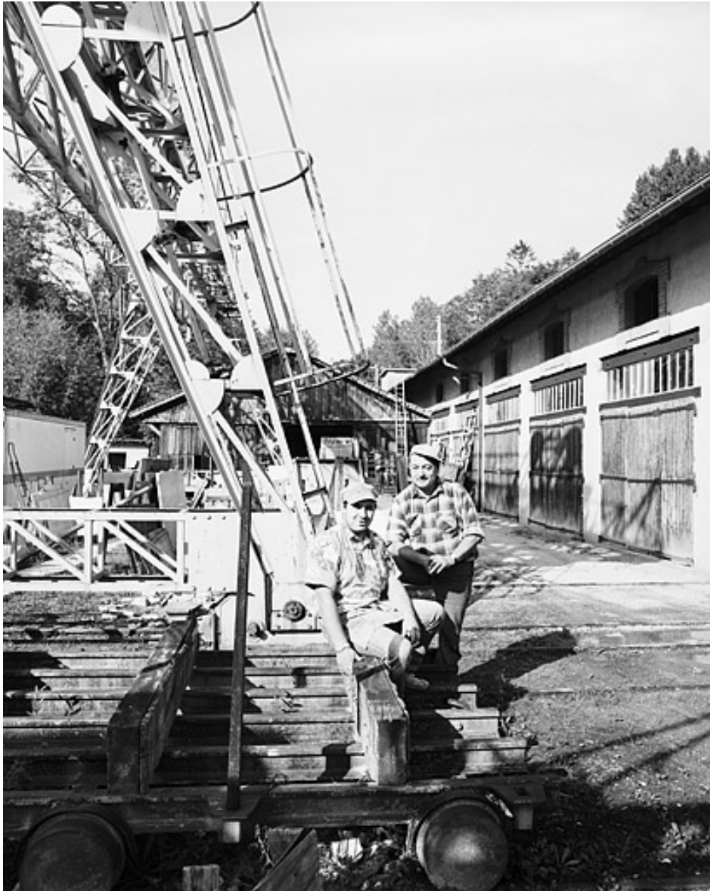
Ouvriers au pied du portique roulant.
