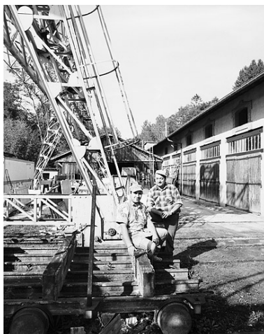
Ouvriers au pied du portique roulant. Phot. Yves Sancey IVR43_19933900324X
