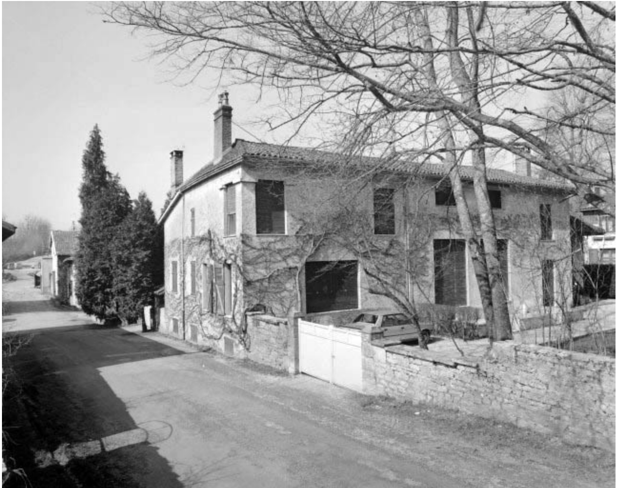
Façades latérale gauche et postérieure du logement patronal (O).
