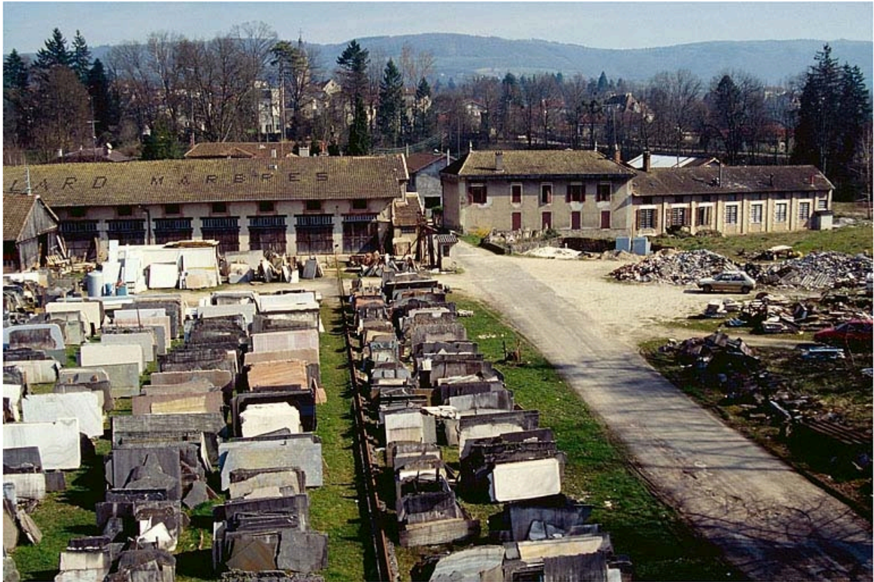
Vue d'ensemble : aire des matières premières et ateliers de fabrication.
