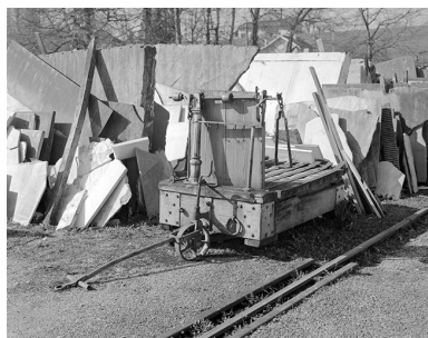
Bascule de chantier mobile. Phot. Yves Sancey IVR43_19943901336X
