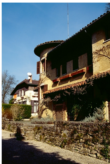
Façades antérieures des logements patronaux (O, P). Phot. Yves Sancey IVR43_19943901340ZA
