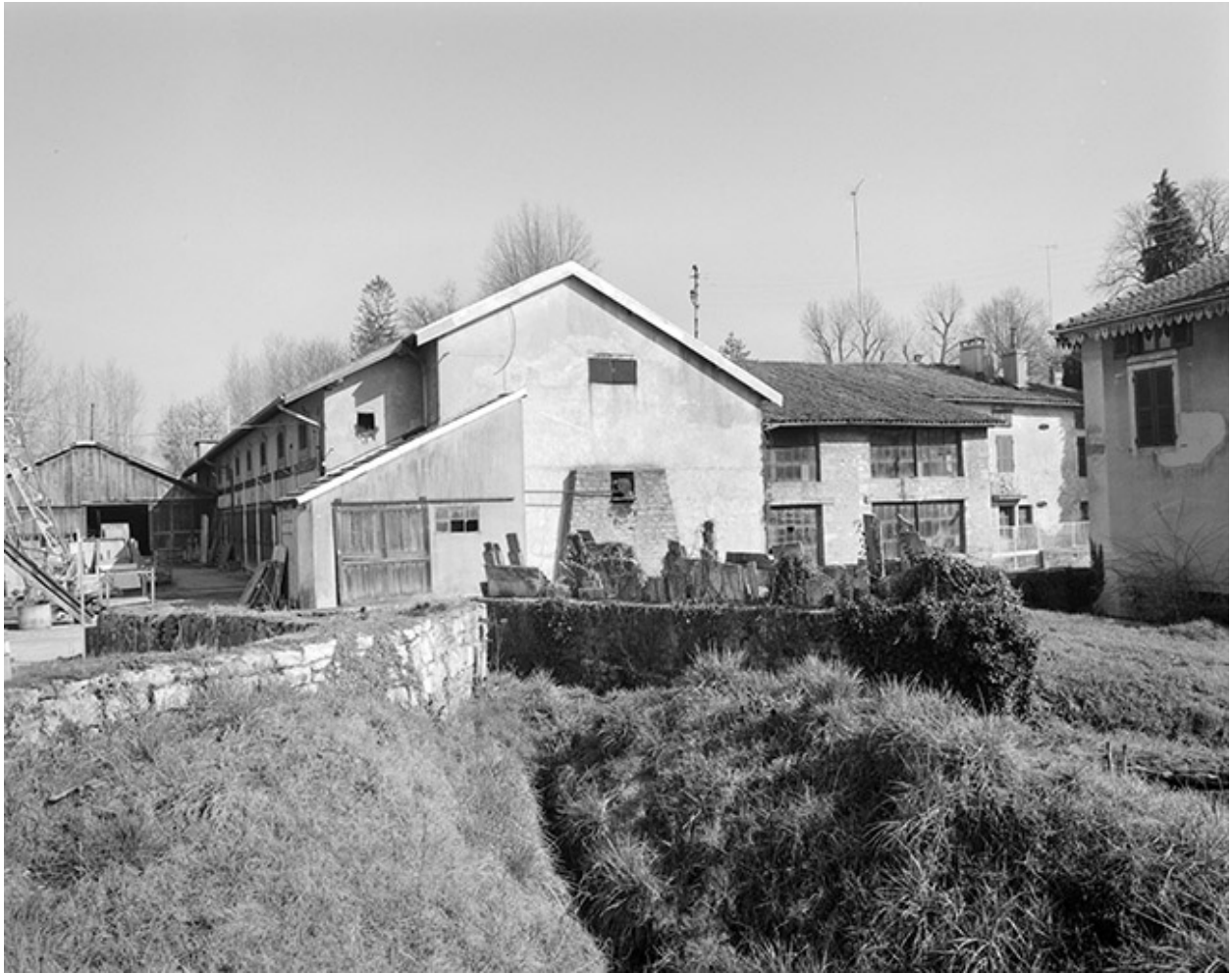
Mur pignon sud de la scierie (abri de la noria) et atelier de réparation.
