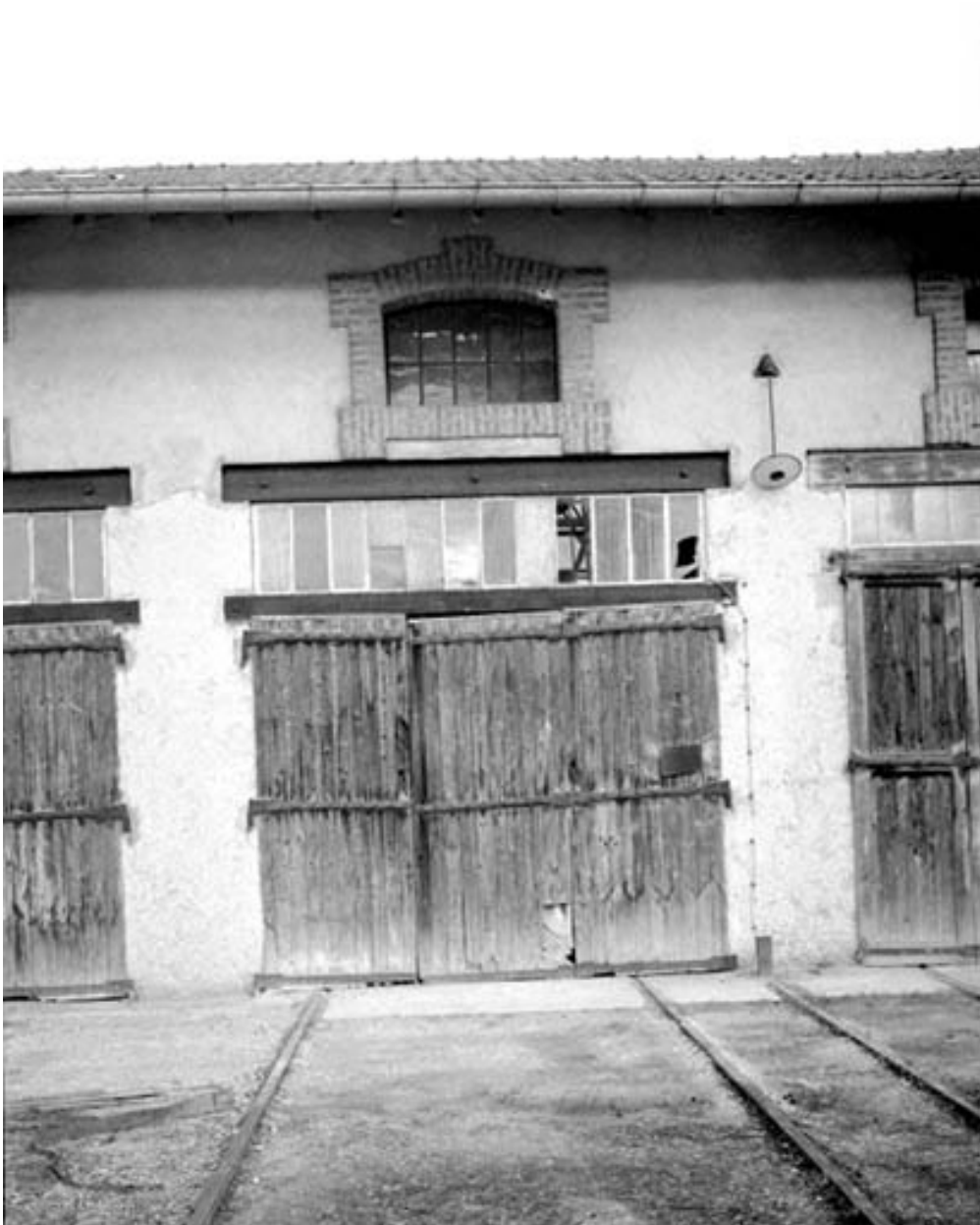
Détail d'une travée de la scierie.
