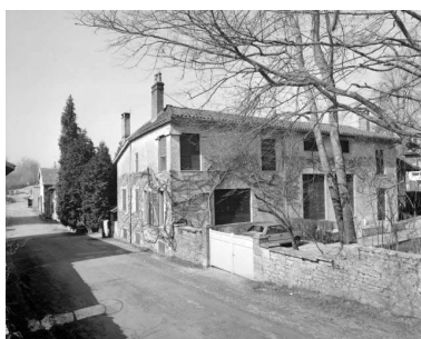
Façades latérale gauche et postérieure du logement patronal (O). Phot. Yves Sancey IVR43_19943901341X
