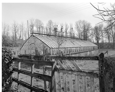
Vue d'ensemble de la serre. Phot. Yves Sancey IVR43_19943901343X
