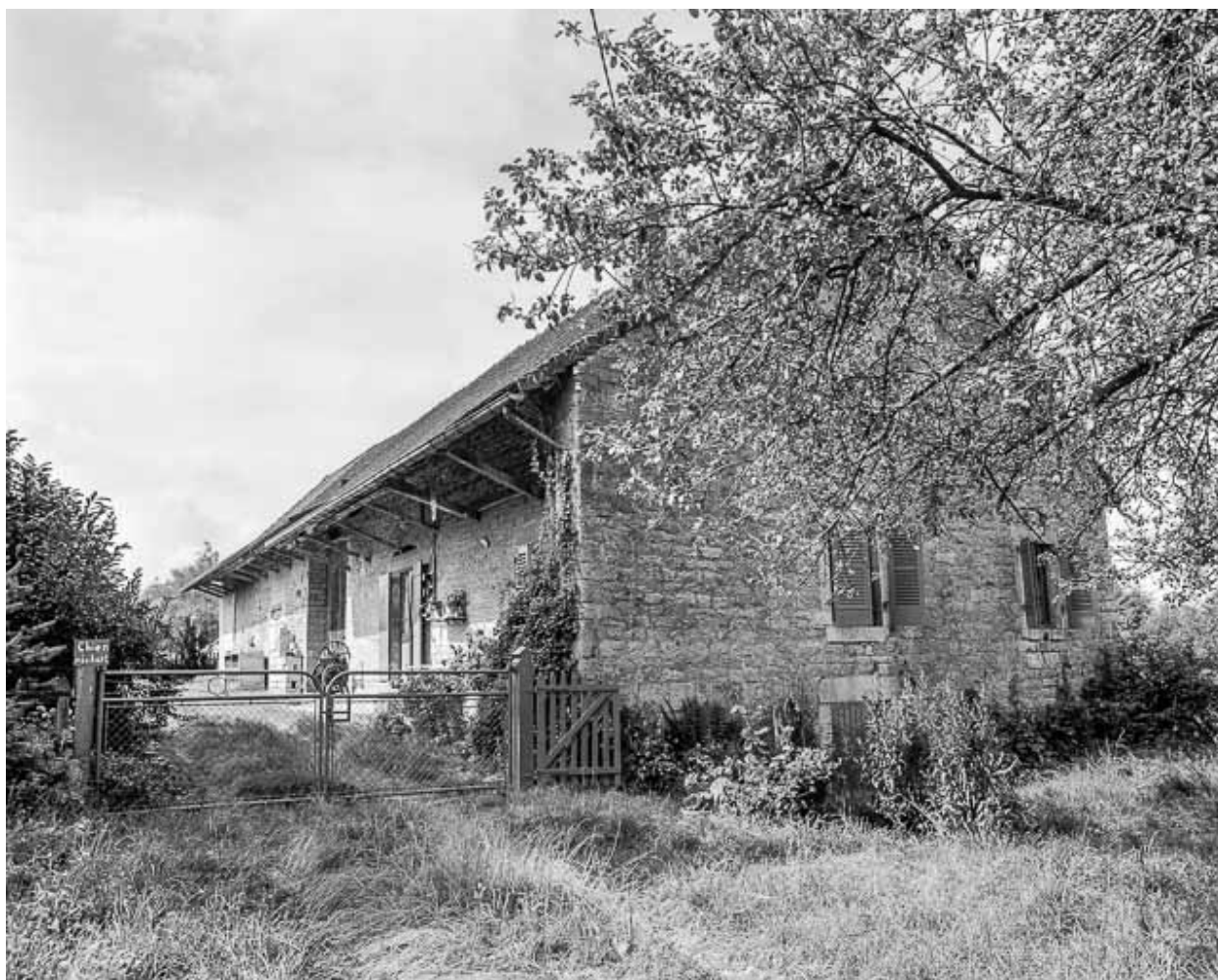
Façade antérieure et pignon droit.
