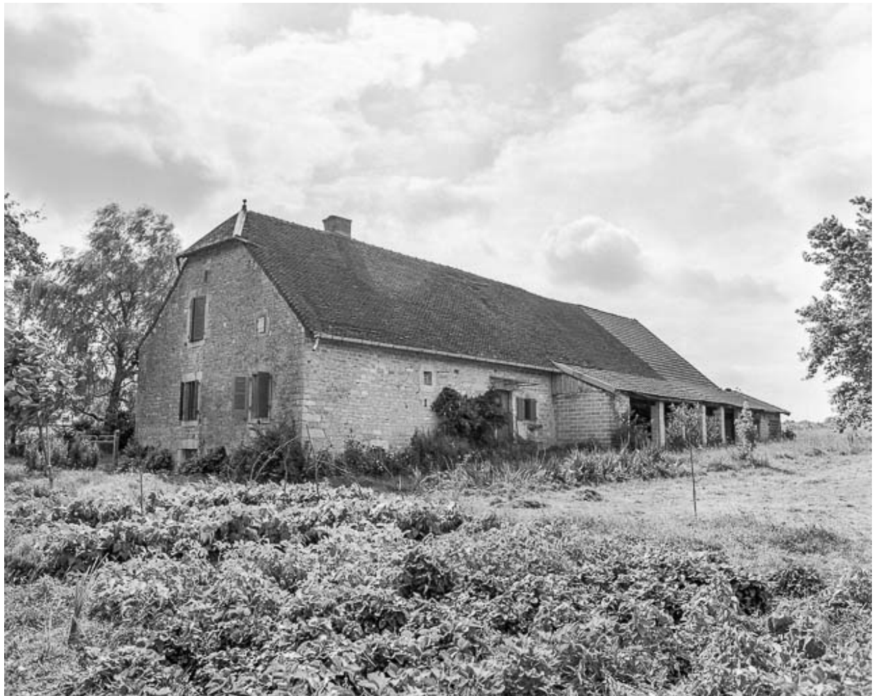
Façade postérieure et pignon droit.
