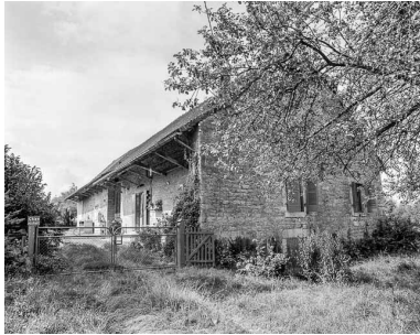
Façade antérieure et pignon droit. Phot. Dominique Dominguez IVR43_19773900084X
