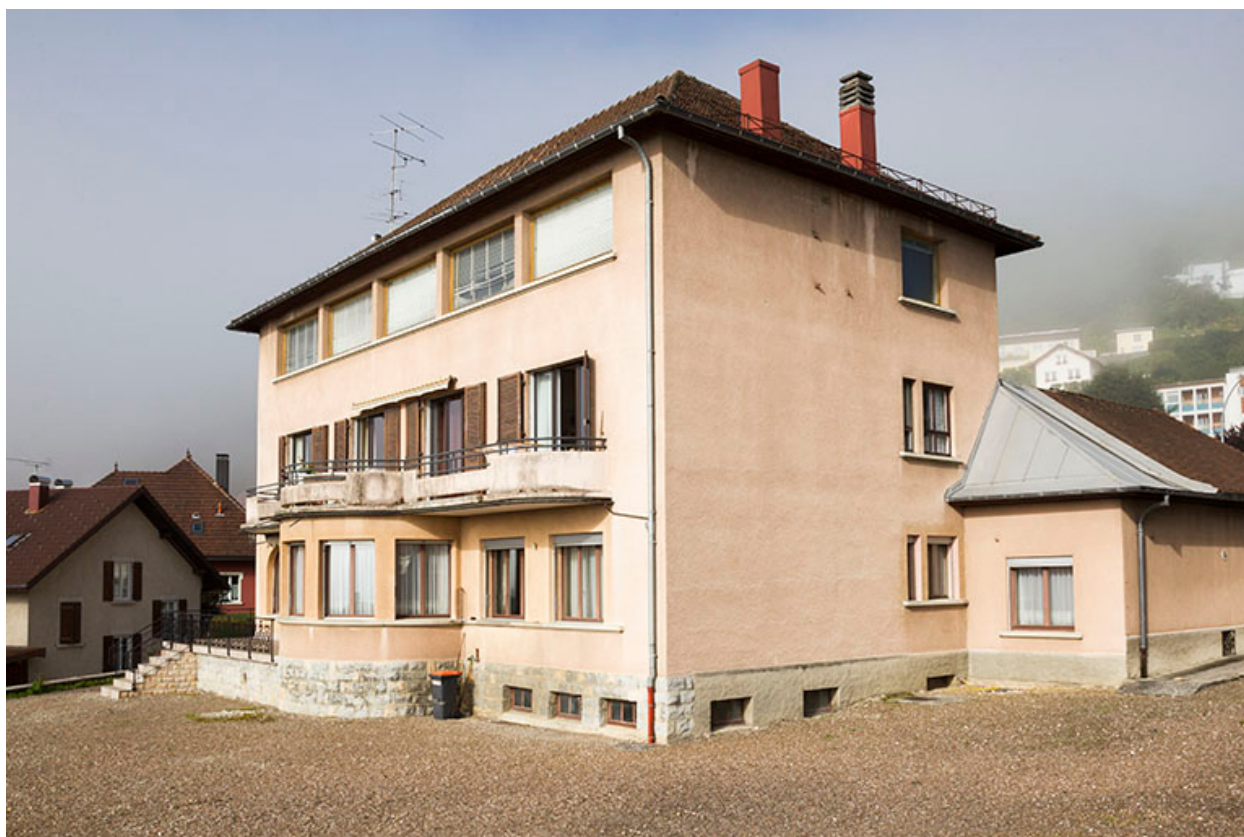
Façades postérieure et latérale gauche.
